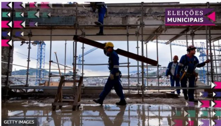
Trabalhadores da construção no Estádio do Maracanã, no Rio
