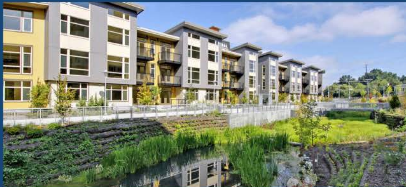
Sistema de drenagem, Seattle, EUA
