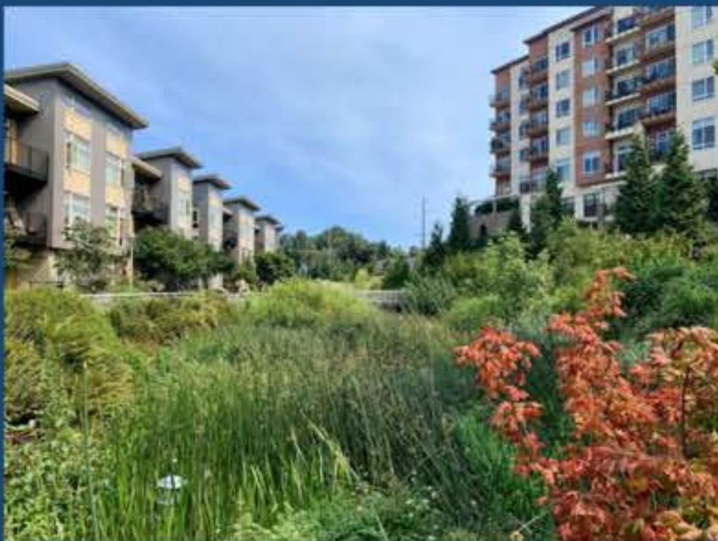
Sistema de drenagem, Seattle, EUA
