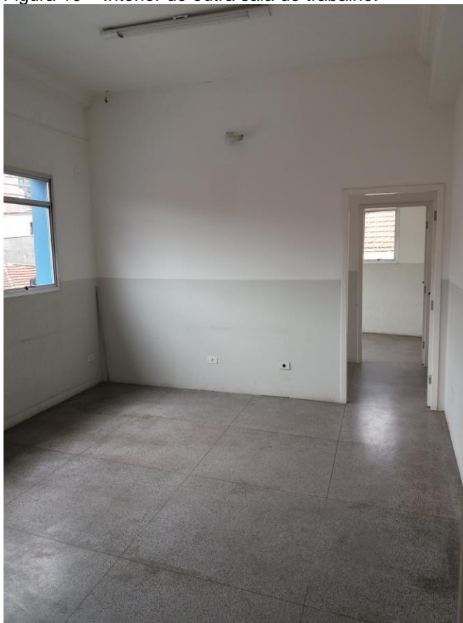
Figura 10 – Interior de outra sala de trabalho.
