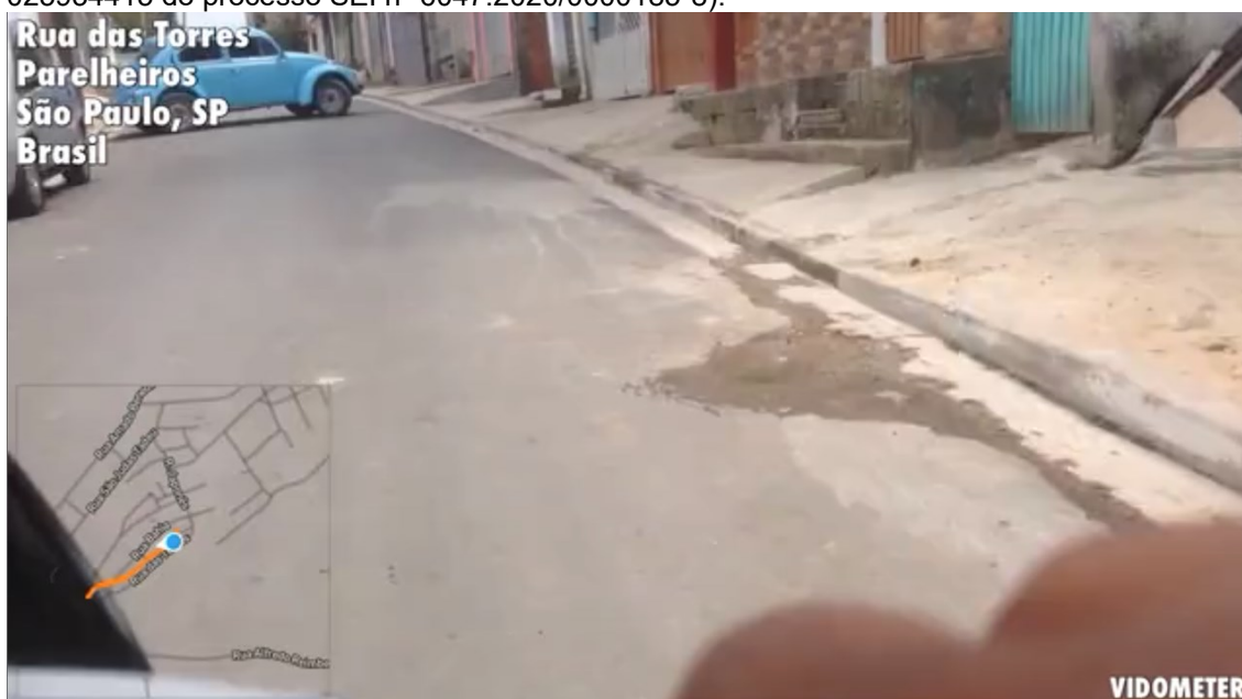
Figura 1 – Imagem da Rua das Torres - Jardim Marcelo (conforme croqui 1: documento SEI nº 025934415 do processo SEI nº 6047.2020/0000185-8).
