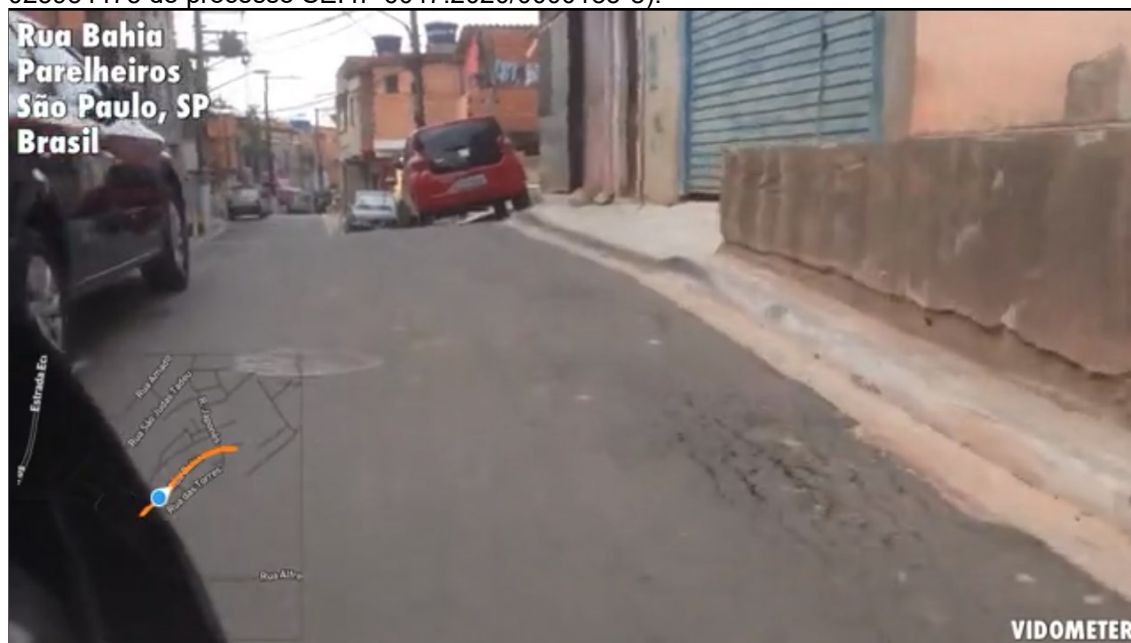
Figura 2 – Imagem da Rua Bahia - Jardim Marcelo (conforme croqui 2: documento SEI nº 025934473 do processo SEI nº 6047.2020/0000185-8).
