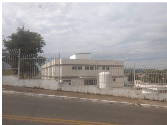
Foto 3 - VISTA FUNDOS Fonte: equipe de Auditoria
