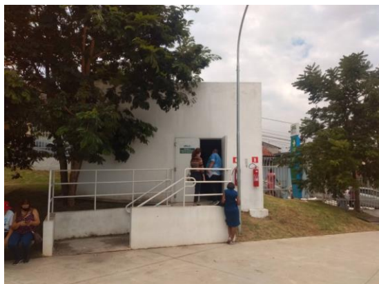
Foto 5 - CABINE PRIMÁRIA DE ENERGIA ELÉTRICA
