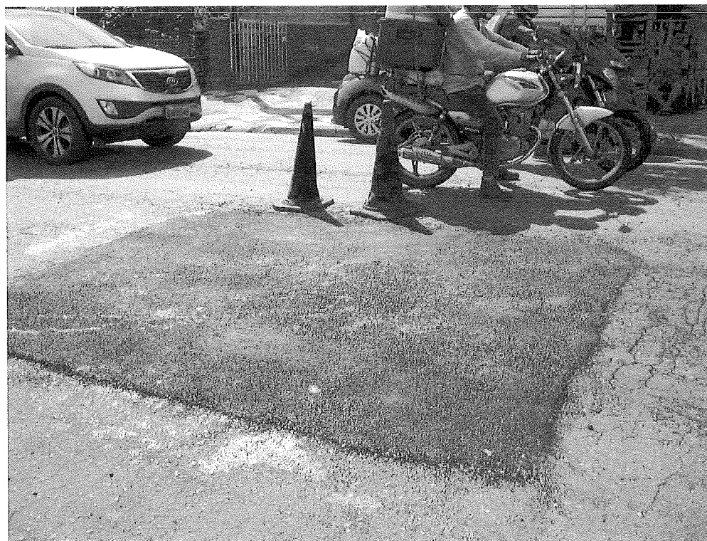
Foto 06 – Serviço concluído (Buraco 1)
