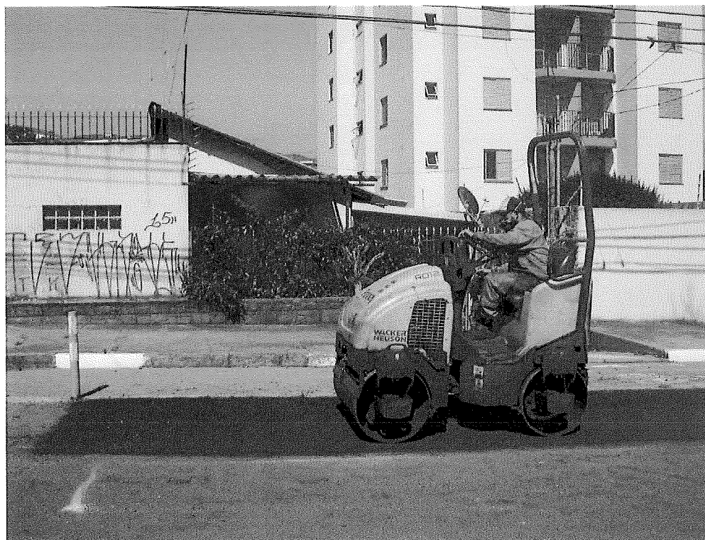
Foto 09 – Compactação com rolo compactador
