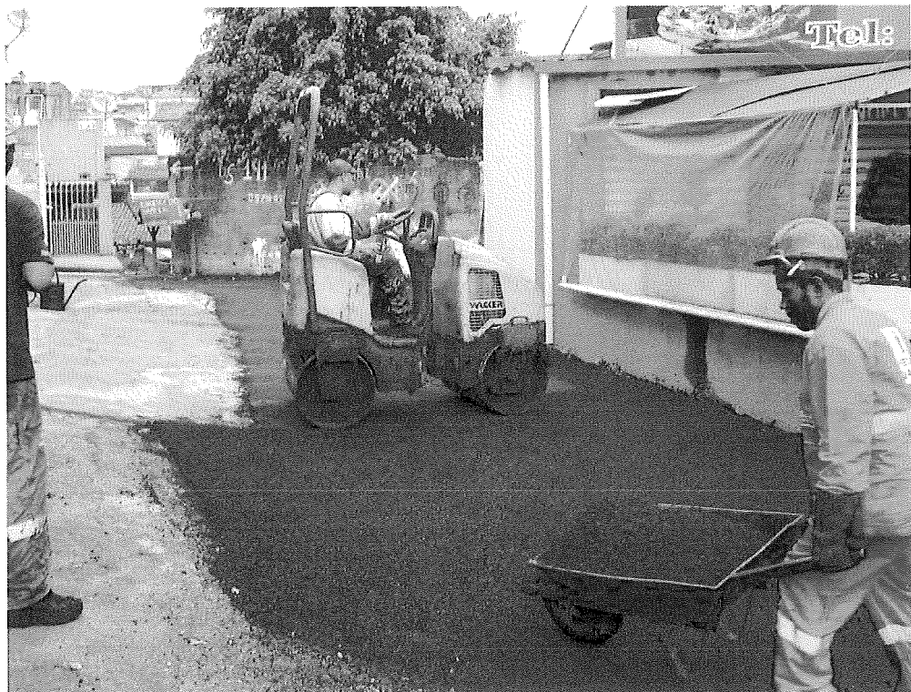
Foto 07 – Compactação com rolo compactador
