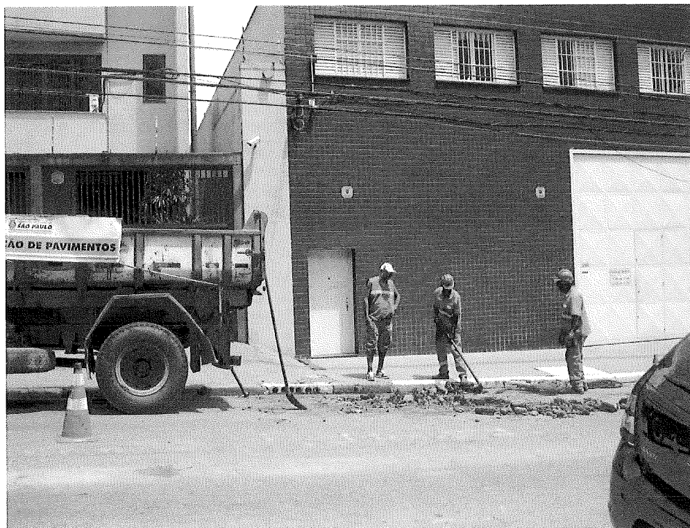
Foto 03 – Requadramento do buraco
