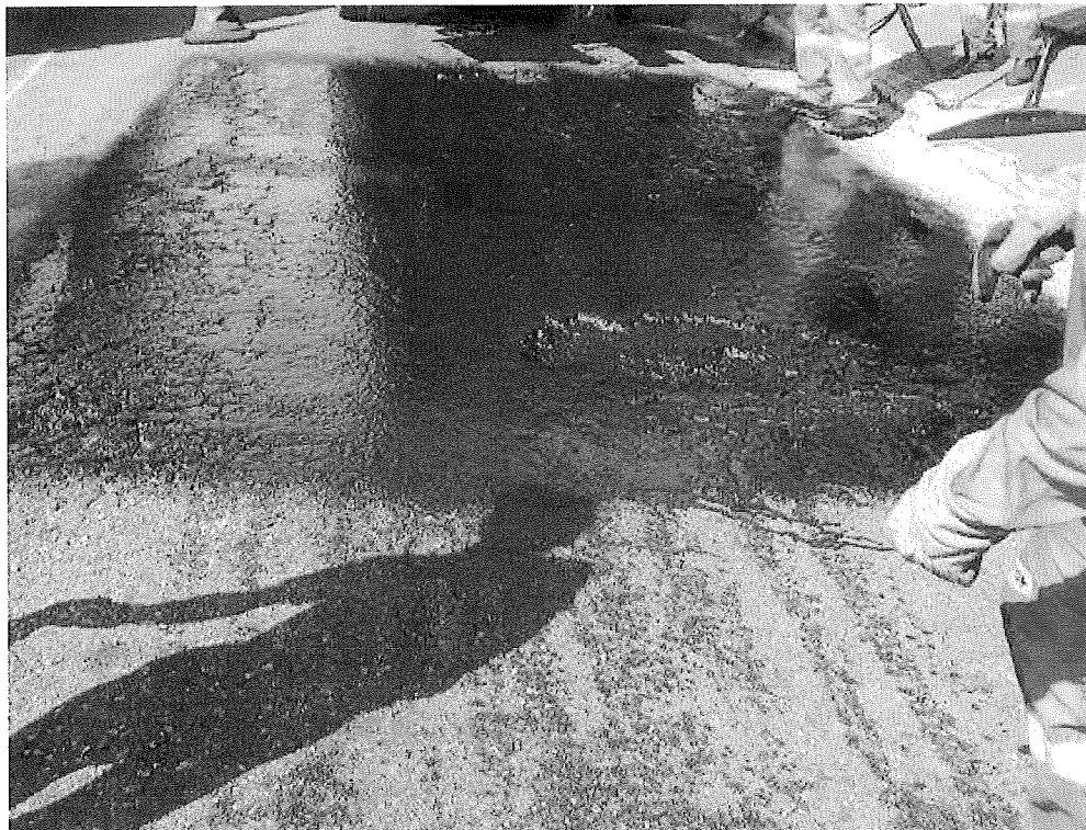
Foto 09 – Aplicação de pintura de ligação sobre o asfalto existente (Buraco 2)
