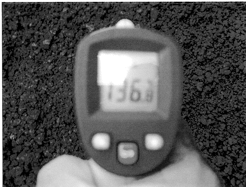
Foto 12 – Medição da temperatura do concreto asfáltico: 136°C
