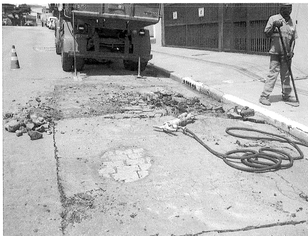
Foto 04 – Requadramento do buraco
