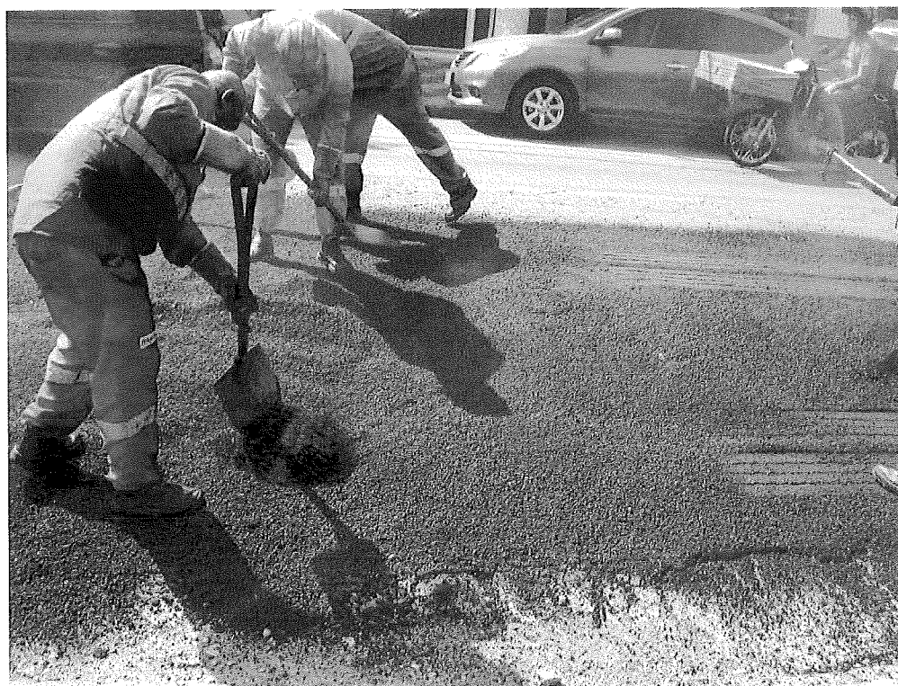
Foto 11 – Aplicação de concreto asfáltico (Buraco 2)
