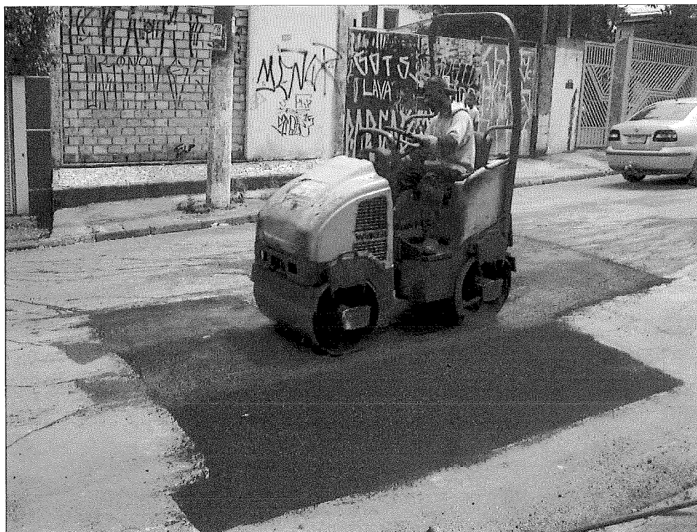
Foto 17 – Compactação com rolo compactador
