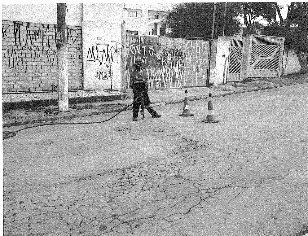
Foto 13 – Pavimento existente antes do início do serviço
