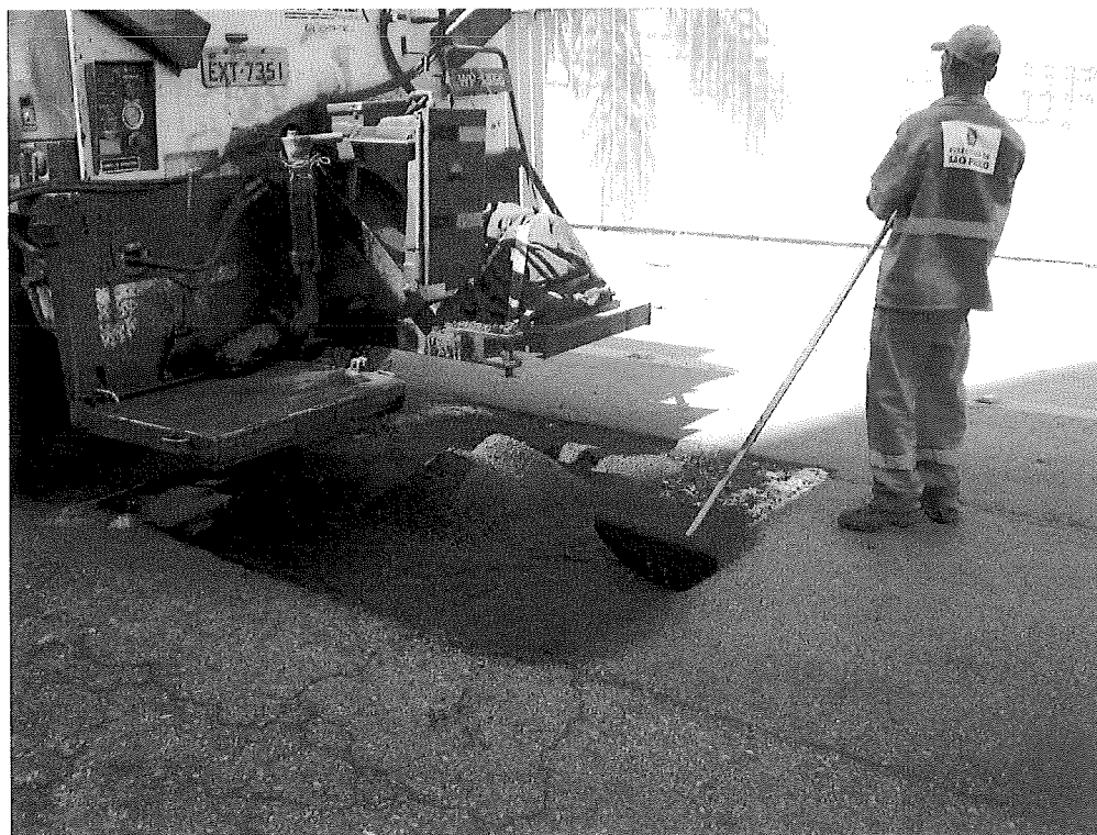
Foto 20 – Aplicação de concreto asfáltico
