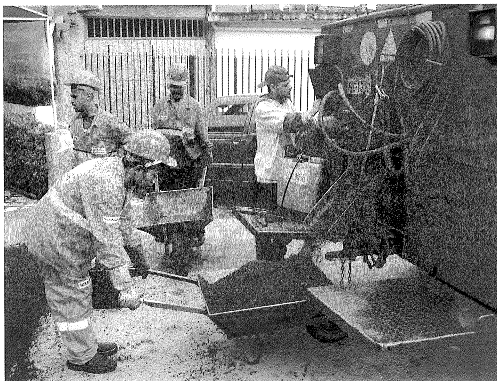
Foto 05 – Aplicação de concreto asfáltico
