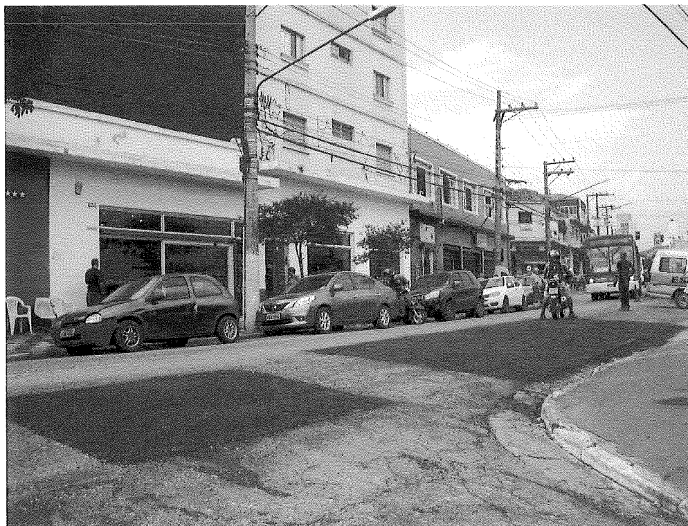
Foto 14 – Serviço concluído (Buracos 1 e 2)
