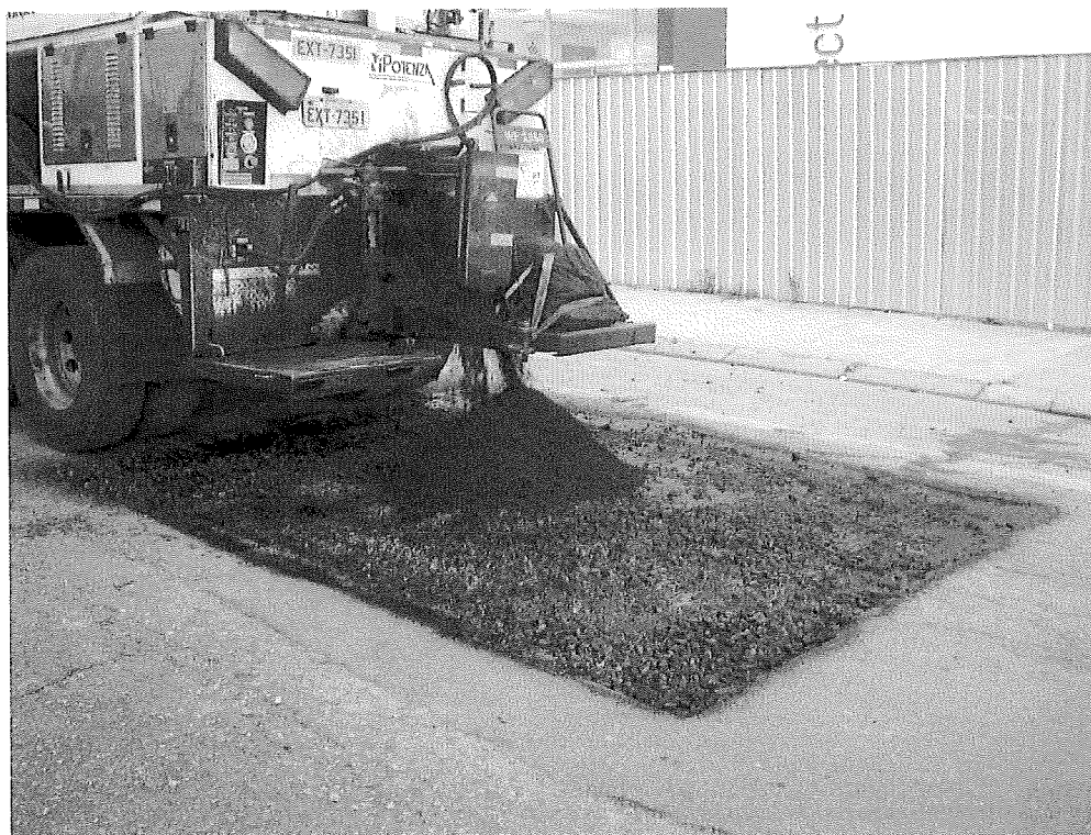
Foto 13 – Aplicação de concreto asfáltico
