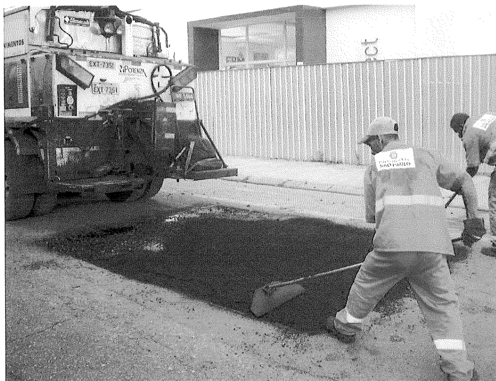
Foto 14 – Aplicação de concreto asfáltico
