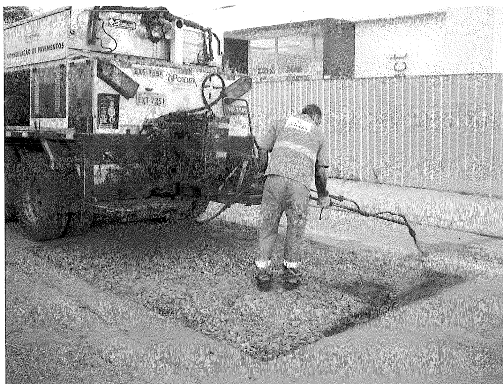
Foto 12 – Execução de pintura de ligação com emulsão
