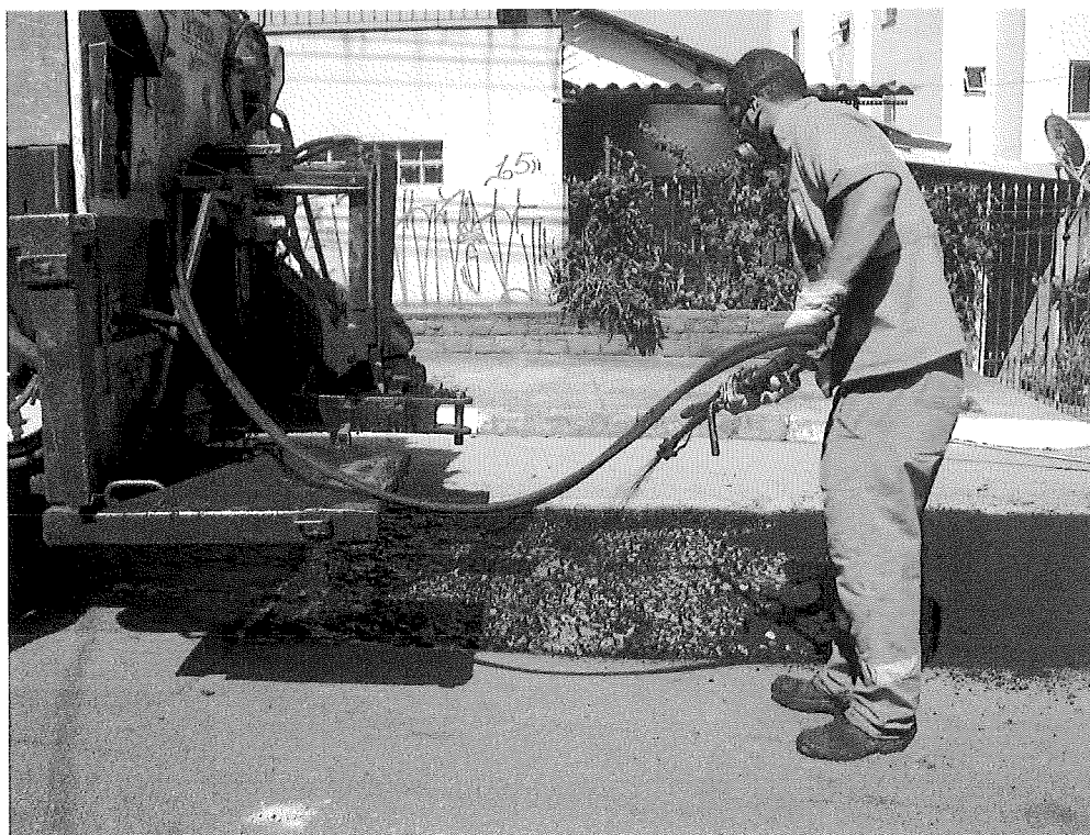
Foto 07 – Execução de pintura de ligação com emulsão
