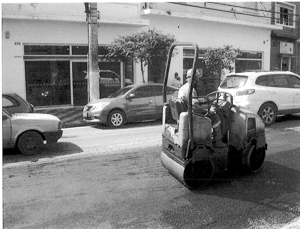
Foto 13 – Compactação com rolo compactador (Buraco 2)
