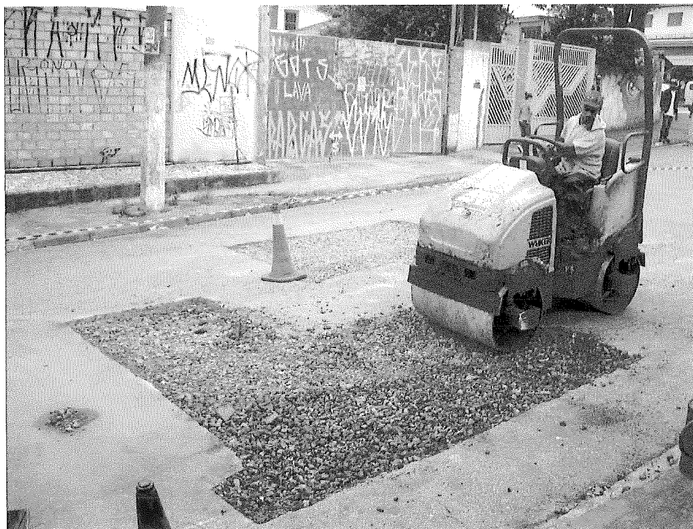
Foto 13 – Preparo da superfície do buraco
