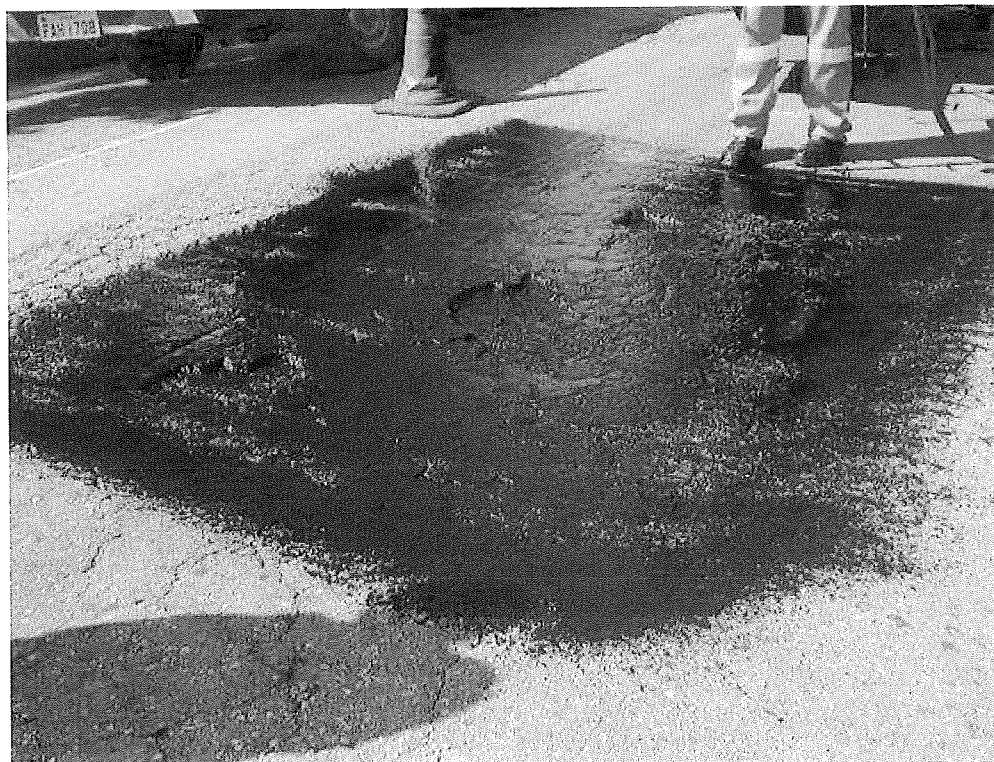
Foto 05 – Aplicação de pintura de ligação sobre o asfalto existente (Buraco 1)
