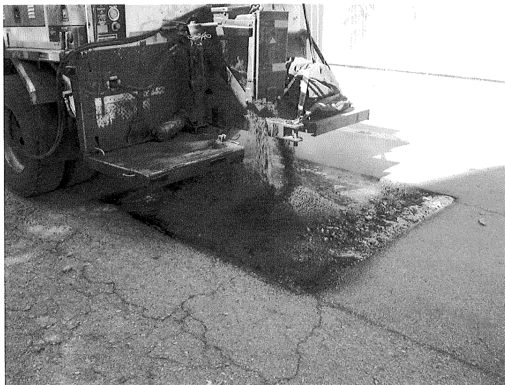
Foto 19 – Aplicação de concreto asfáltico
