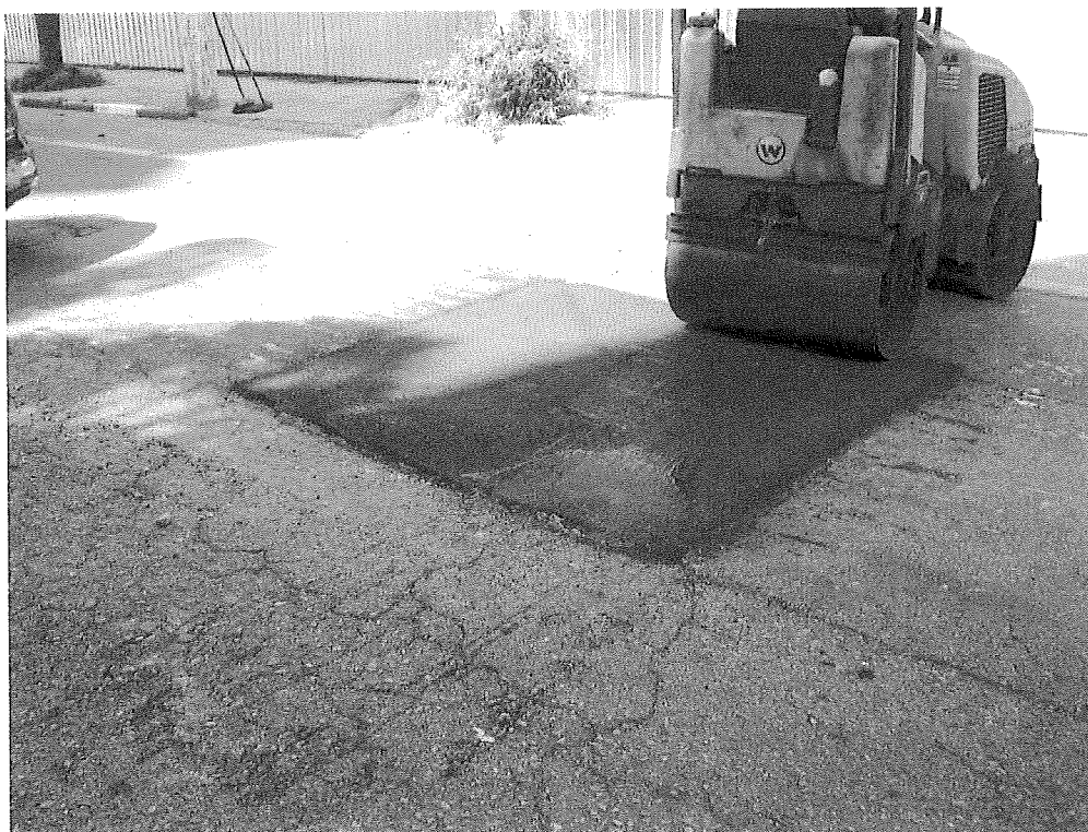
Foto 21 – Compactação com rolo compactador
