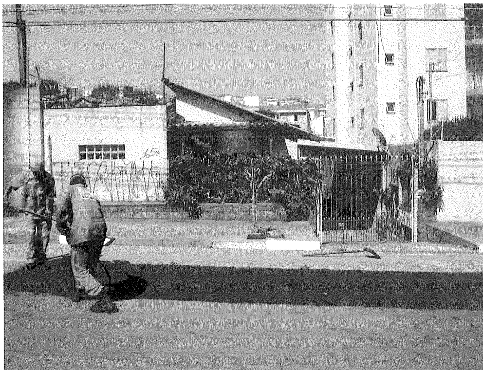
Foto 08 – Aplicação de concreto asfáltico
