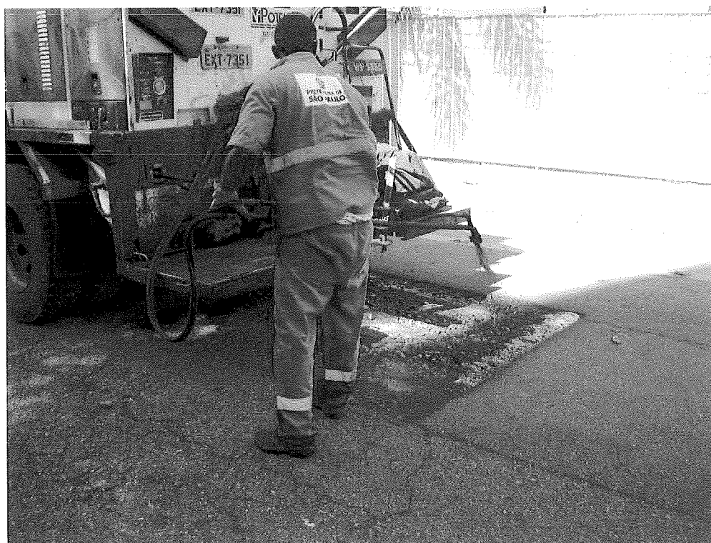
Foto 18 – Execução de pintura de ligação com emulsão
