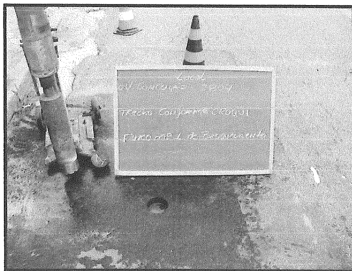
Corpo de prova extraído do Furo Nº 1 de Broqueamento com Sonda Rotativa.
