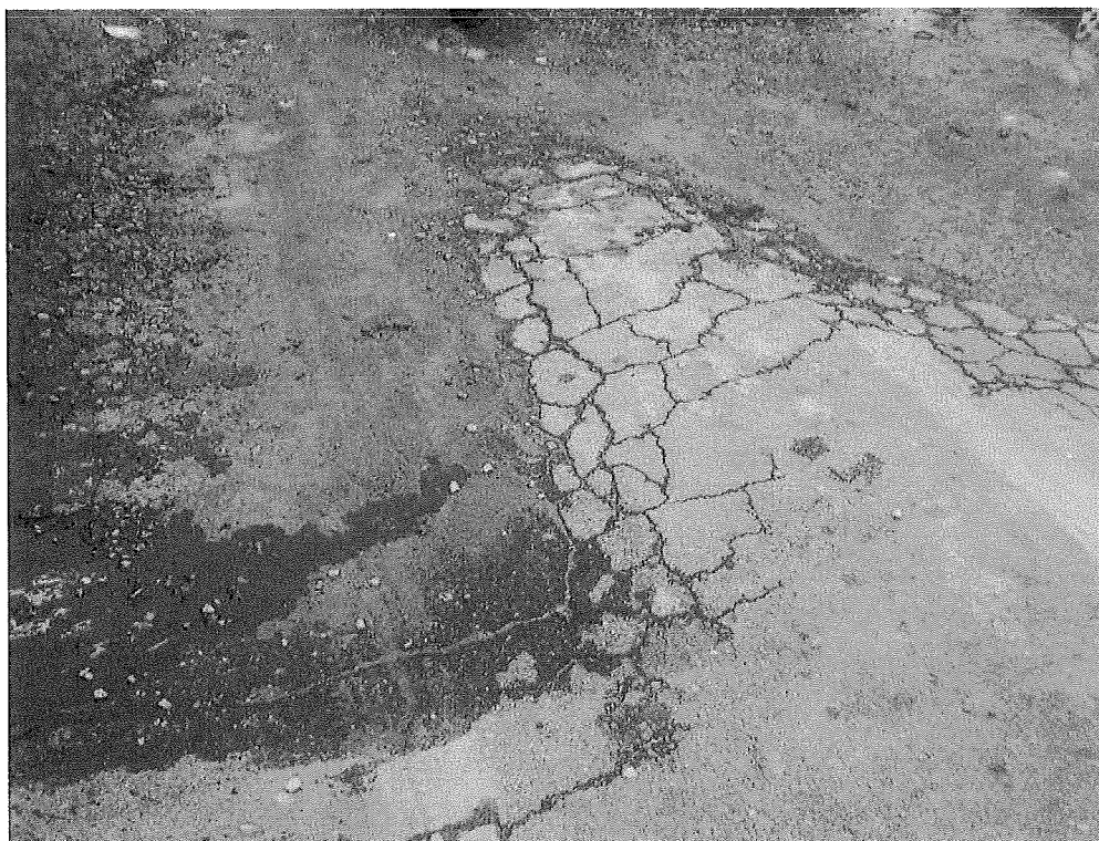
Foto 04 – Pavimento existente antes do início do serviço
