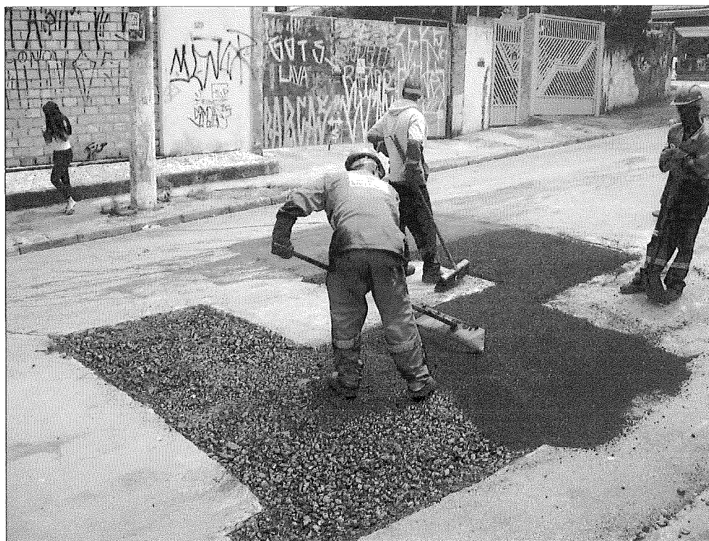
Foto 15 – Aplicação do concreto asfáltico
