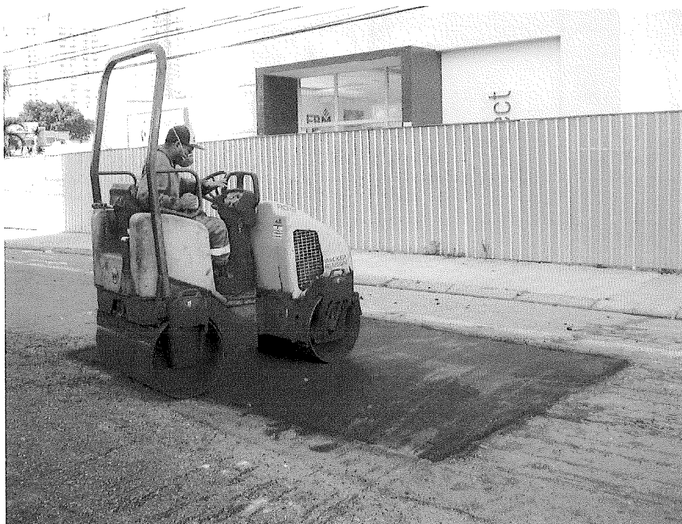
Foto 15 – Compactação com rolo compactador
