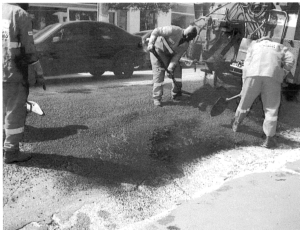
Foto 10 – Aplicação de concreto asfáltico (Buraco 2)
