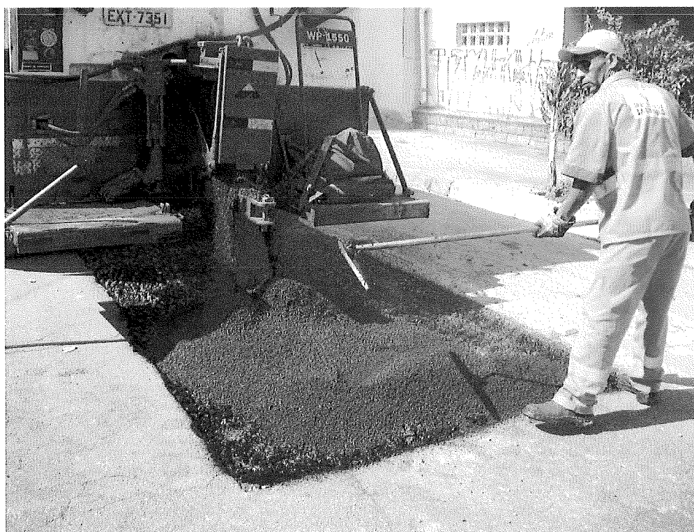
Foto 06 – Aplicação de concreto asfáltico
