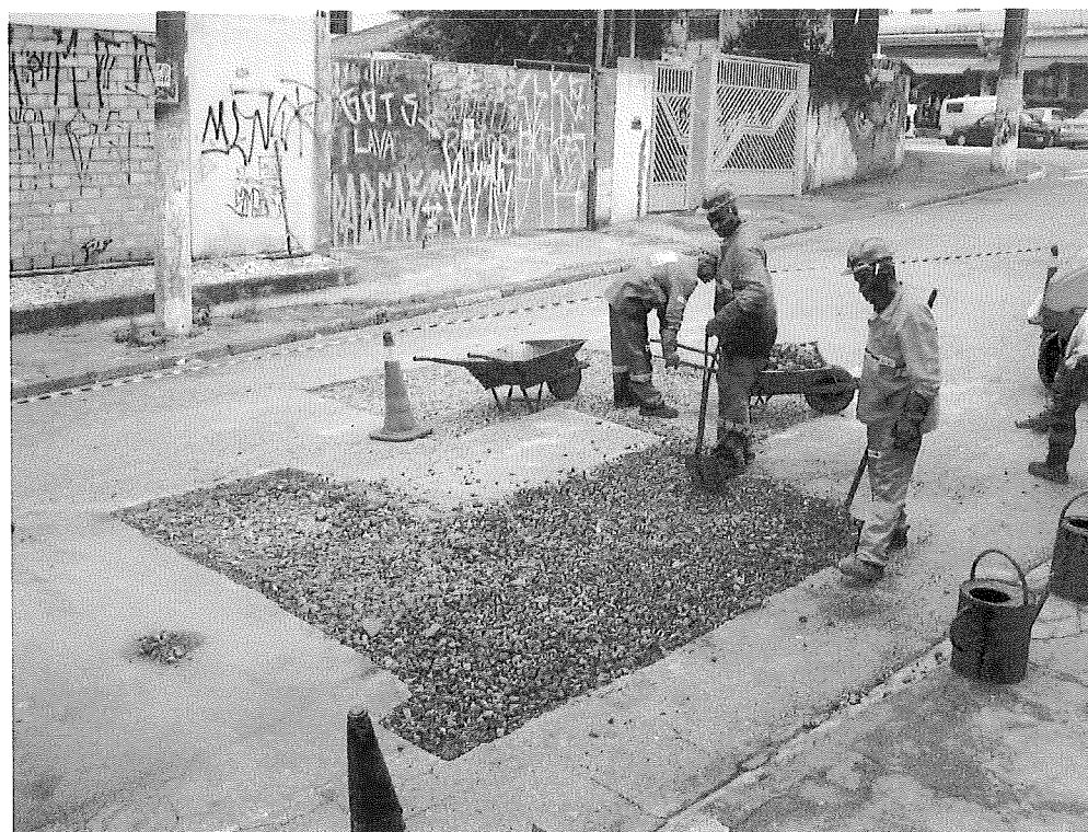
Foto 14 – Requadramento do buraco
