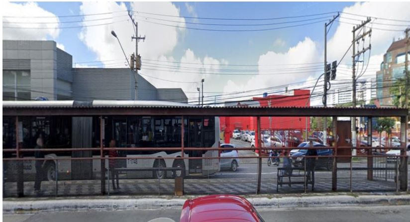
Foto 4 – Abrigos sem classificação (Corredor João Dias – Itapeverica)
