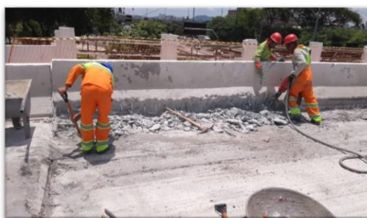
Figura 6 – 08-51-00 – Demolição de concreto armado executada pela FBS
