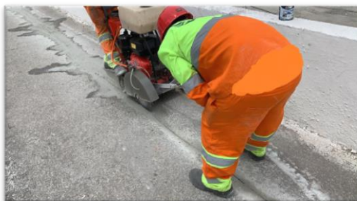
Figura 5 – 10-21-00 - Corte de concreto com disco diamantado executado pela FBS
