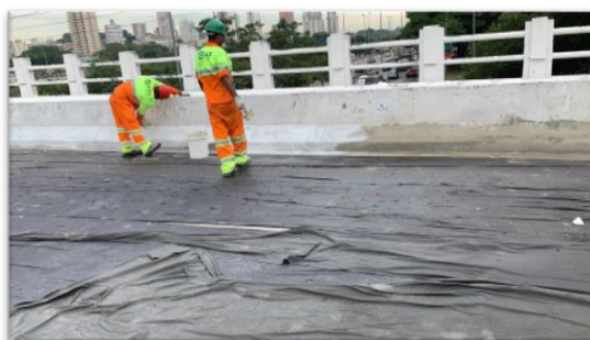
Figura 7 – 15-01-02 – Aguada de cal – Concreto ou reboco sem massa corrida exterior executada pela FBS
