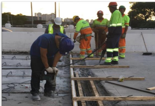
Figura 8 – 08-14-02 – Forma comum, exclusive cimbramento executada pela FBS
