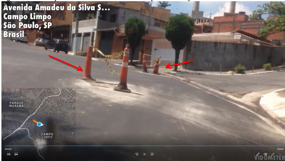
Figura 1 – Sinalização e isolamento durante a realização dos serviços.
