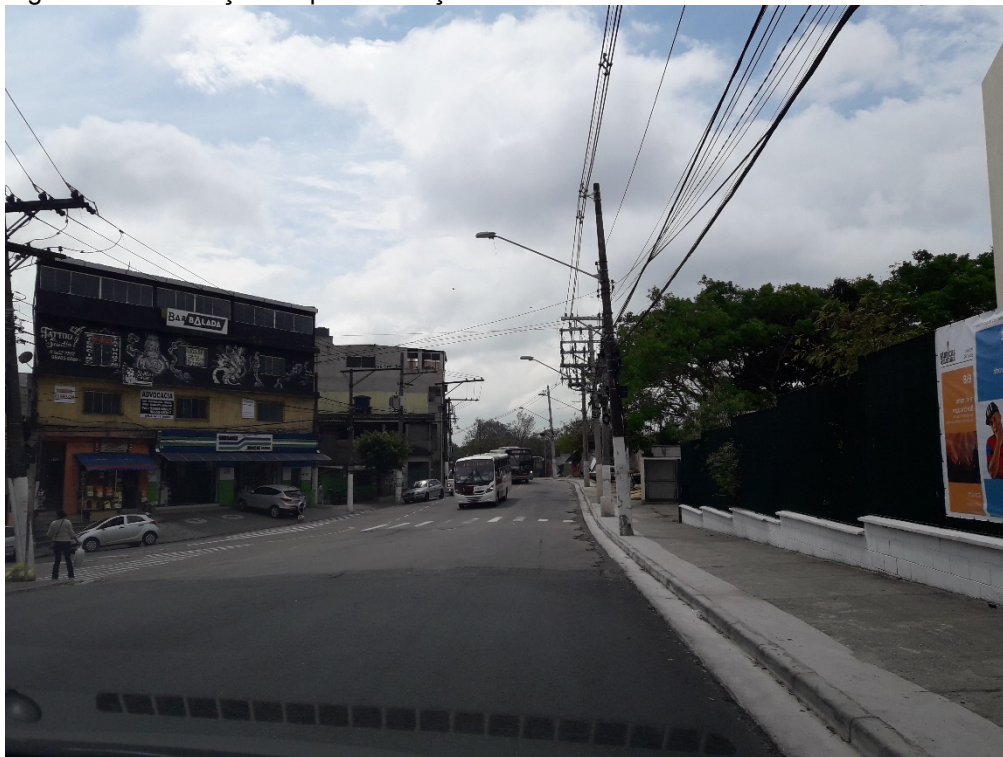
Figura 25 – Execução da pavimentação.
