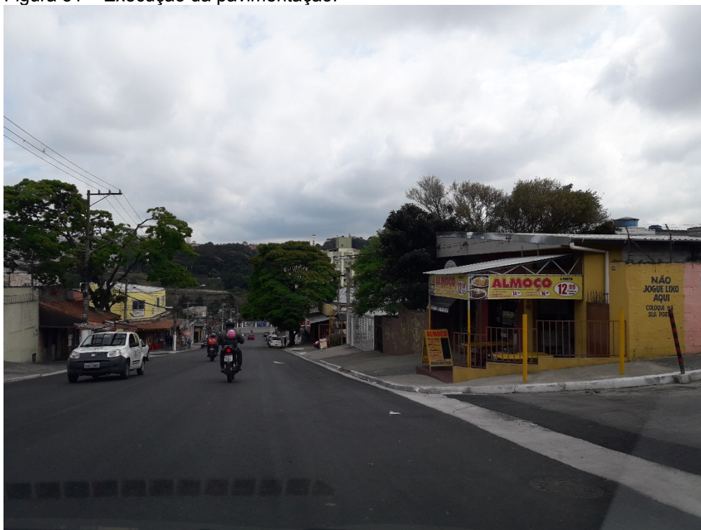
Figura 31 – Execução da pavimentação.
