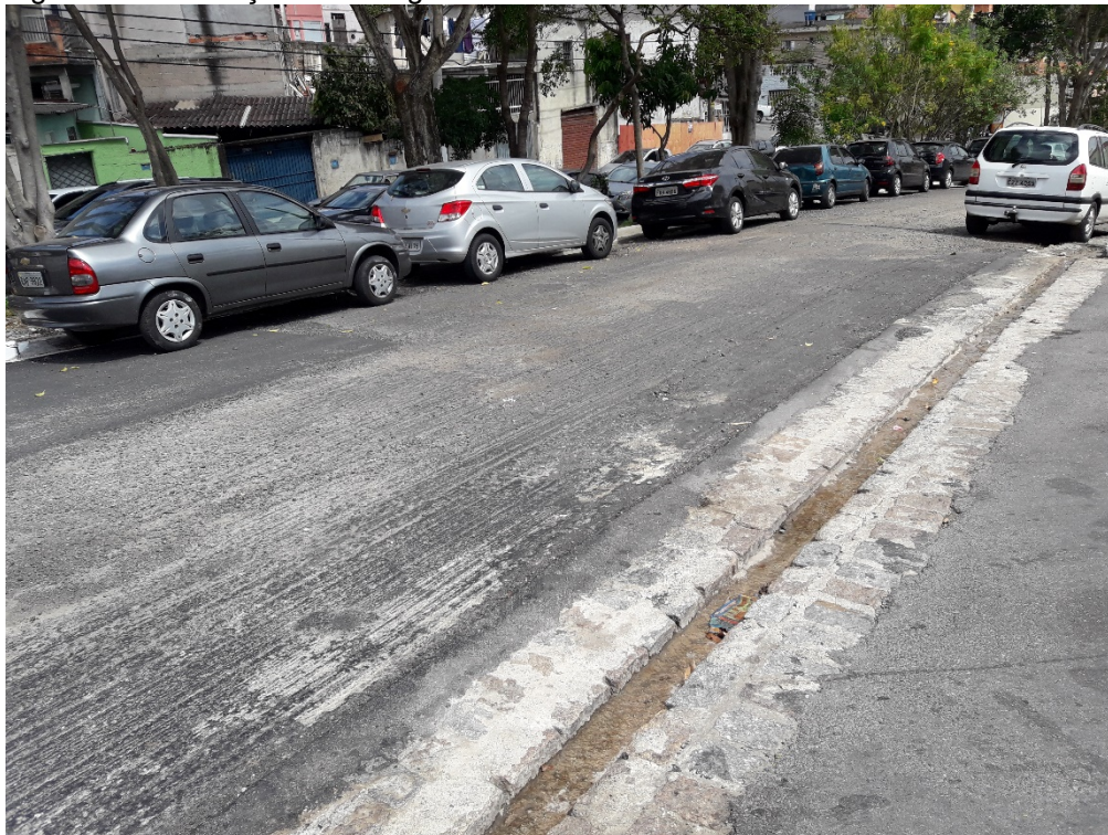
Figura 33 – Execução da fresagem
