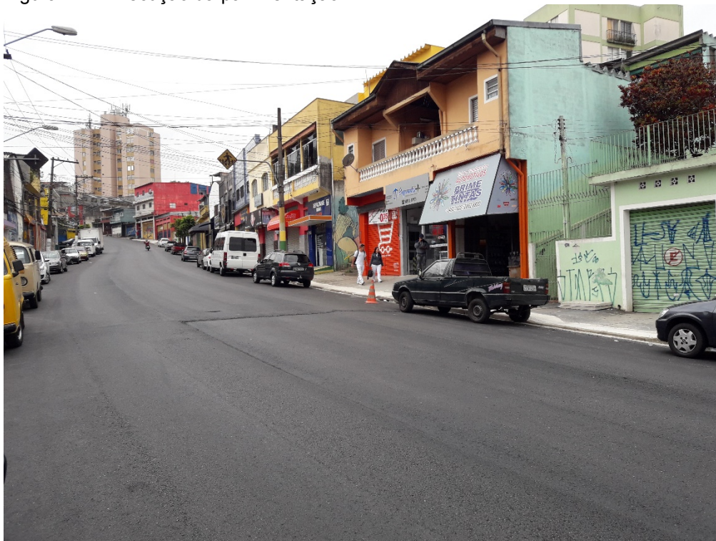
Figura 11 – Execução da pavimentação.
