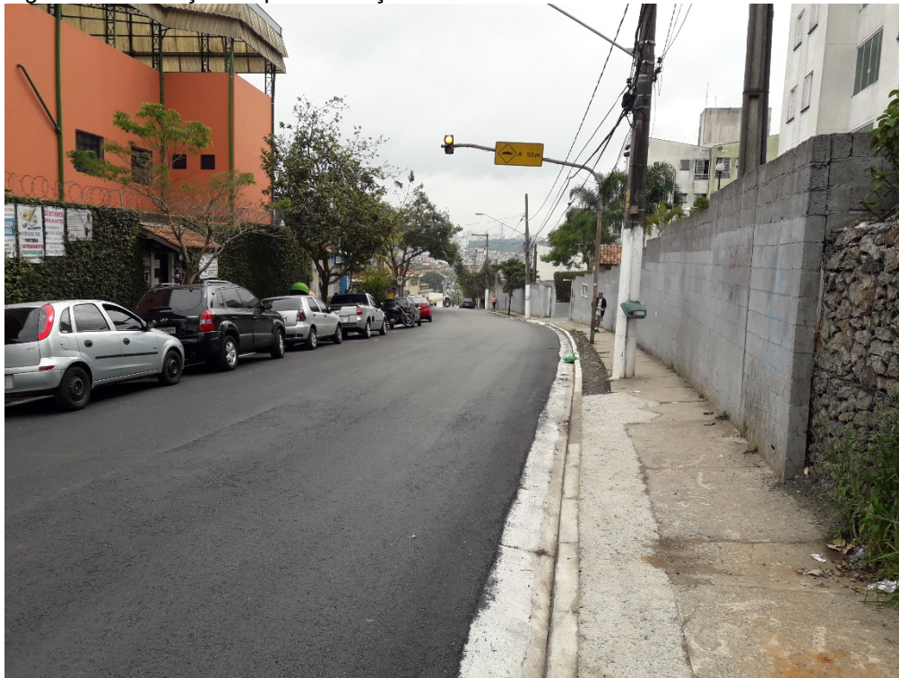
Figura 7 – Execução da pavimentação.
