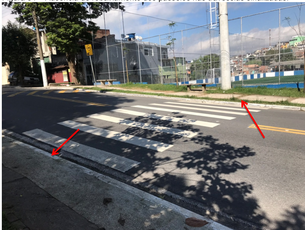
Figura 84 – Ausência de rebaixamento dos passeios nas travessias sinalizadas.
