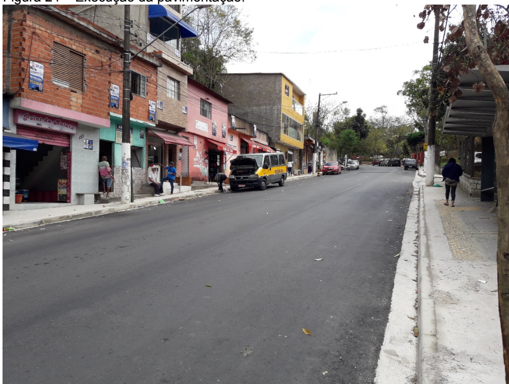
Figura 24 – Execução da pavimentação.
