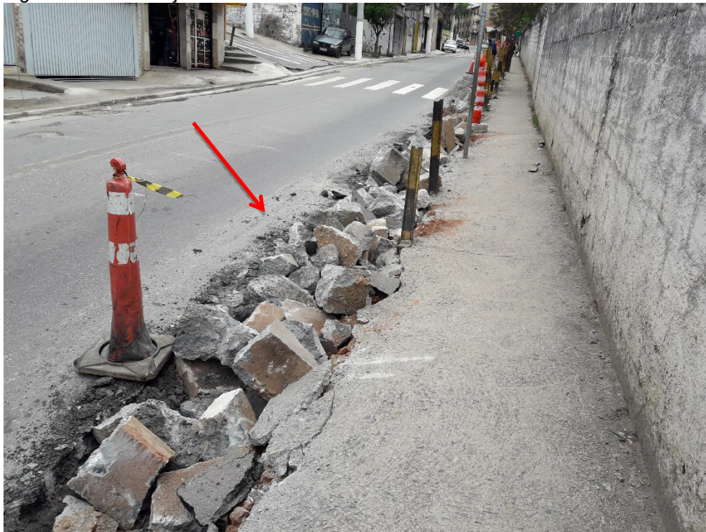
Figura 13 – Sinalização e isolamento da área de trabalho.
