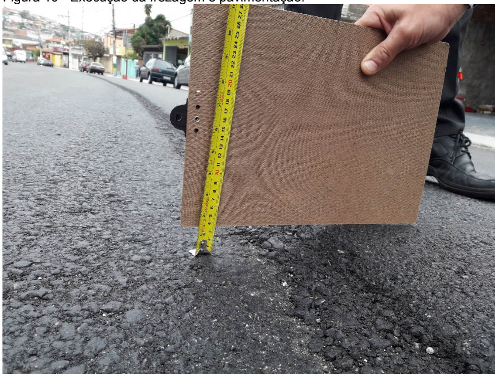
Figura 10 - Execução da frezagem e pavimentação.
