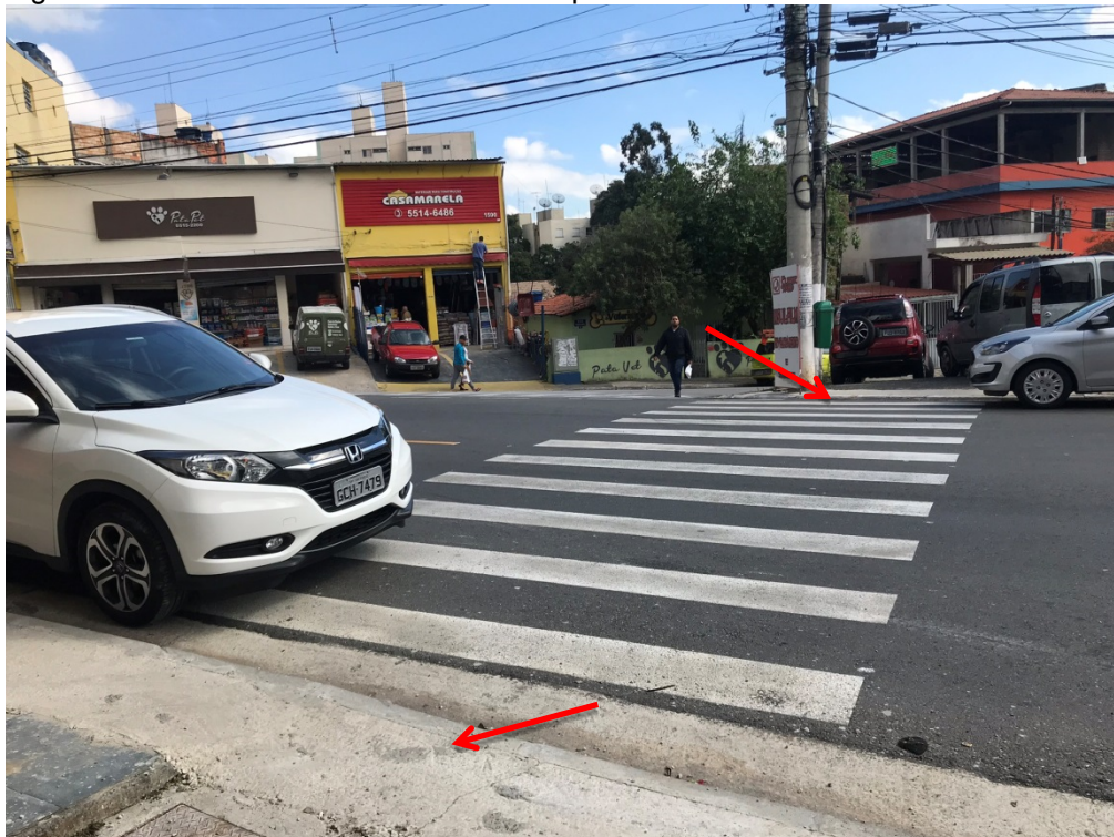
Figura 80 - Ausência de rebaixamento dos passeios nas travessias sinalizadas.
