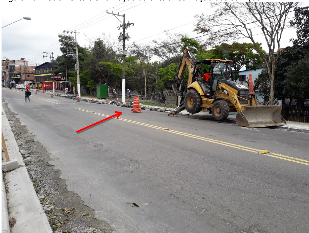
Figura 26 – Isolamento e sinalização durante a realização dos serviços.
