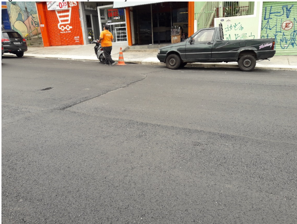
Figura 9 – Execução da pavimentação.
