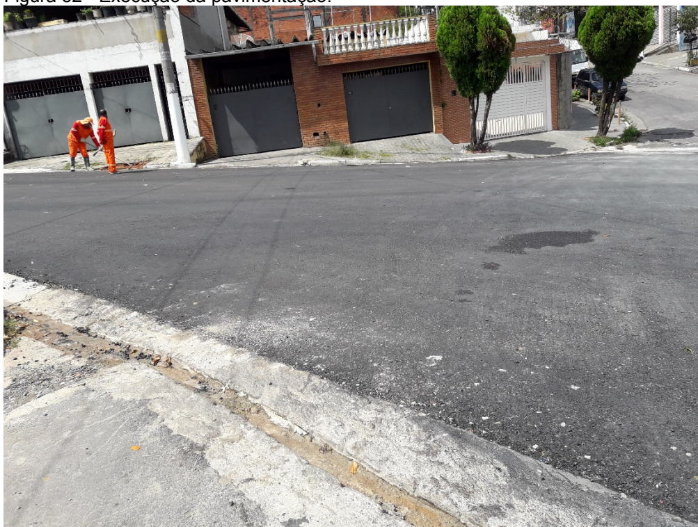
Figura 32 - Execução da pavimentação.
