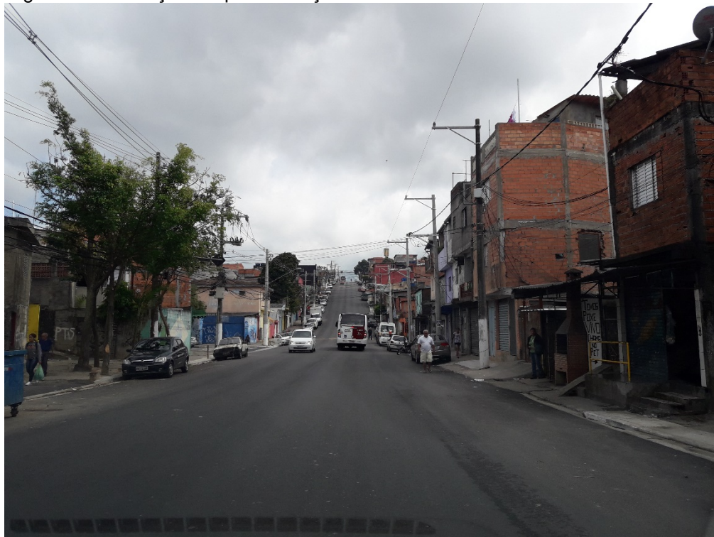
Figura 29 - Execução da pavimentação.
