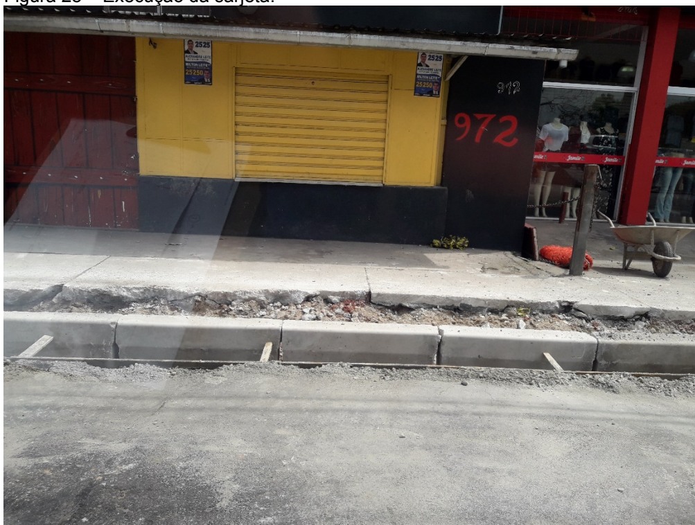
Figura 28 – Execução da sarjeta.
