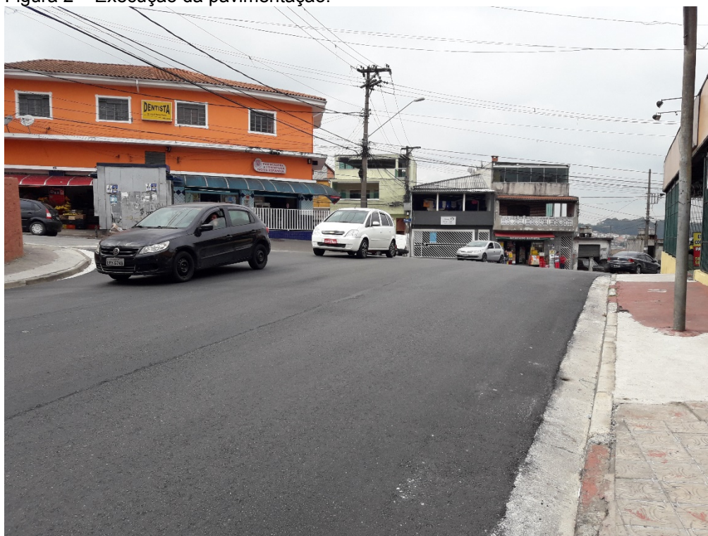
Figura 2 – Execução da pavimentação.
