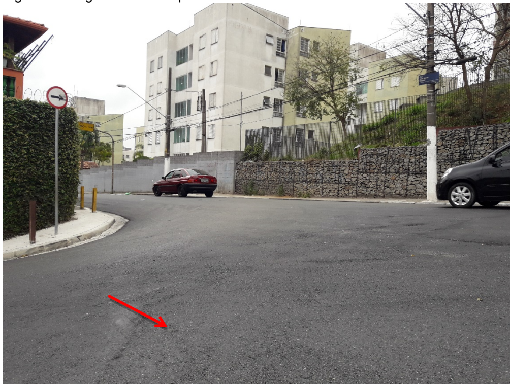
Figura 5 - Irregularidades no pavimento.
