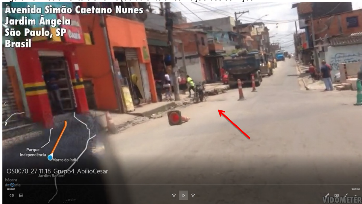
Figura 43 – Isolamento e sinalização durante a realização dos serviços.
