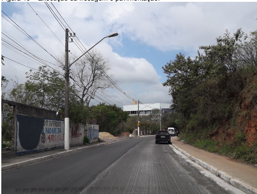
Figura 19 – Execução da fresagem e pavimentação.
