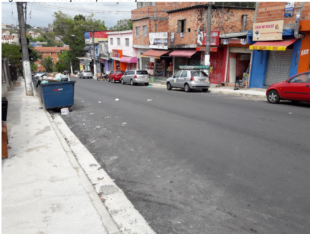
Figura 23 – Execução da pavimentação.
