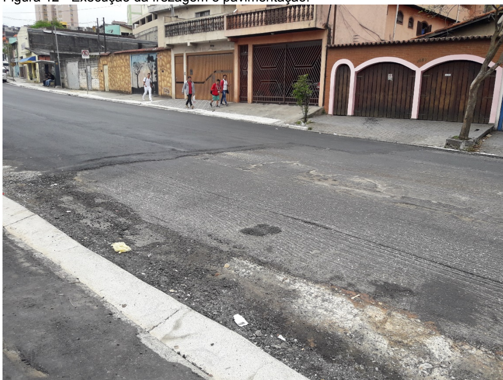
Figura 12 - Execução da frezagem e pavimentação.
