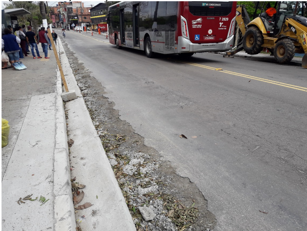
Figura 27 – Execução da sarjeta.
