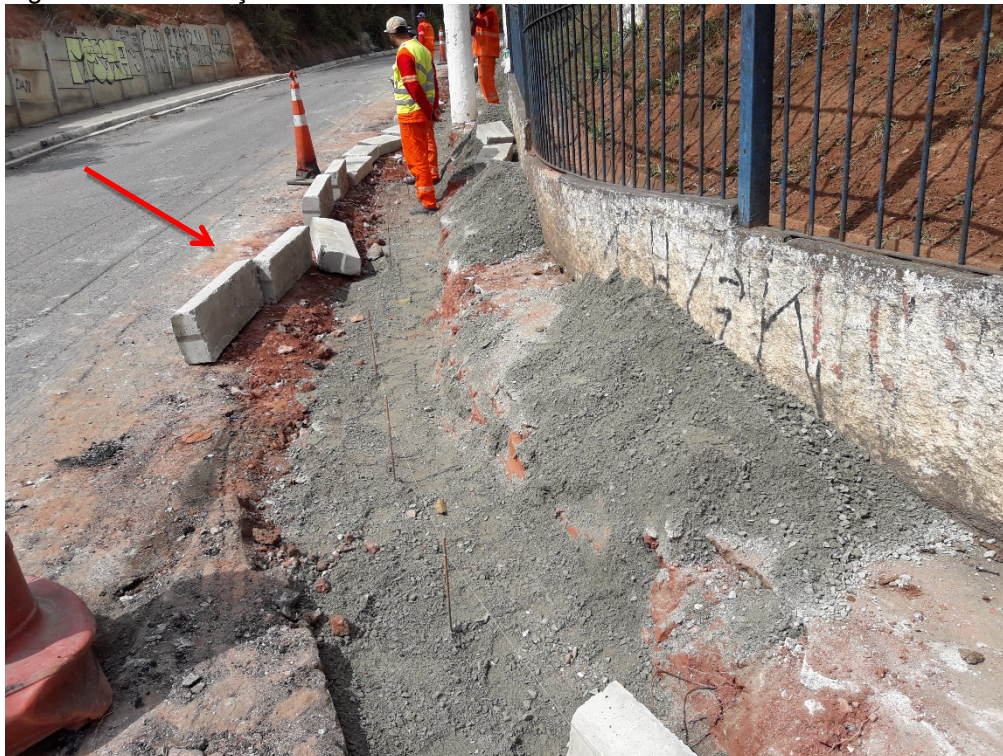
Figura 17 - Sinalização e isolamento da área de trabalho.
