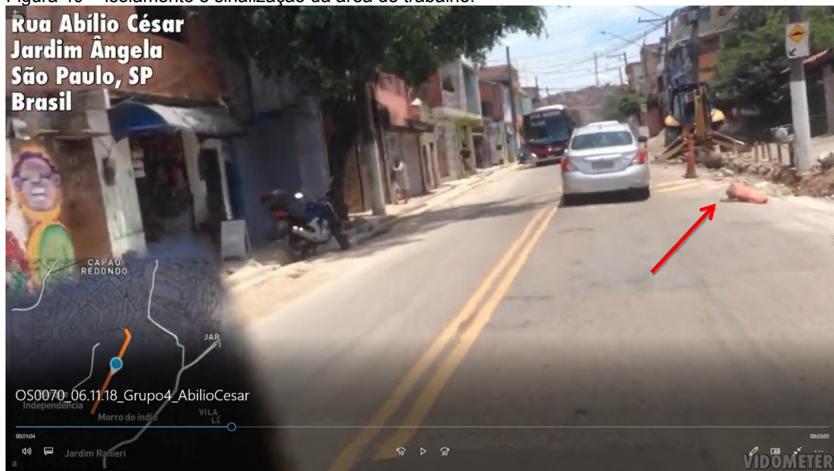
Figura 40 – Isolamento e sinalização da área de trabalho.
