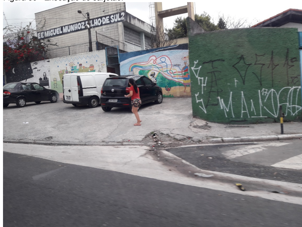
Figura 30 - Execução do sarjetão.
