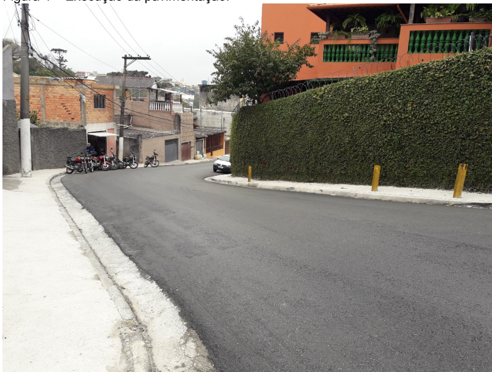
Figura 4 – Execução da pavimentação.
