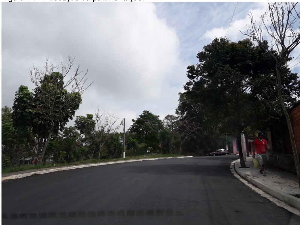
Figura 22 – Execução da pavimentação.
