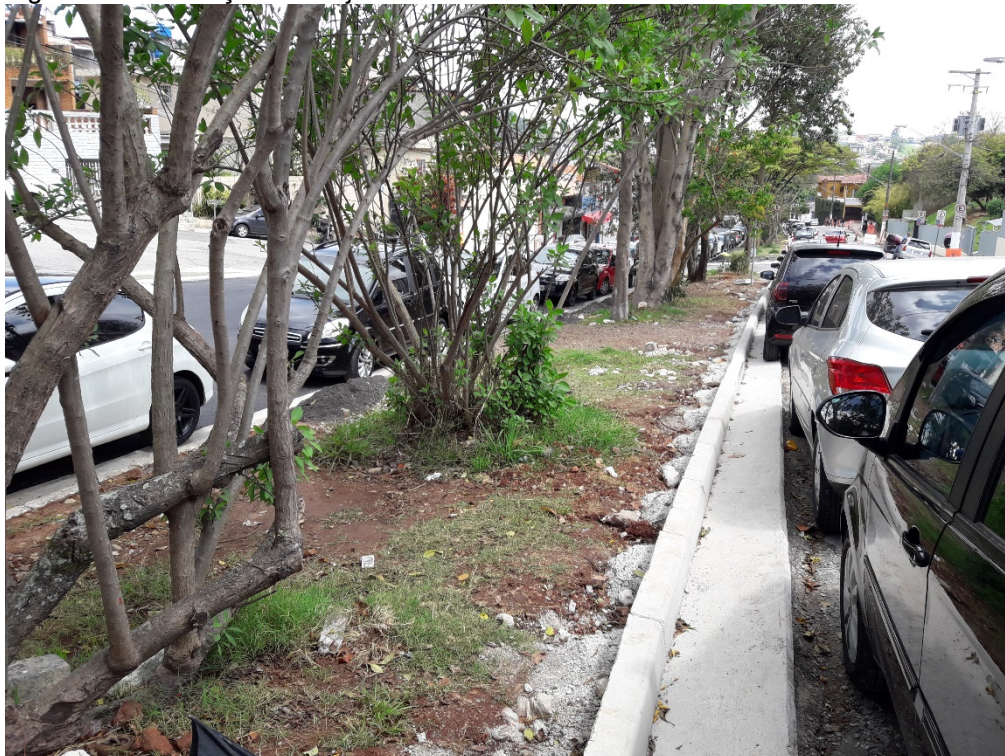
Figura 35 – Execução da sarjeta.
