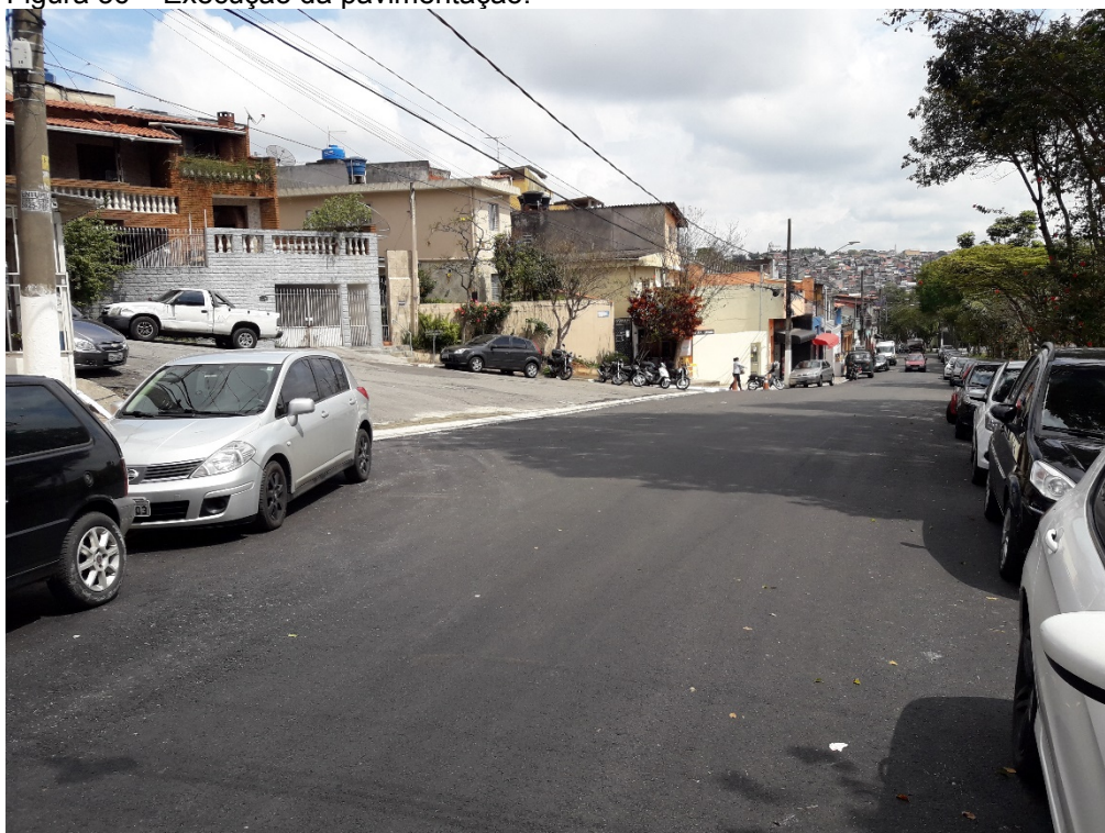
Figura 36 – Execução da pavimentação.
