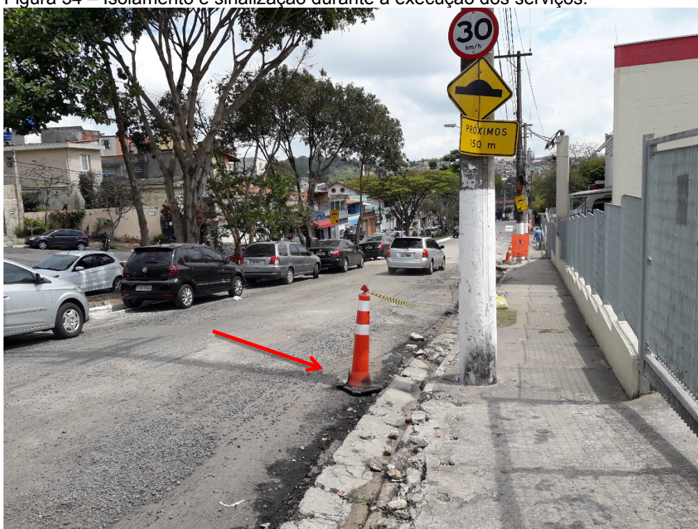
Figura 34 – Isolamento e sinalização durante a execução dos serviços.
