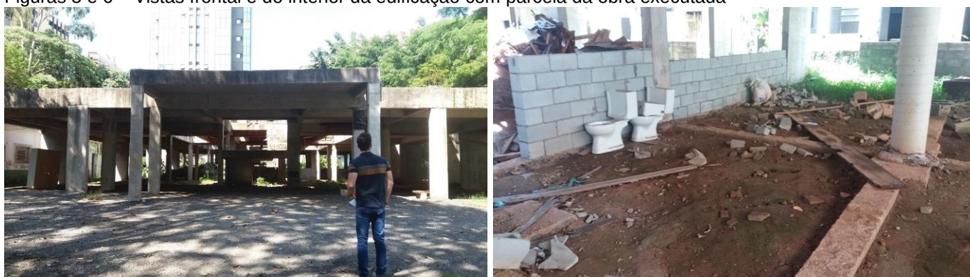
Figuras 5 e 6 – Vistas frontal e do interior da edificação com parcela da obra executada
