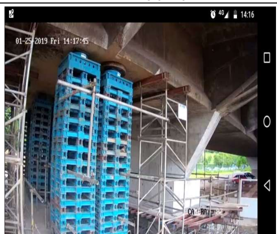
Figura 8 – Equipes não alocadas na frente de trabalho 25.01.19
