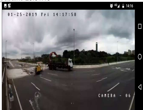
Figura 6 – Equipes não alocadas na frente de trabalho 25.01.19
