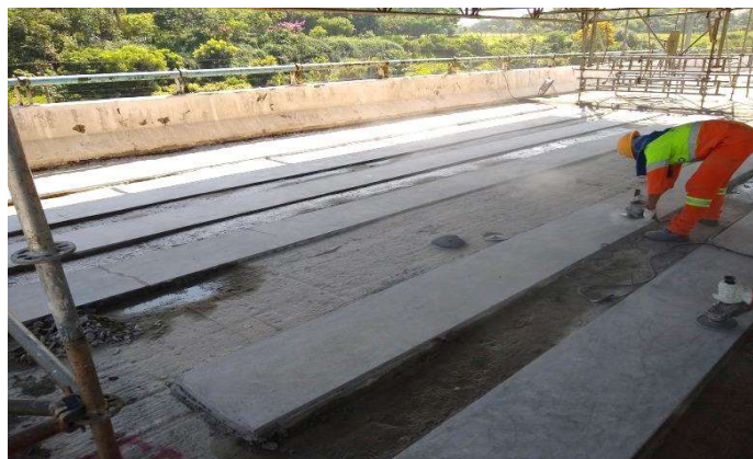
Figura 16 – Lixamento da argamassa em 08.02.2019
