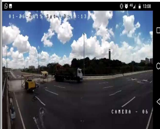
Figura 11 – Equipes não alocadas na frente de trabalho 26.01.19
