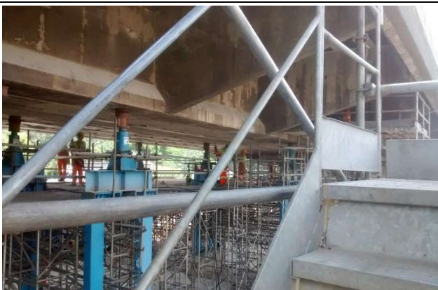
Figura 14 – Apicoamento da superfície do concreto em 14.02.2019
