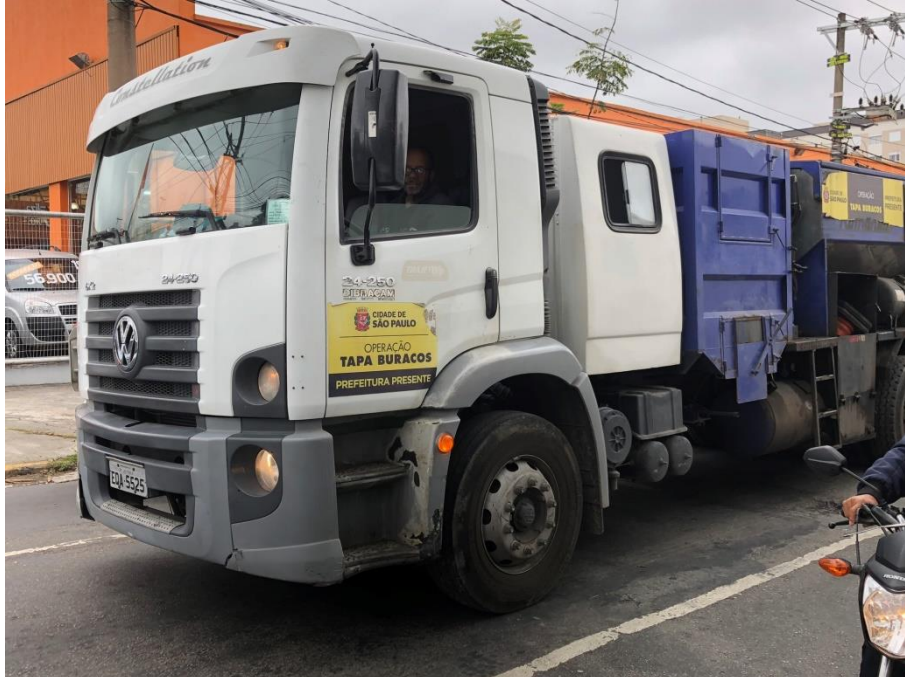
Figura 13 – Veículo placa EQA-5525 utilizado para aplicação do concreto asfáltico
