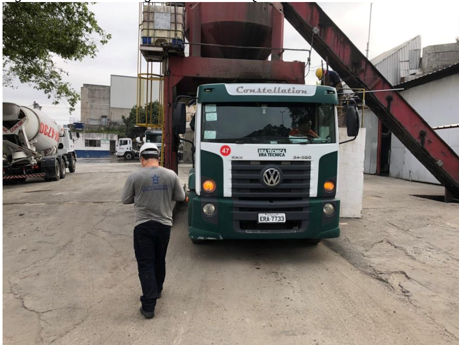
Figura 8 – Silo de carregamento de CBUQ
