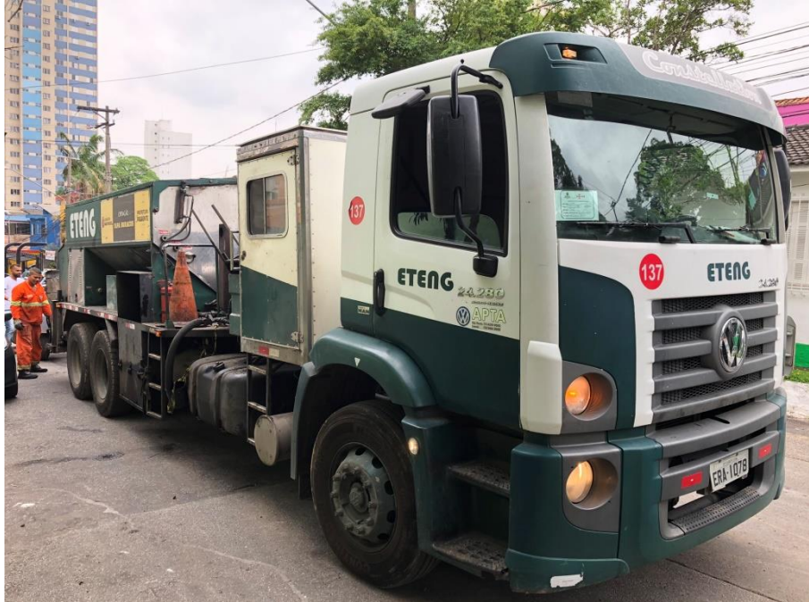
Figura 25 – Veículo placa ERA-1078 utilizado para aplicação do concreto asfáltico
