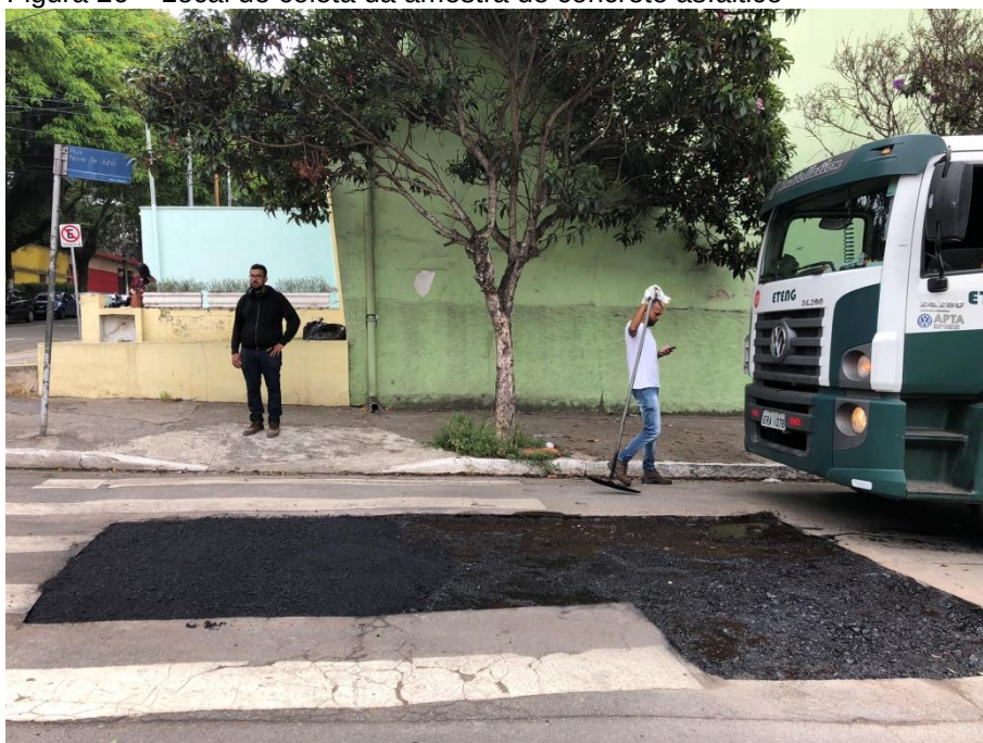
Figura 26 – Local de coleta da amostra de concreto asfáltico
