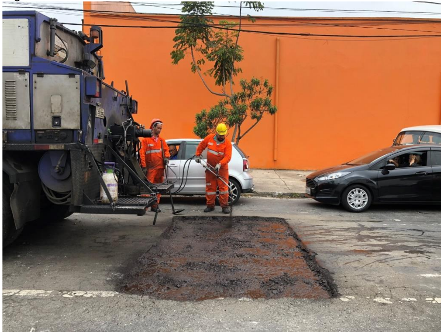
Figura 14 – Local de coleta da amostra de concreto asfáltico
