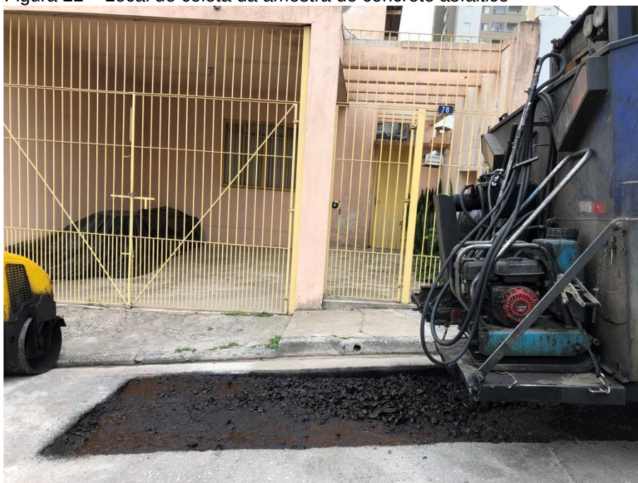
Figura 22 – Local de coleta da amostra de concreto asfáltico
