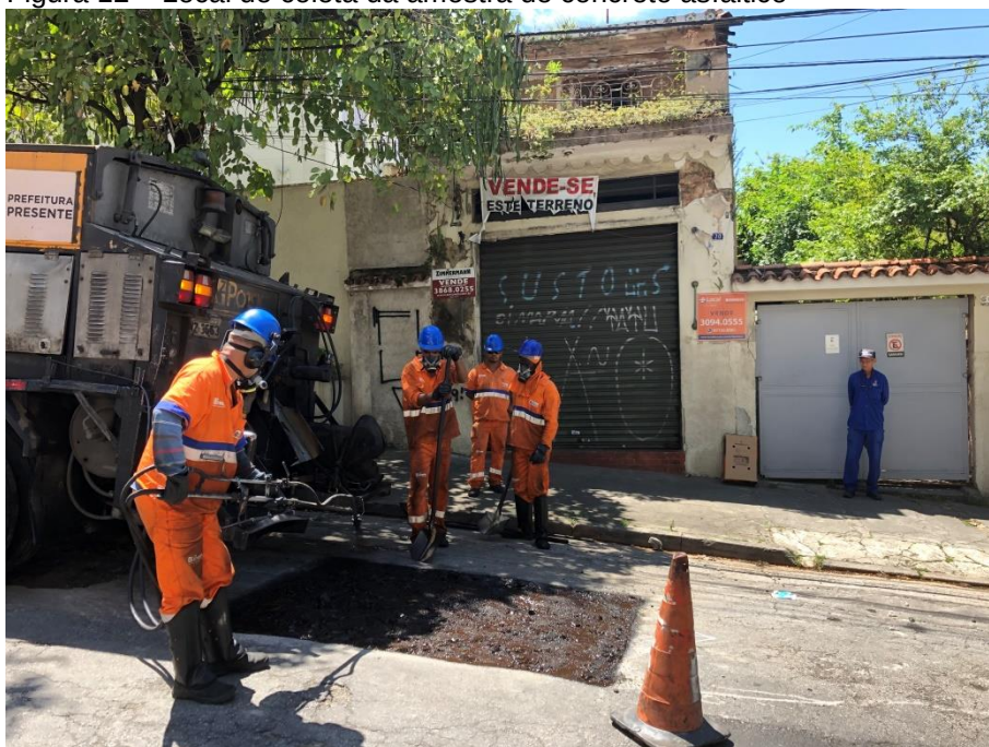
Figura 12 – Local de coleta da amostra de concreto asfáltico
