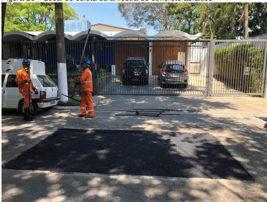
Figura 20 – Local de coleta da amostra de concreto asfáltico
