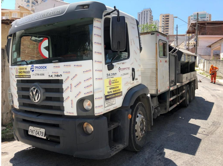
Figura 17 – Veículo placa FNT-0479 utilizado para aplicação do concreto asfáltico
