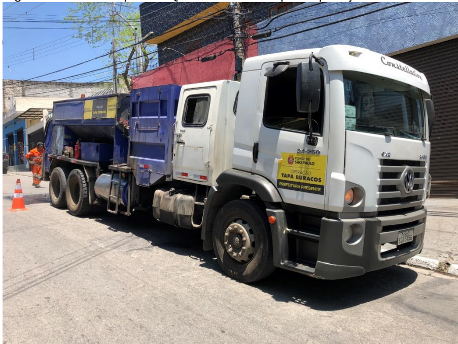
Figura 19 – Veículo placa EQA-5496 utilizado para aplicação do concreto asfáltico
