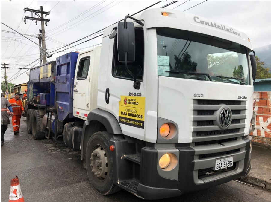
Figura 15 – Veículo placa EQA-5496 utilizado para aplicação do concreto asfáltico
