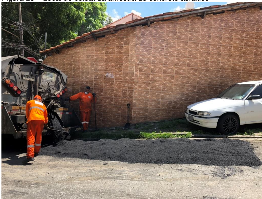
Figura 18 – Local de coleta da amostra de concreto asfáltico
