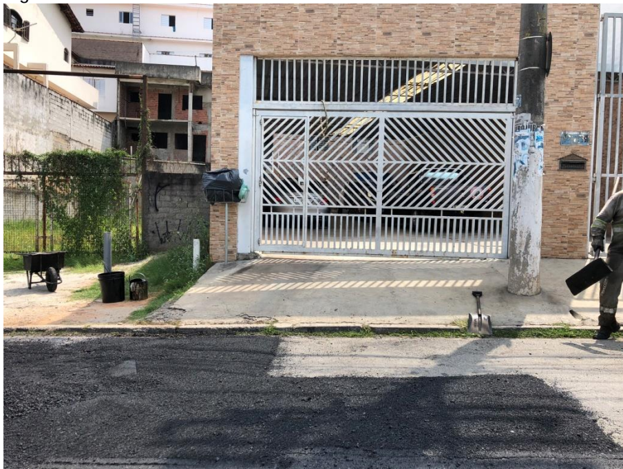
Figura 28 – Local de coleta da amostra de concreto asfáltico
