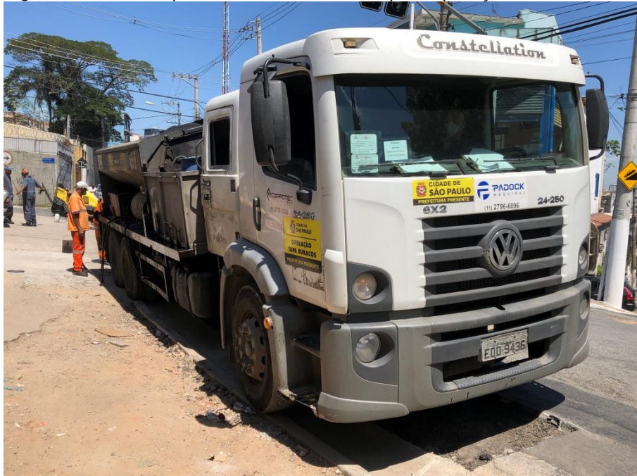
Figura 11 – Veículo placa EDD-9436 utilizado para aplicação do concreto asfáltico
