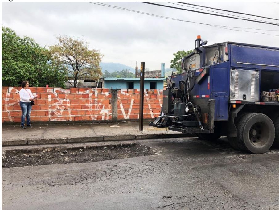
Figura 16 – Local de coleta da amostra de concreto asfáltico
