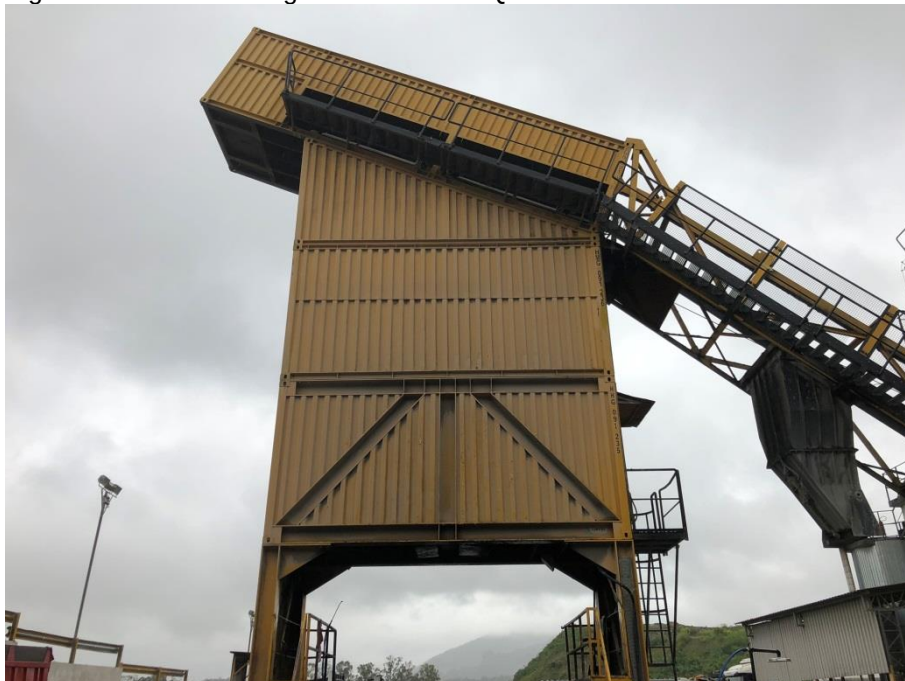
Figura 8 – Silo de carregamento de CBUQ
