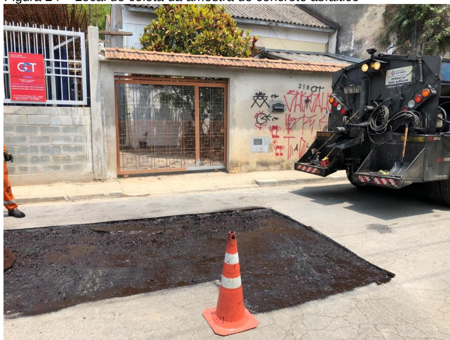
Figura 24 – Local de coleta da amostra de concreto asfáltico
