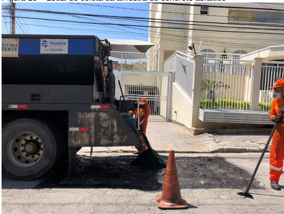
Figura 10 – Local de coleta da amostra de concreto asfáltico
