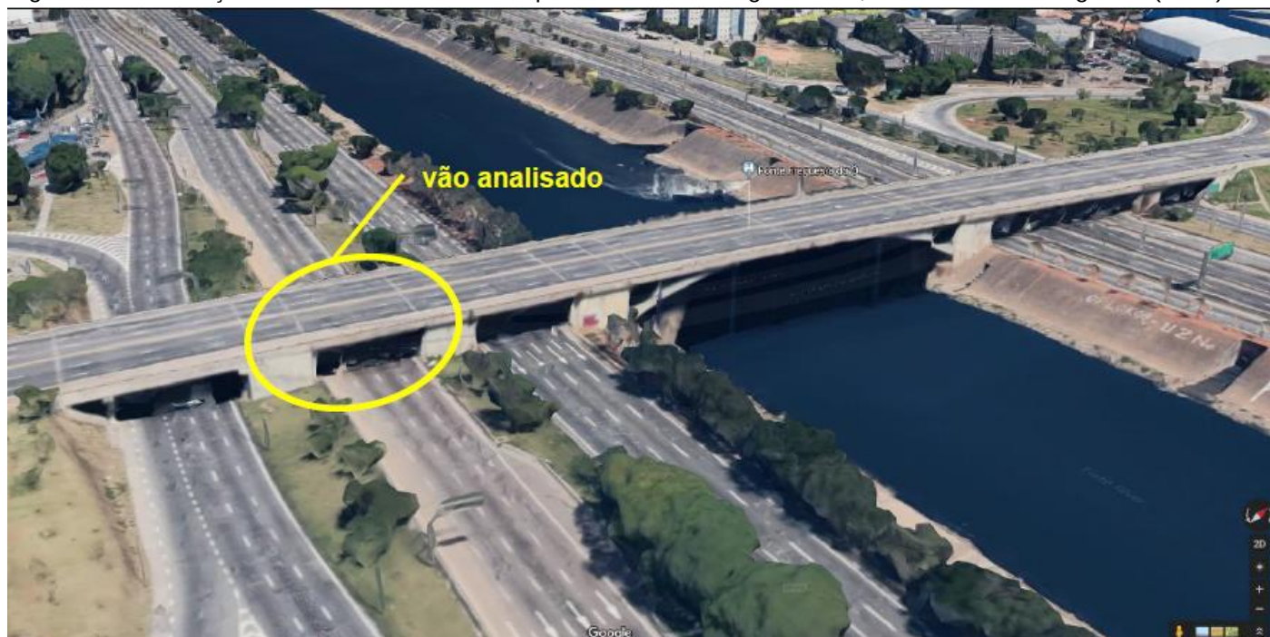
Figura 1 – Localização do vão analisado sobre a pista central da Marginal Tietê, sentido Centro-Freguesia (norte).
