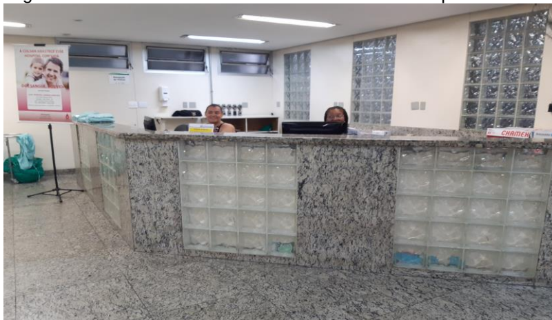
Figura 29 - Balcão de Atendimento com Altura Inadequada
