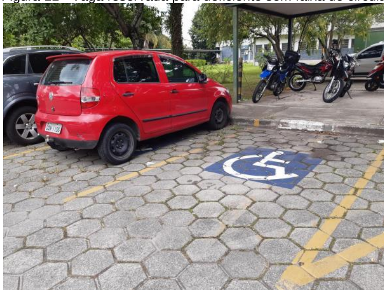
Figura 11 - Vaga reservada para deficiente sem faixa de circulação
