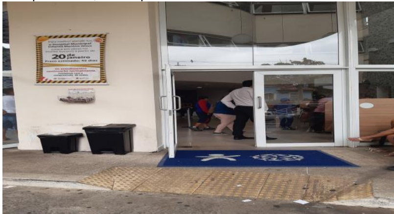
Figura 66 - Rampa de acesso à recepção de visitas com largura adequada de 1,30 m e piso de alerta
