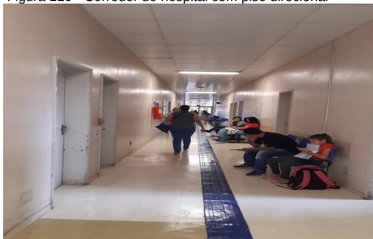
Figura 110 - Corredor do hospital com piso direcional
