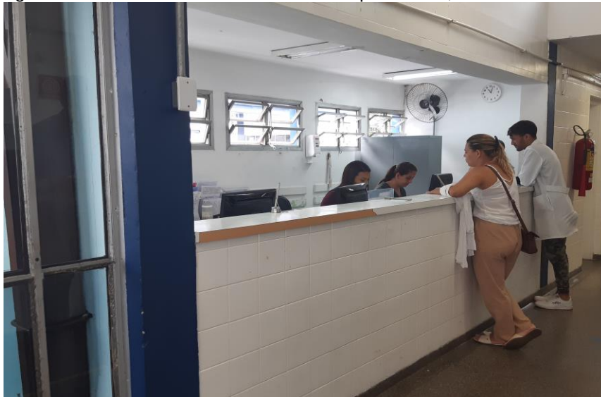
Figura 86 - Balcão do PS com altura inadequada de 1,13 m
