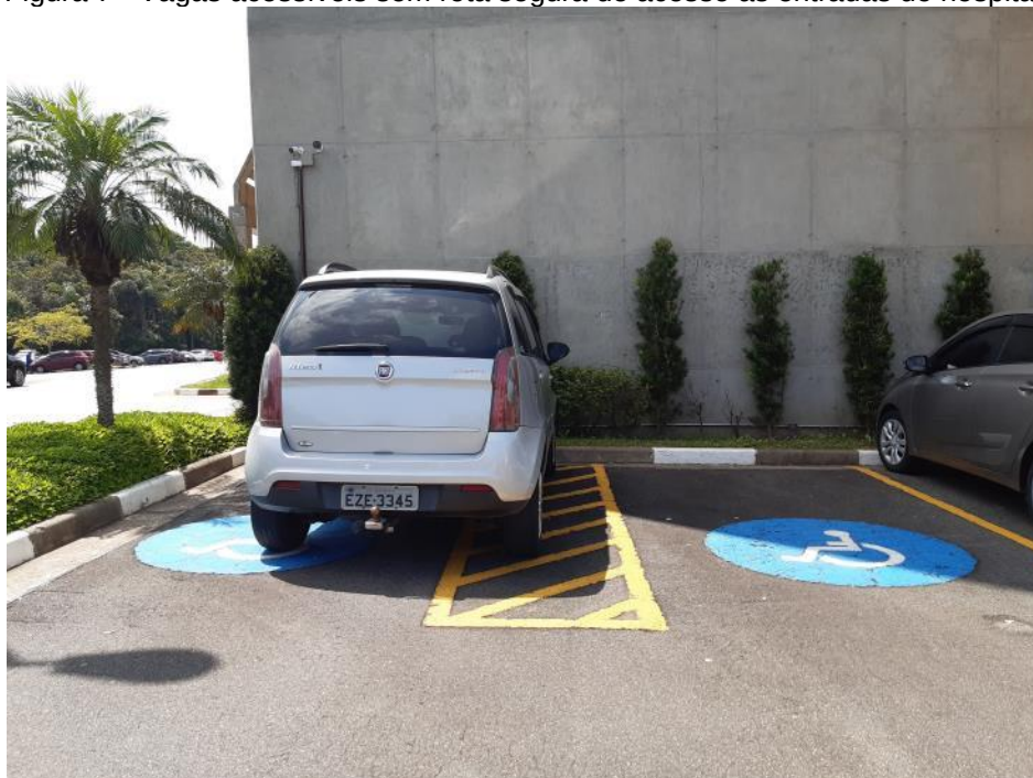
Figura 7 - Vagas acessíveis sem rota segura de acesso às entradas do hospital
