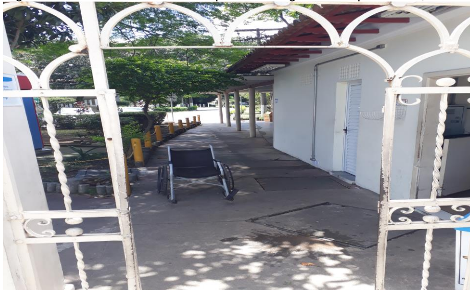
Figura 88 - Entrada externa do hospital com largura inadequada de 0,76 m
