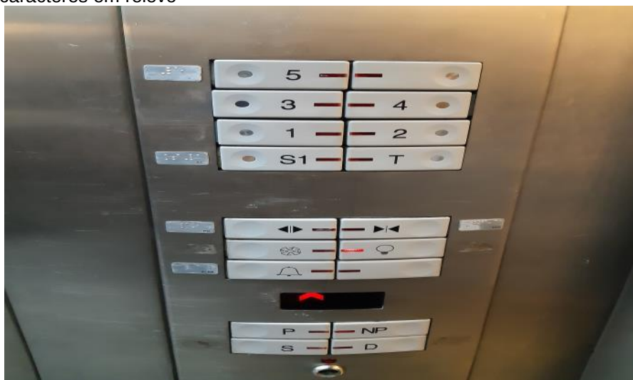
Figura 41 - Botoeiras com informações em Braille faltantes e sem caracteres em relevo
