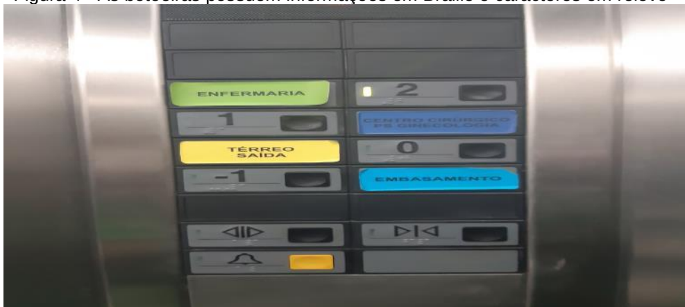
Figura 4 - As botoeiras possuem informações em Braille e caracteres em relevo
