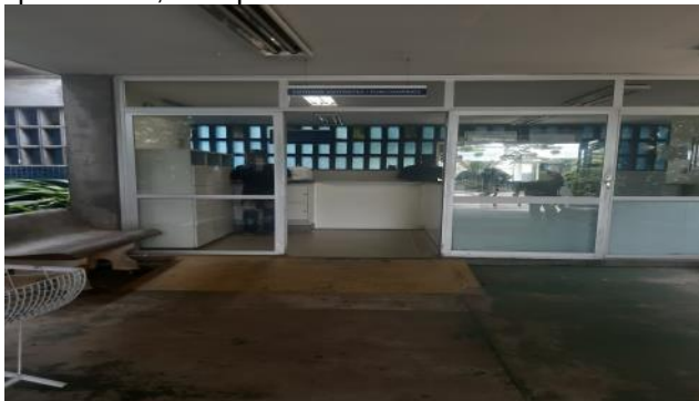
Figura 17 - Entrada de visitantes – largura da porta de apenas 1 m, sem piso tátil
