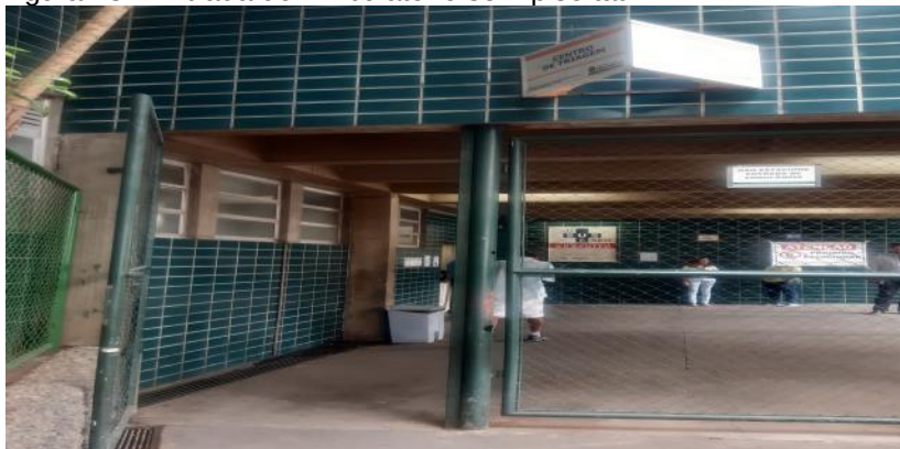
Figura 23 - Entrada do Ambulatório sem piso tátil
