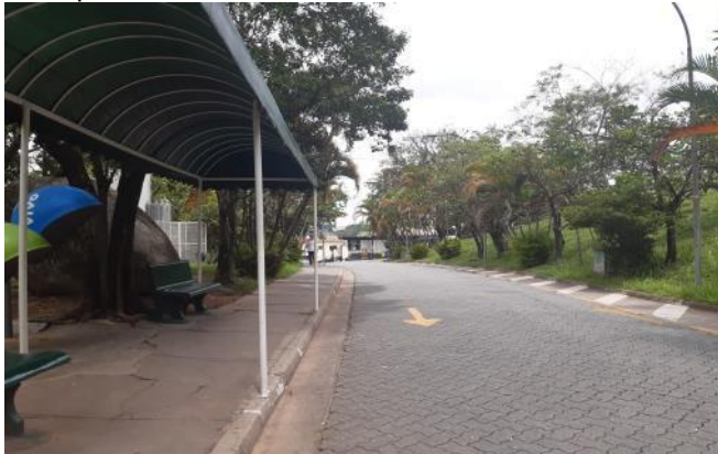
Figura 50 - Entrada externa do hospital sem corrimão e sem piso tátil
