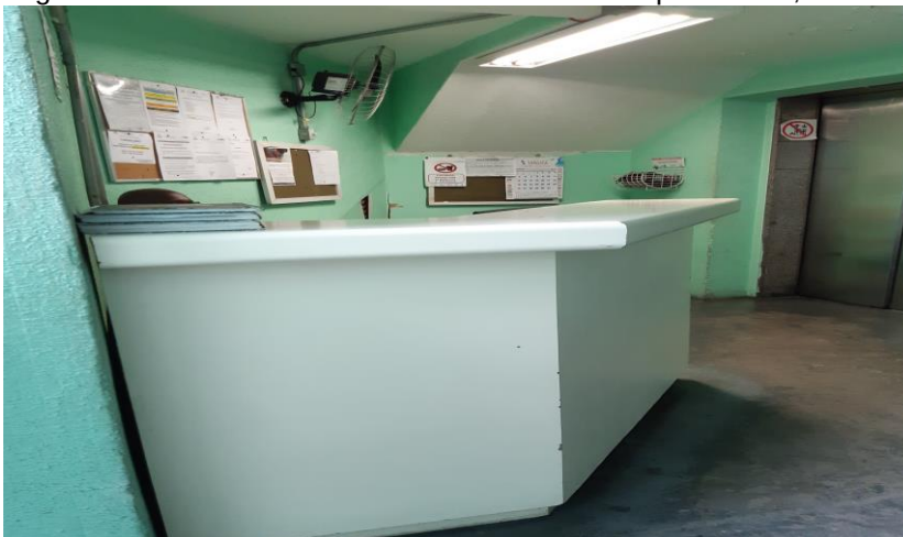
Figura 95 - Balcão de visitantes com altura inadequada de 1,17 m
