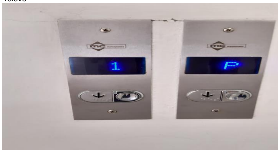
Figura 75 - Painéis de chamada com informações em Braille e caracteres em relevo
