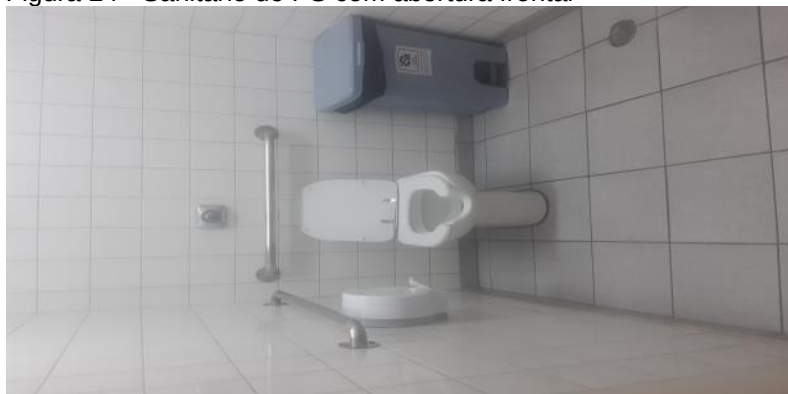
Figura 24 - Sanitário do PS com abertura frontal
