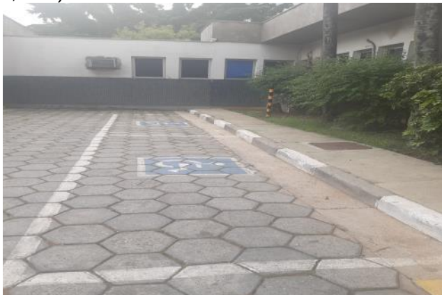
Figura 22 - Vagas reservadas para deficientes com dimensões inadequadas (4,74 m x 1,73 m e 4,90 m x 1,73 m)
