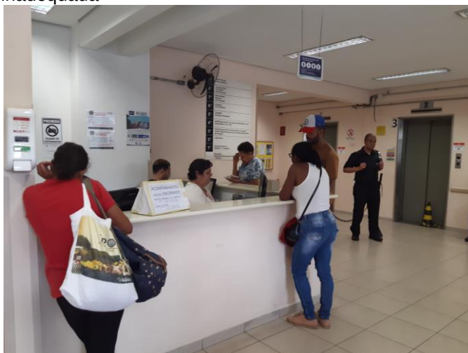
Figura 34 - Balcão Maternidade (Visitantes) com altura inadequada
