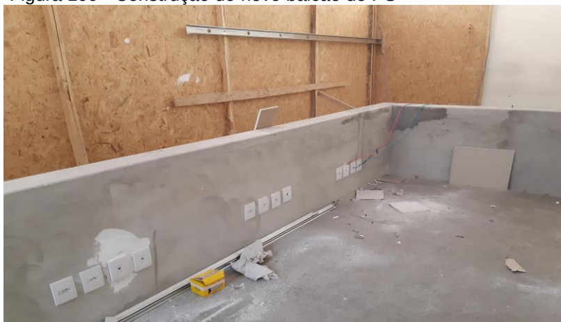
Figura 100 - Construção do novo balcão do PS
