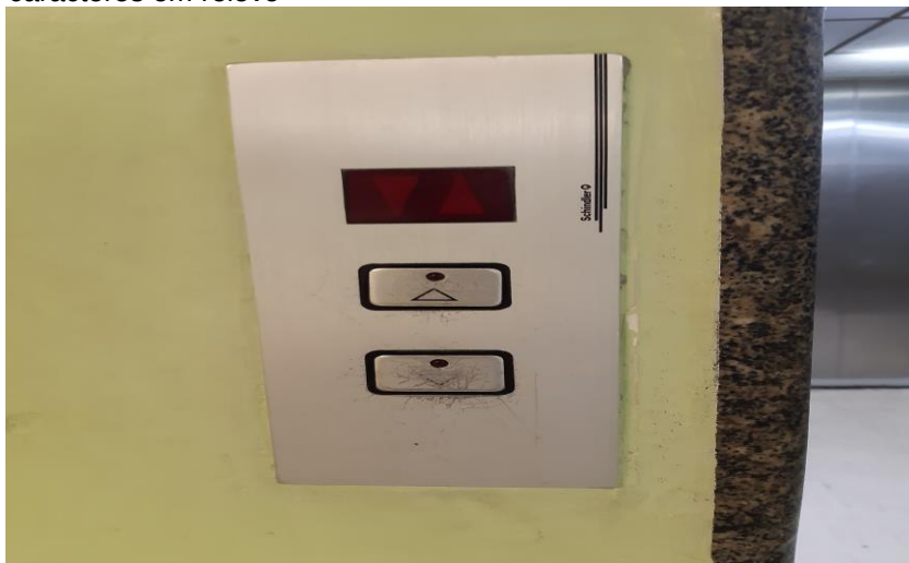
Figura 97 - Painel de chamada sem informações em Braille e sem caracteres em relevo
