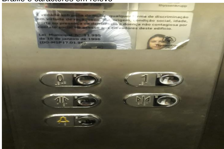
Figura 93 - Botoeiras do elevador com informações em Braille e caracteres em relevo
