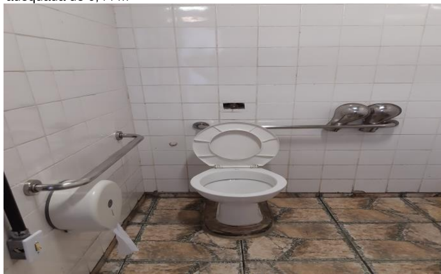
Figura 81 - Sanitário do ambulatório com barras. Altura do vaso sanitário adequada de 0,44 m
