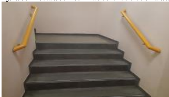
Figura 33 - Escada sem corrimão contínuo e de uma altura
