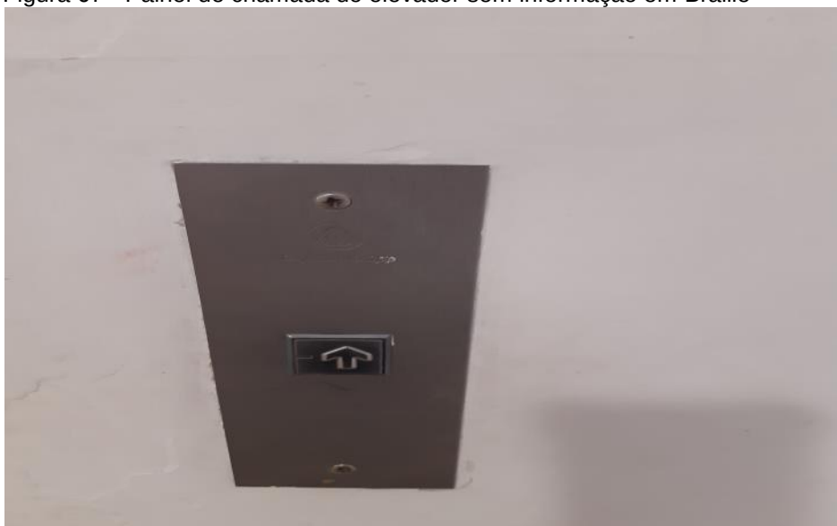
Figura 67 - Pannel de chamada do elevador sem informação em Braille
