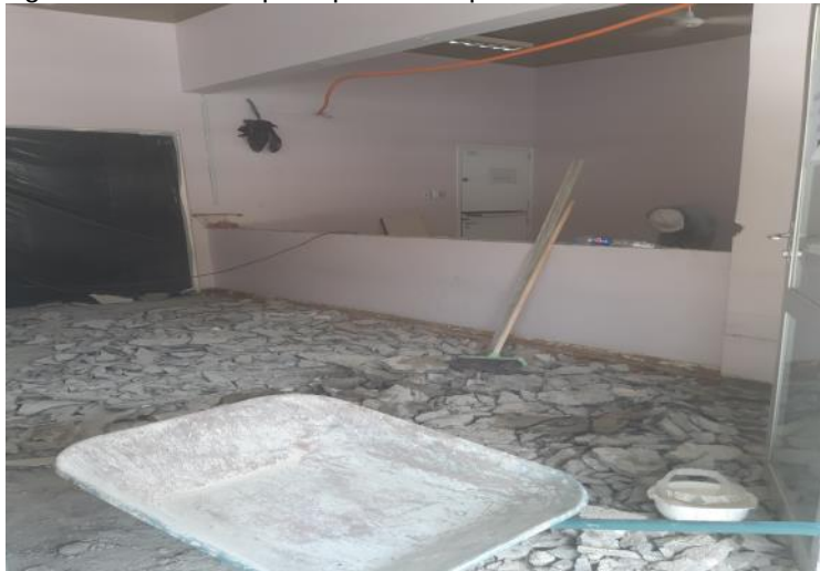
Figura 62 - Entrada principal do hospital em obras
