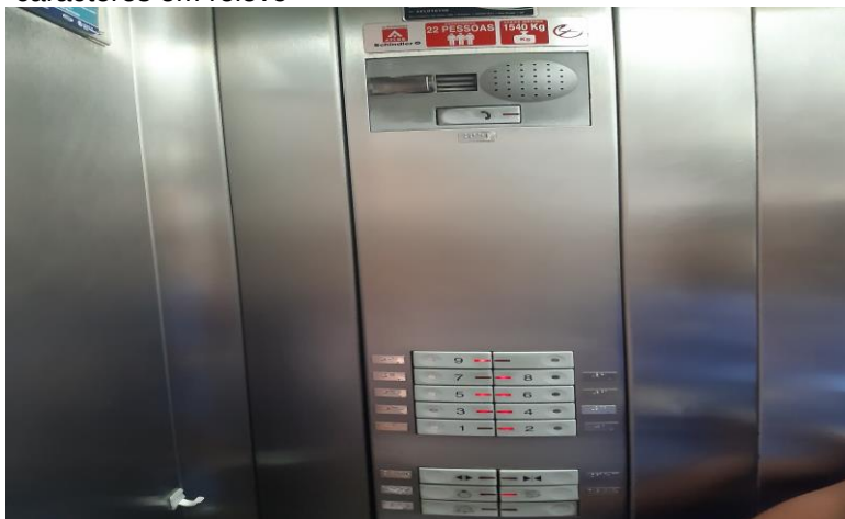
Figura 109 - Botoeiras com informações em Braille, mas sem caracteres em relevo
