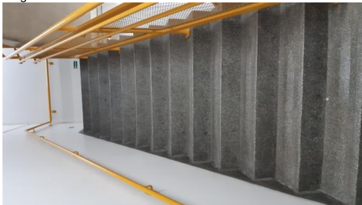
Figura 58 - Escada com corrimão de uma altura em um dos lados
