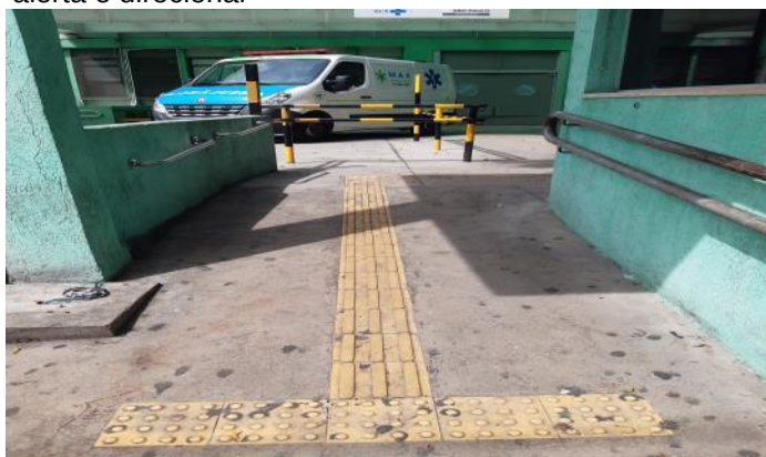
Figura 44 - Entrada principal do hospital com piso tátil de alerta e direcional
