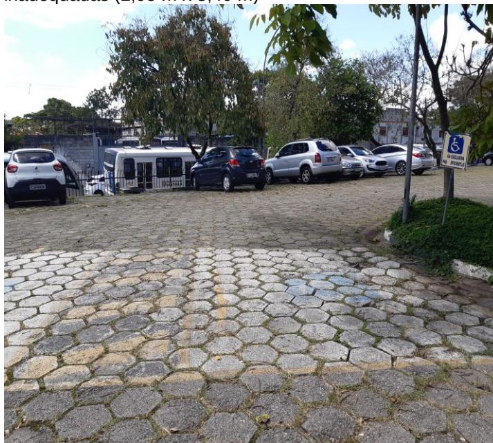
Figura 103 - Vagas acessíveis com dimensões inadequadas (2,95 m x 3,40 m)
