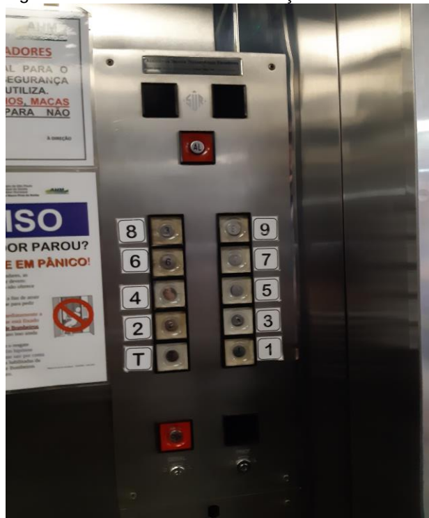
Figura 37 - Botoeiras sem informações em Braille
