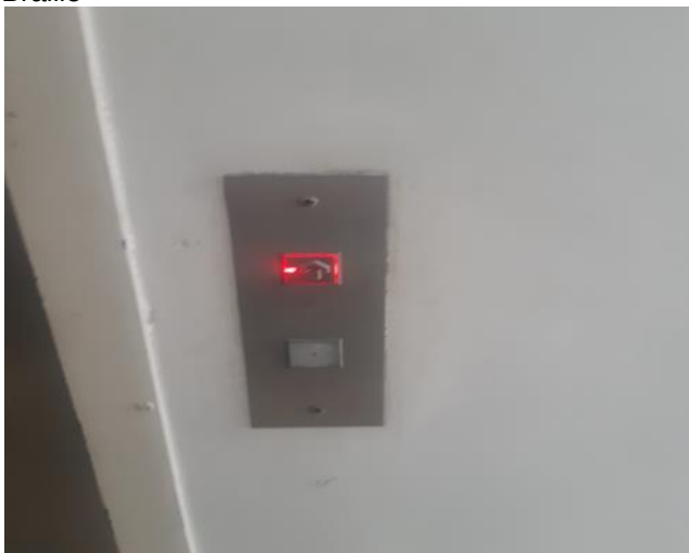
Figura 46 - Pannel de chamada sem informações em Braille
