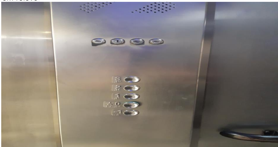
Figura 84 - Botoeiras do elevador com informações em Braille e caracteres em relevo
