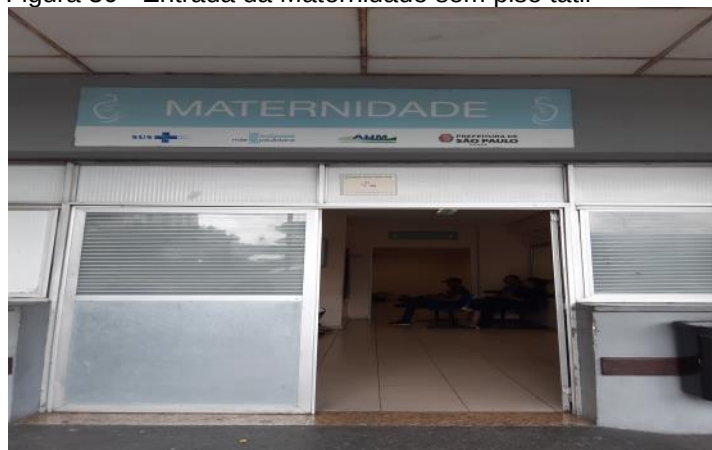
Figura 30 - Entrada da Maternidade sem piso tátil
