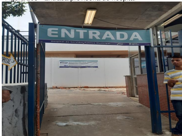
Figura 105 - Entrada provisória do hospital
