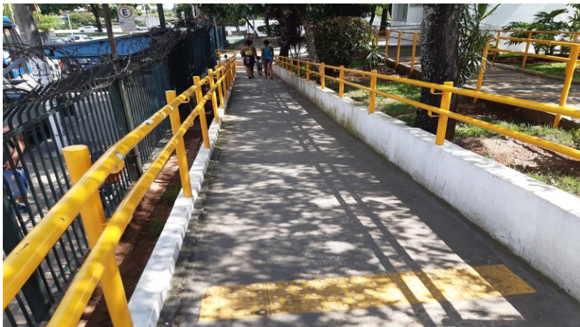
Figura 99 - Rampa de acesso ao PS com piso de alerta e corrimão de duas alturas
