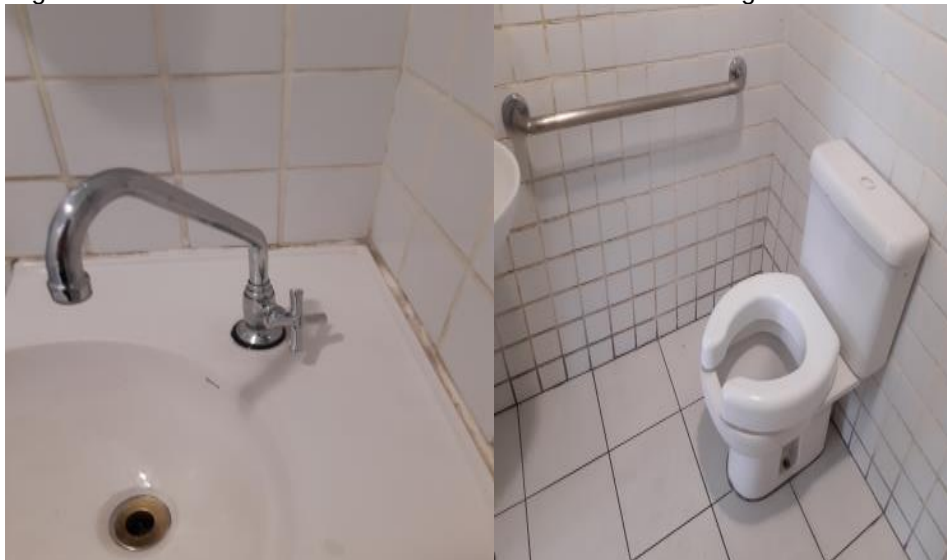
Figura 69 - Sanitário do PS com abertura frontal e torneira de girar
