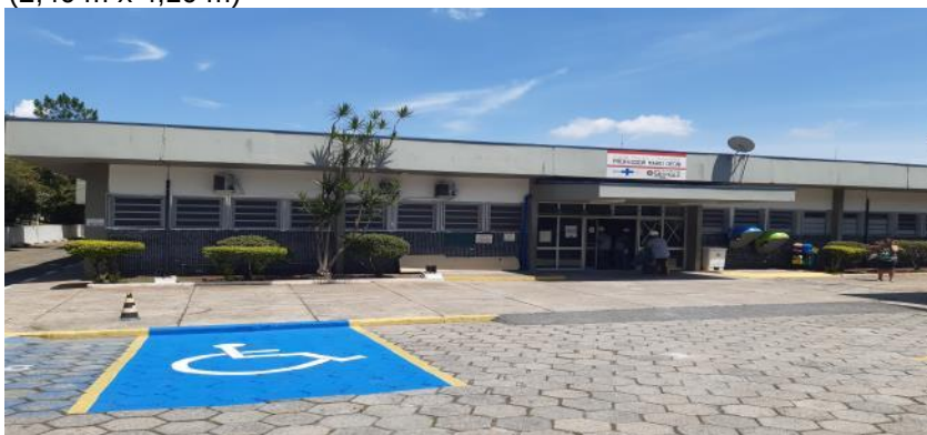
Figura 65 - Vaga acessível com dimensões inadequadas (2,40 m x 4,10 m)
