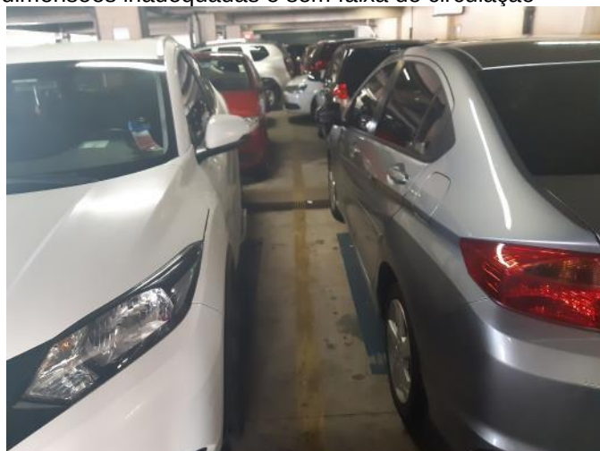
Figura 36 - Vagas reservadas de deficientes com dimensões inadequadas e sem faixa de circulação
