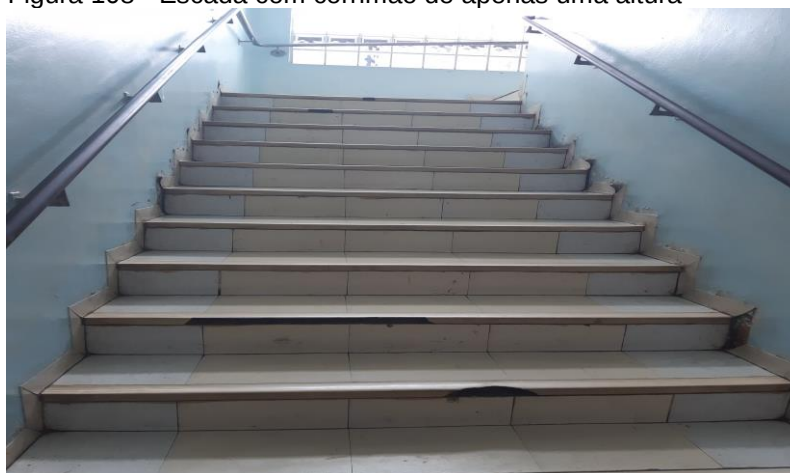
Figura 108 - Escada com corrimão de apenas uma altura
