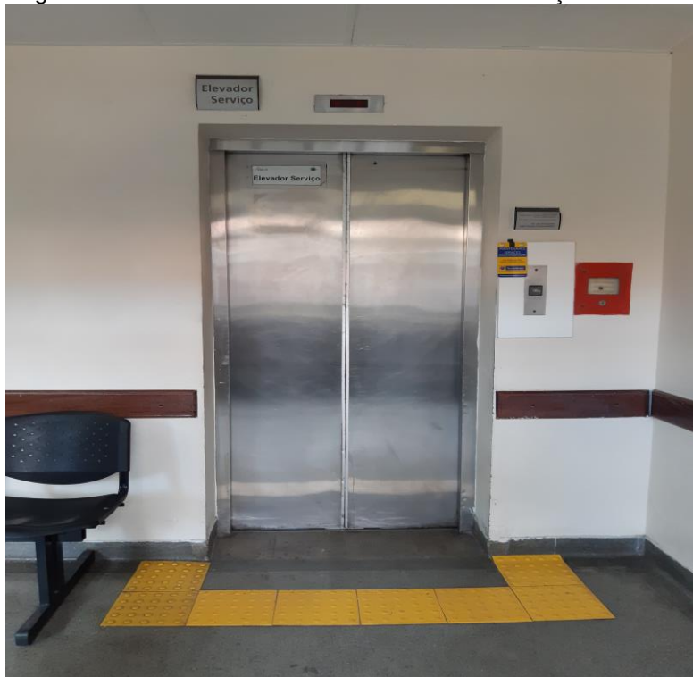
Figura 104 - Botoeira de acionamento sem informação em Braille
