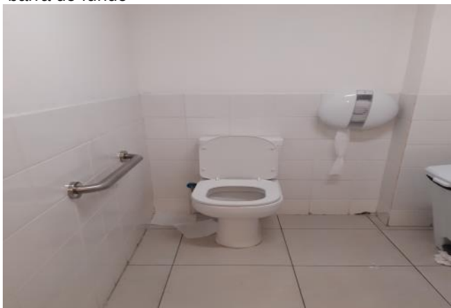
Figura 43 - Sanitário da recepção de visitantes sem barra do fundo
