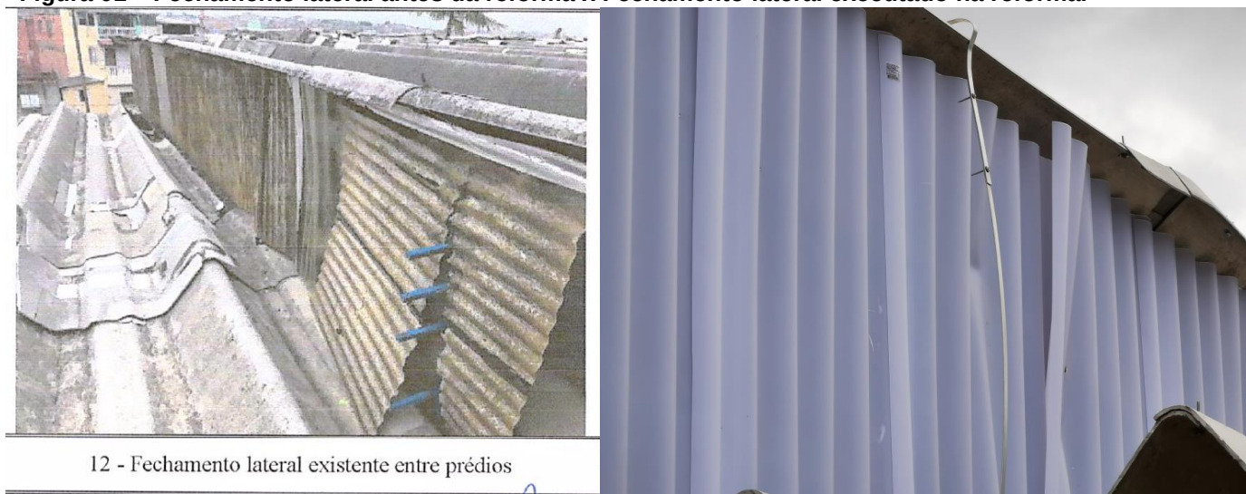
Figura 01 – Fechamento lateral antes da reforma x Fechamento lateral executado na reforma.
