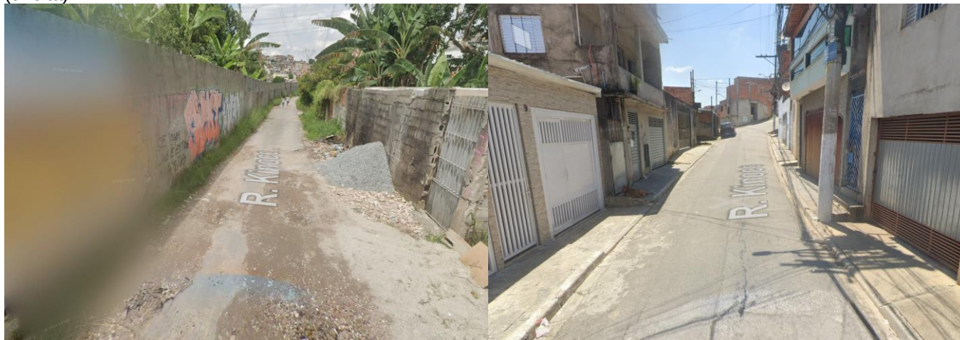
Figura 9 - Situação da Rua Kinoco no trecho 1 em situação de rua de terra (esquerda) e trecho 2 já pavimentado (direita)
