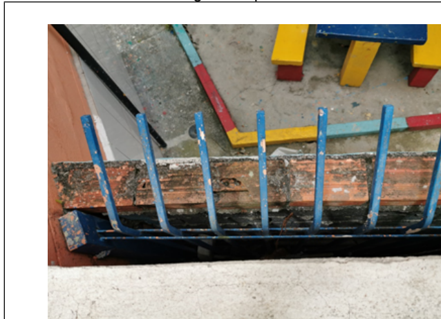
Foto 9 - Vão aberto entre grade e parede
