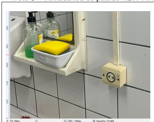
Foto 8 – Tomada fora do padrão NBR 14.136
