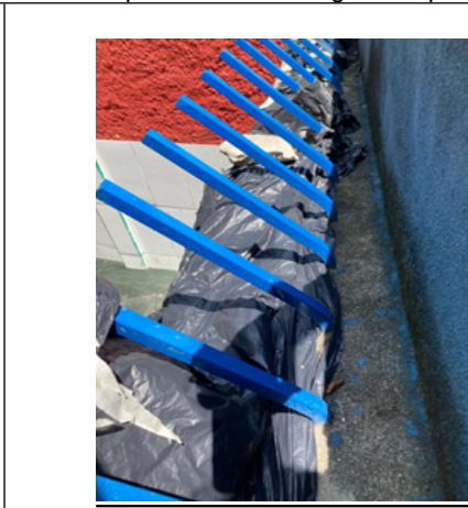
Foto 10 - Vão preenchido entre grade e parede
