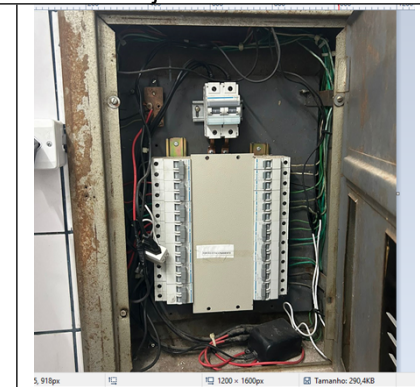
Foto 7 – Disjuntor novo
