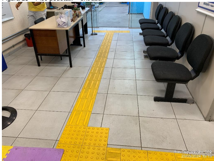
Figura 15 – Piso podotátil – entrada
