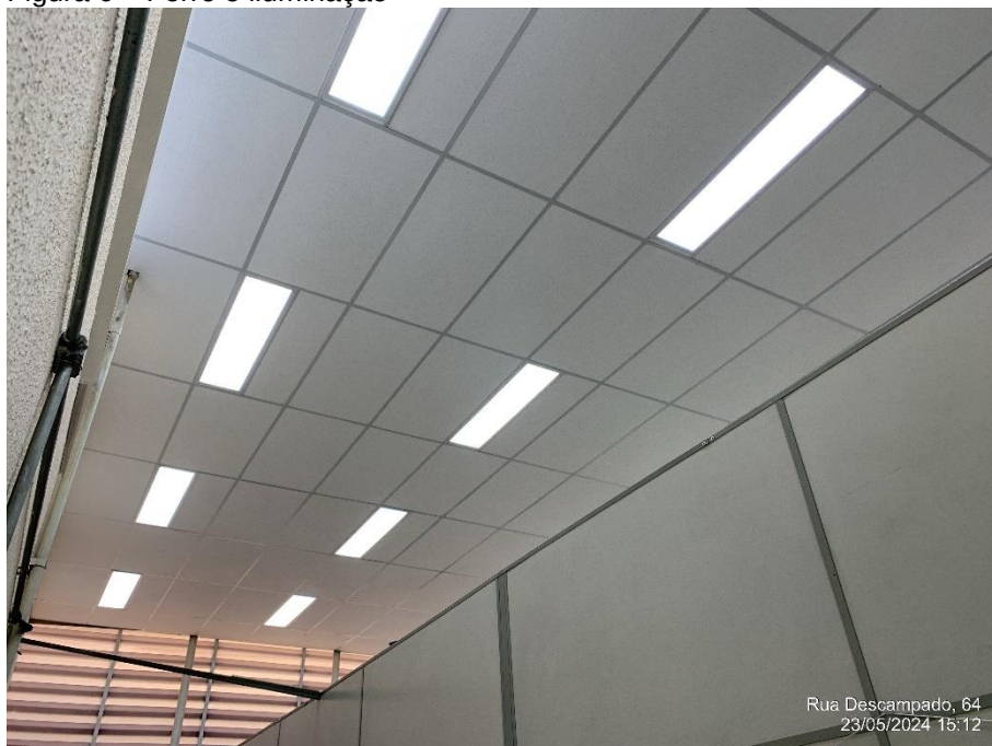
Figura 6 – Forro e iluminação
