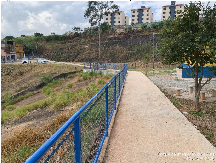
Figura 39 – Gradis sobre a mureta de contenção
