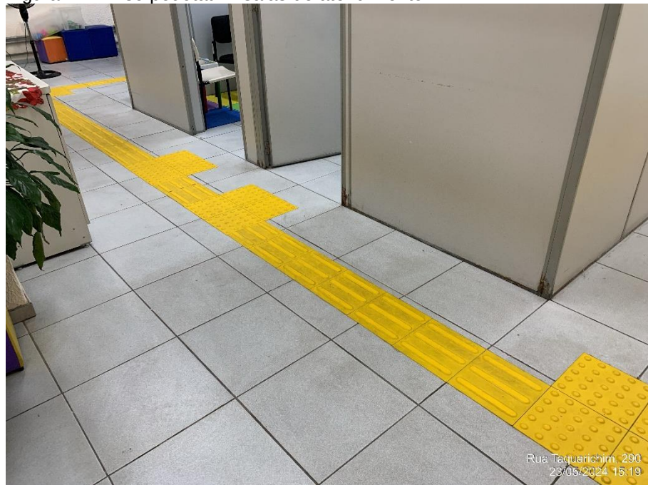
Figura 14 – Piso podotátil – salas de atendimento
