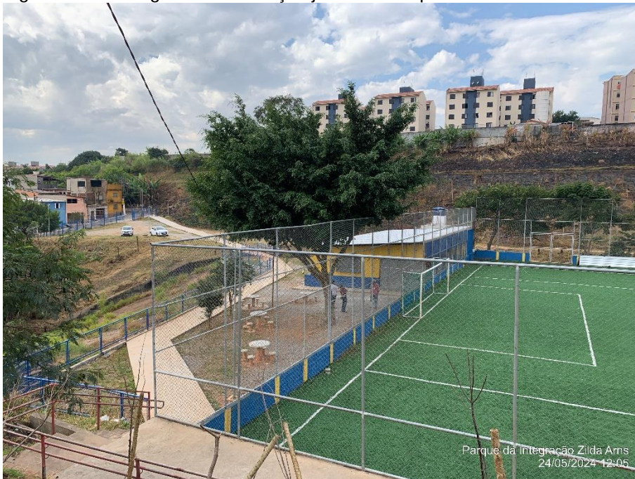
Figura 42 – Vista geral da edificação junto ao campo de futebol
