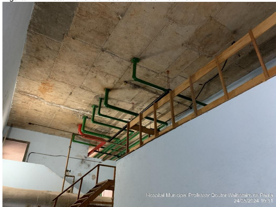
Figura 74 – Vista inferior do reservatório com barrilete
