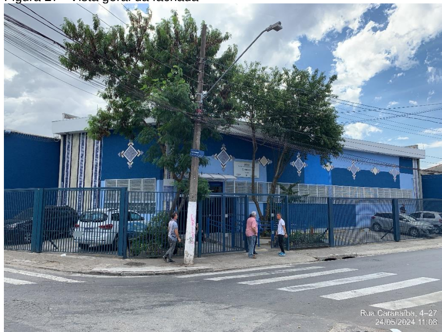
Figura 27– Vista geral da fachada
