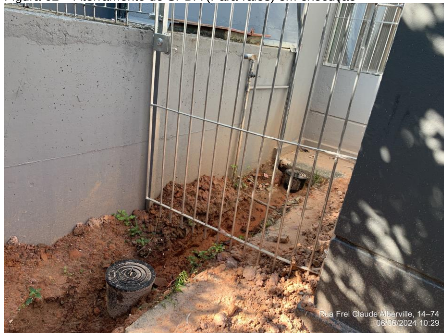
Figura 62 – Aterramento do SPDA (Para-raios) em execução
