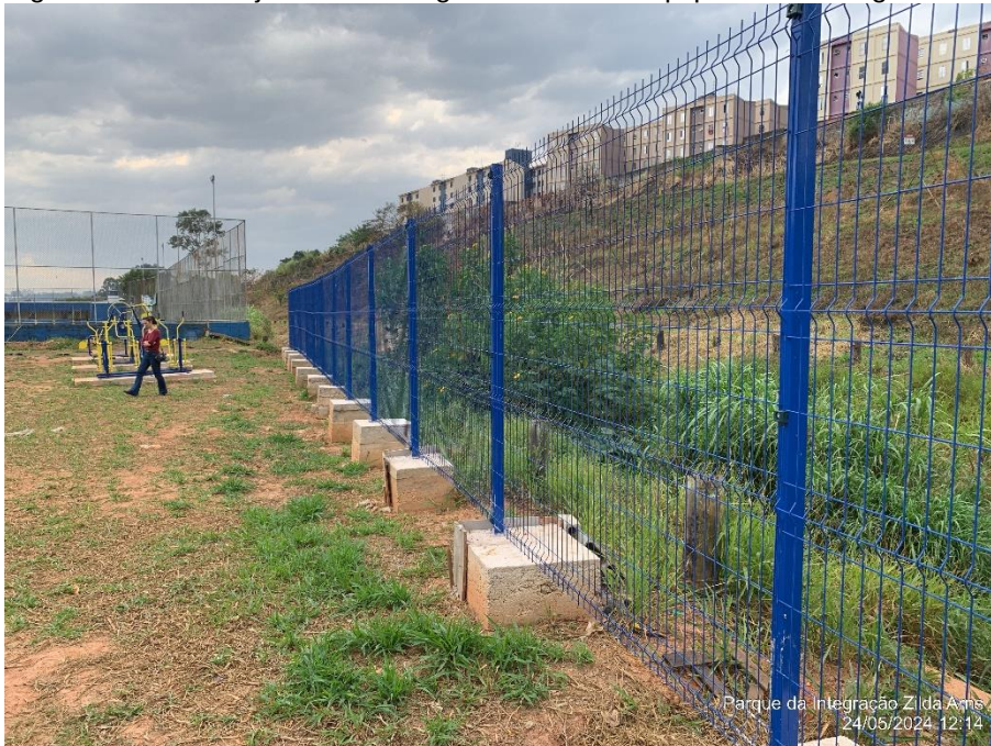
Figura 53 – Gradis junto ao córrego na área dos equipamentos de ginástica
