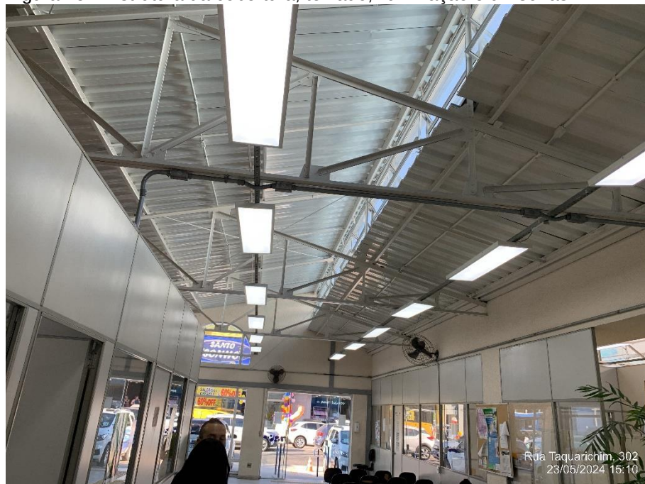
Figura 25 – Estrutura da cobertura, telhado, iluminação e divisórias
