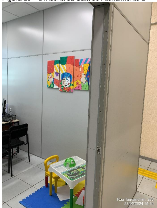
Figura 10 – Divisória da Sala de Atendimento 2
