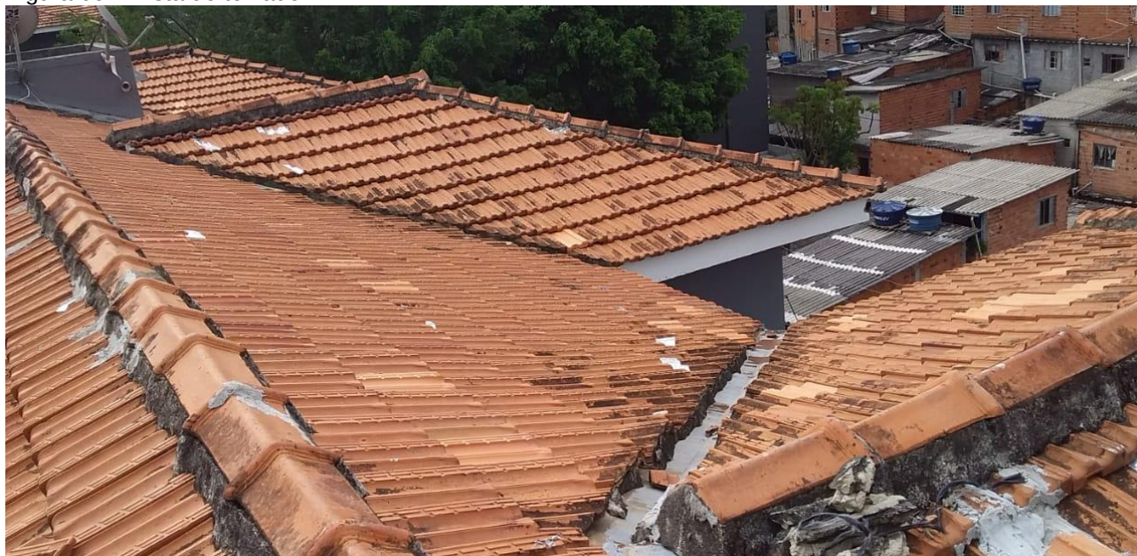
Figura 66 – Vista do telhado
