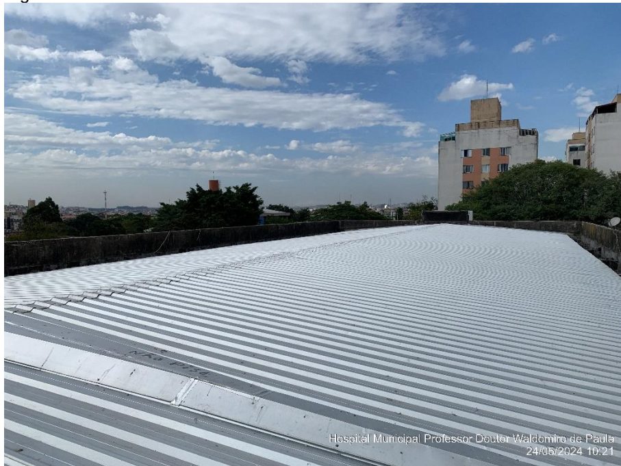
Figura 69 – Vista do telhado
