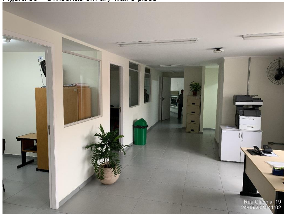
Figura 30 – Divisórias em dry-wall e pisos
