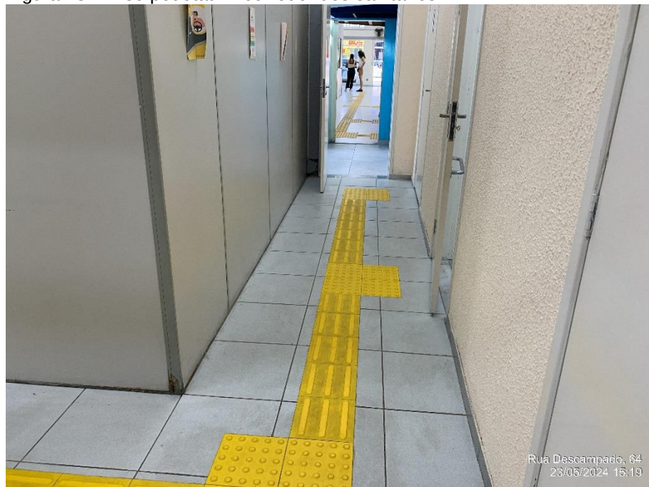
Figura 13 – Piso podotátil – corredor dos sanitários
