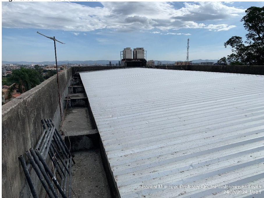
Figura 68 – Vista do telhado
