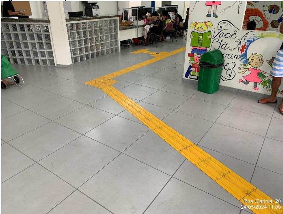
Figura 33 – Piso podotátil
