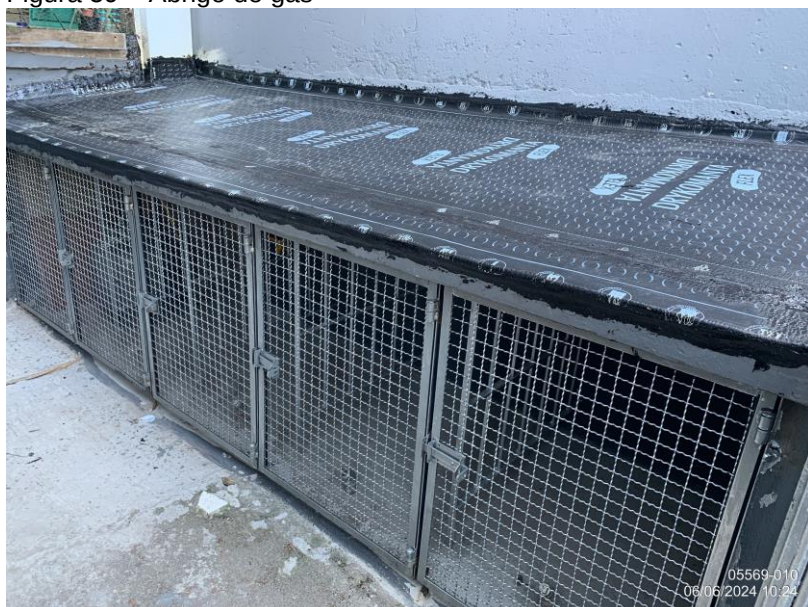
Figura 59 – Abrigo de gás
