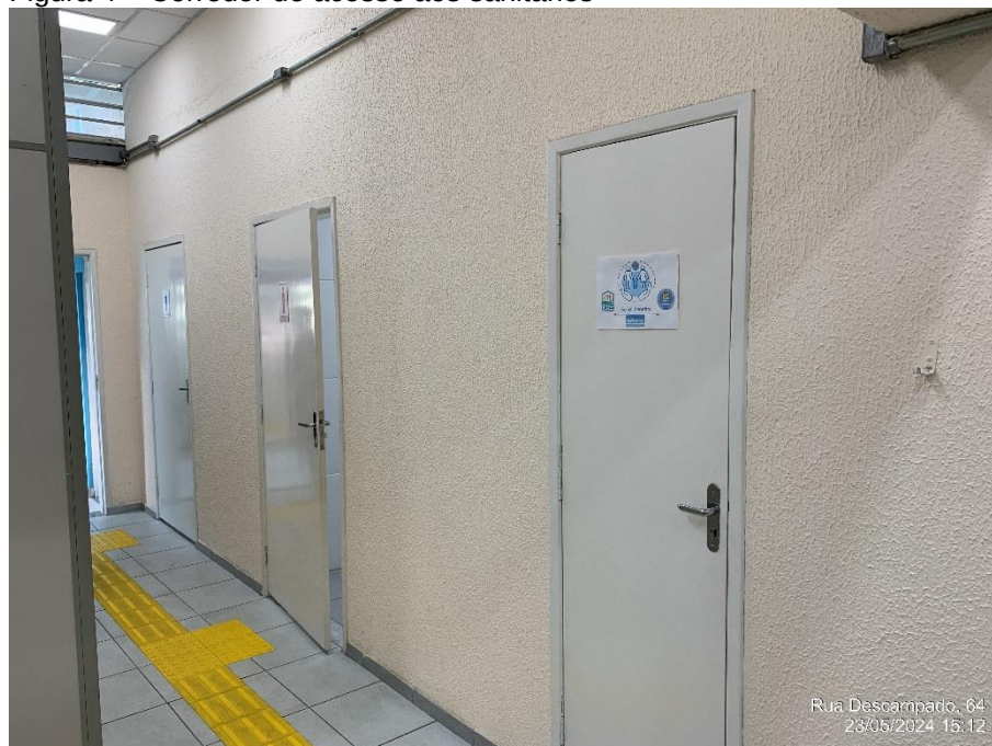
Figura 4 – Corredor de acesso aos sanitários
