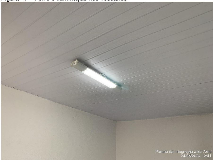
Figura 47 – Forro e iluminação nos vestiários
