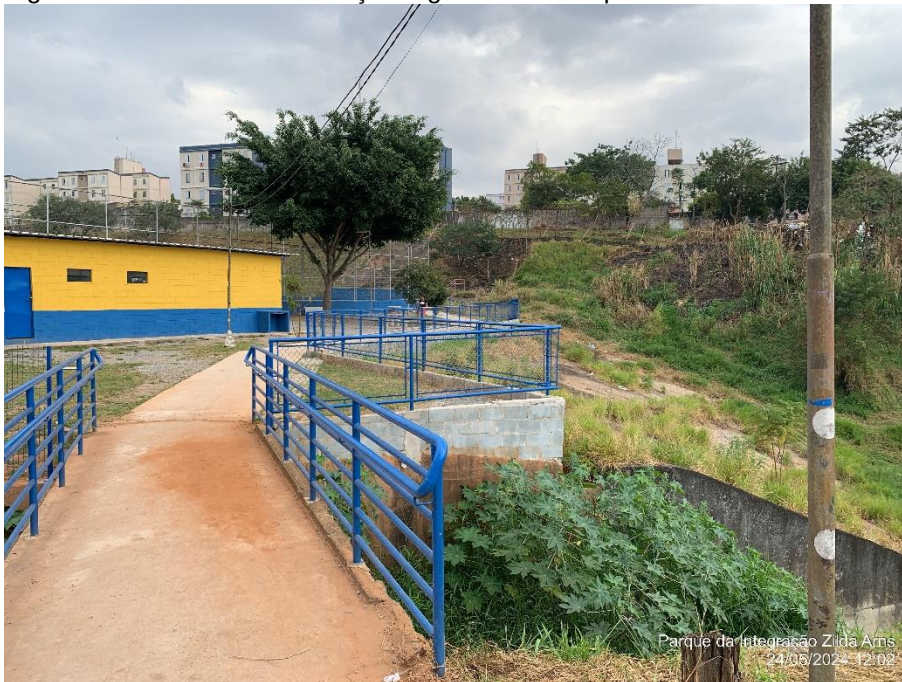
Figura 38 – Mureta de contenção e gradis sobre o pontilhão e muretas
