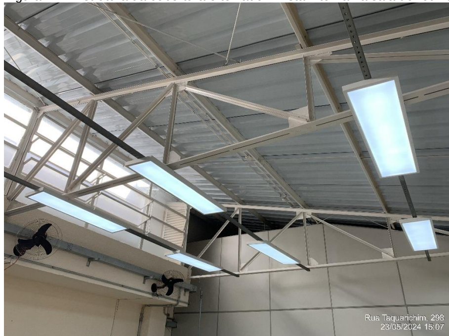
Figura 22 – Estrutura da cobertura e telhado – vista interna na sala de reunião
