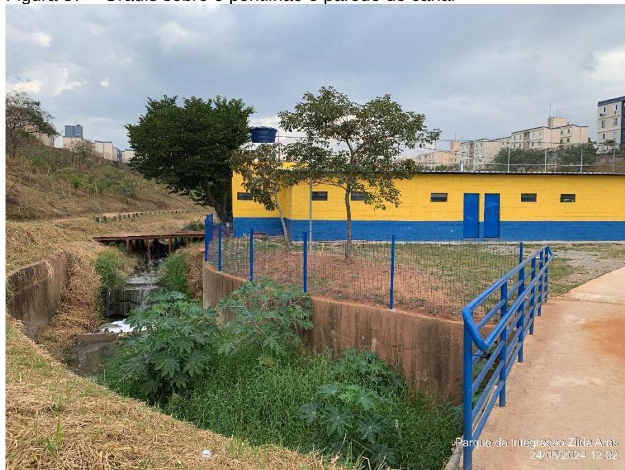
Figura 37 – Gradis sobre o pontilhão e parede do canal
