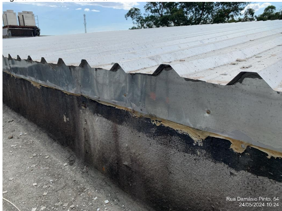
Figura 70 – Detalhe da telha
