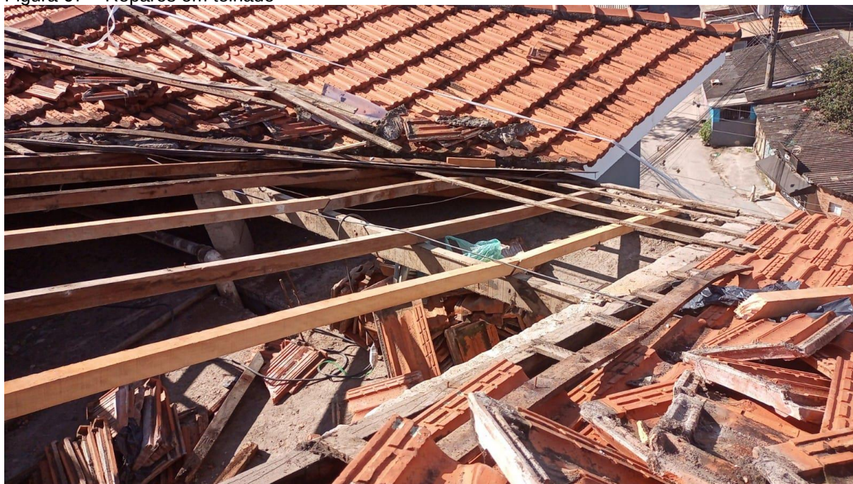
Figura 67 – Reparos em telhado
