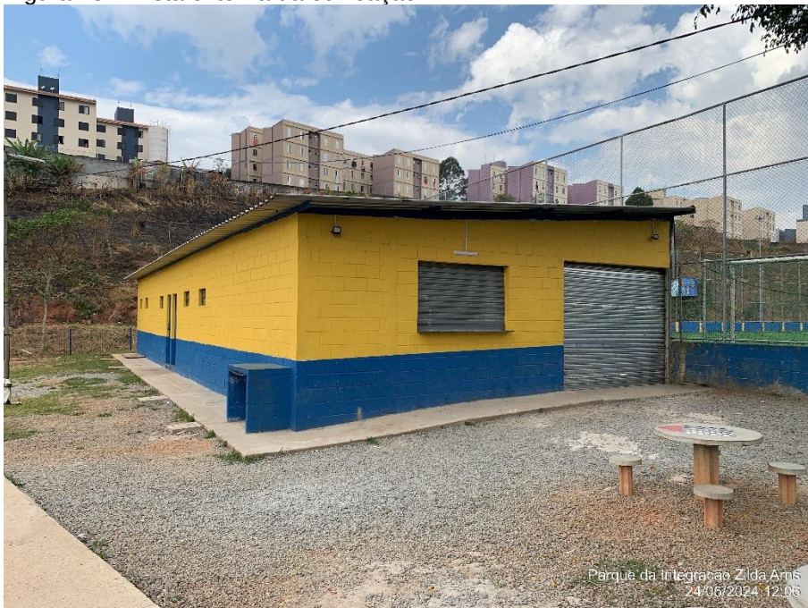
Figura 43 – Vista externa da edificação
