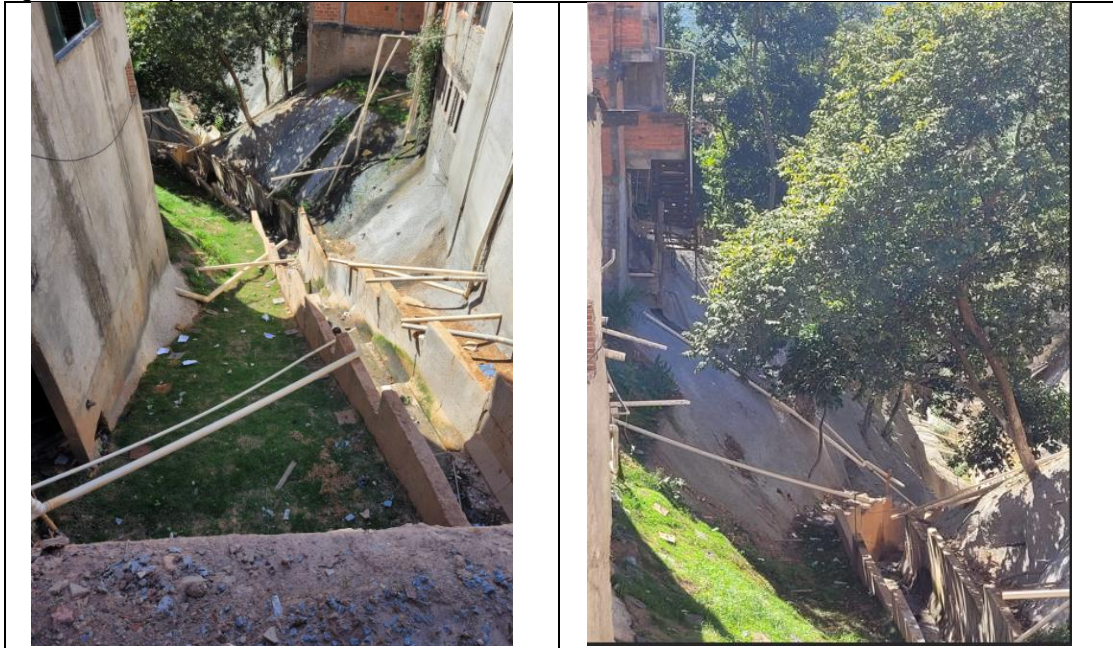
Figura 2 - Obra já concluída
