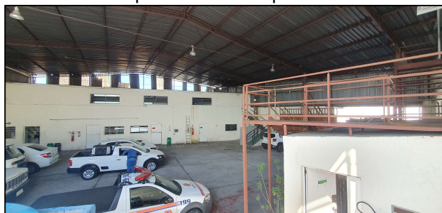
Figura 8 - Vista geral do estacionamento e área operacional de depósito
