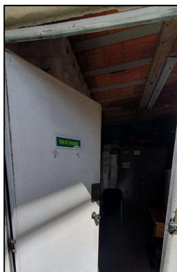
Figura 13 – Entrada do local indicado para uso como vestiário para a contratante
