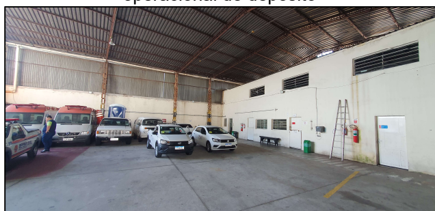
Figura 10 - Vista geral do estacionamento e área operacional de depósito
