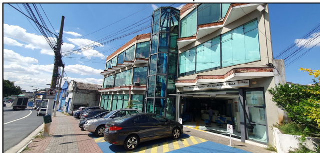
Figura 1 - Vista da Fachada frontal do edifício sede com vidros limpos
