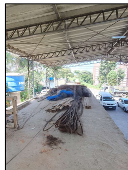
Figura 36 – Materiais para uso nas obras da subprefeitura armazenados na cobertura
