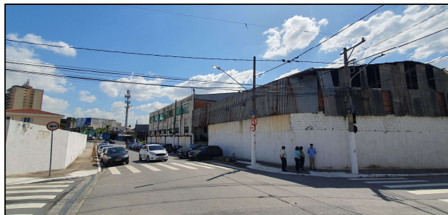
Figura 2 - Vista externa dos fundos da edificação Sede
