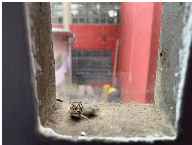
3.6. Área interna suja (detalhe)
