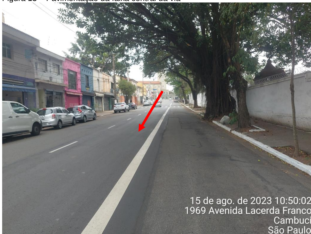
Figura 15 – Pavimentação da faixa central da via
