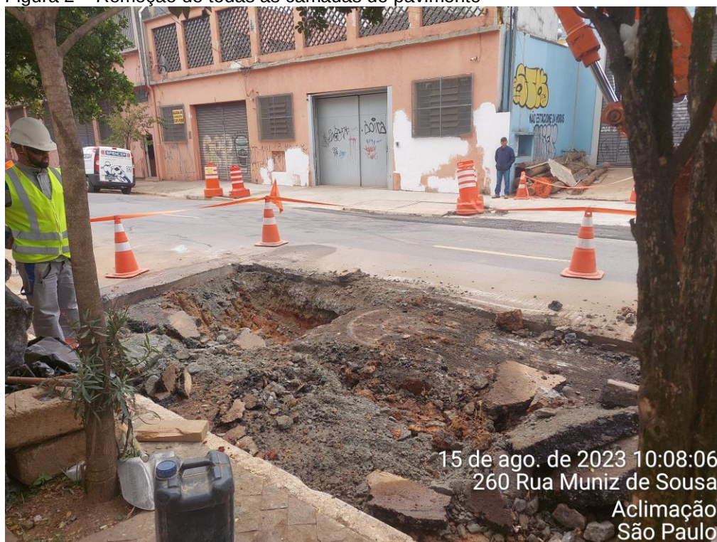
Figura 2 – Remoção de todas as camadas do pavimento
