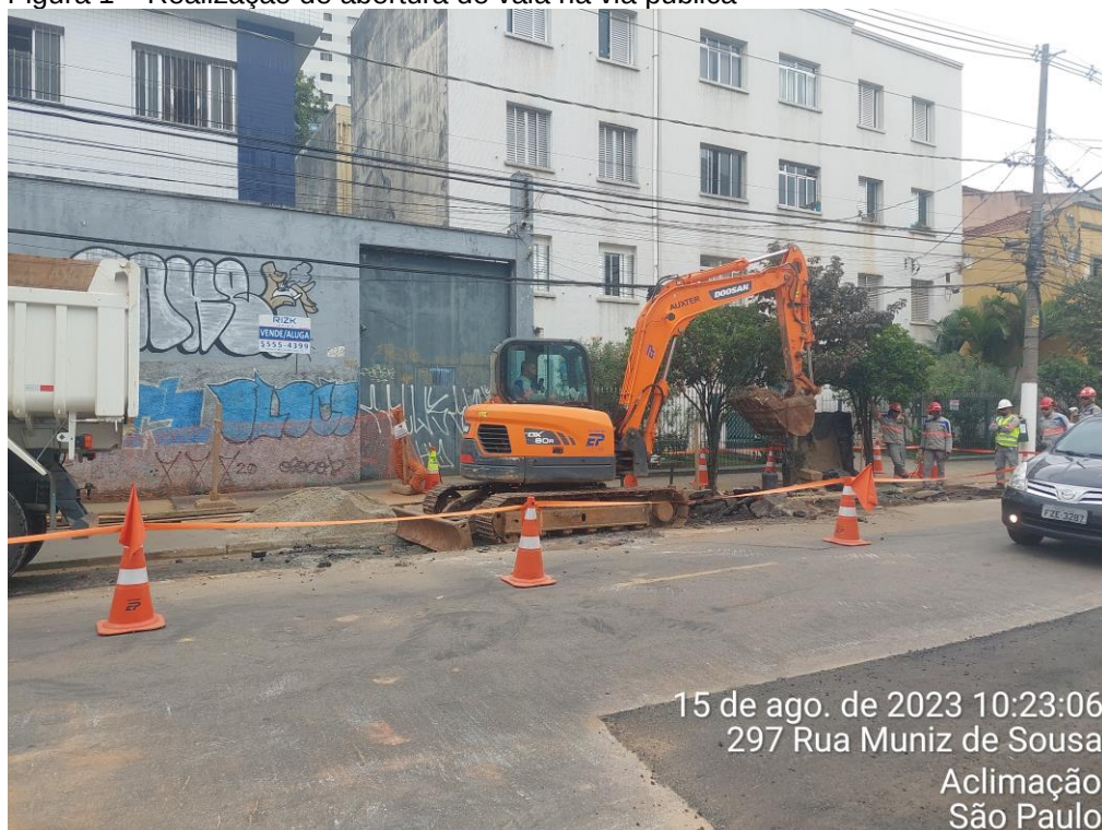
Figura 1 – Realização de abertura de vala na via pública
