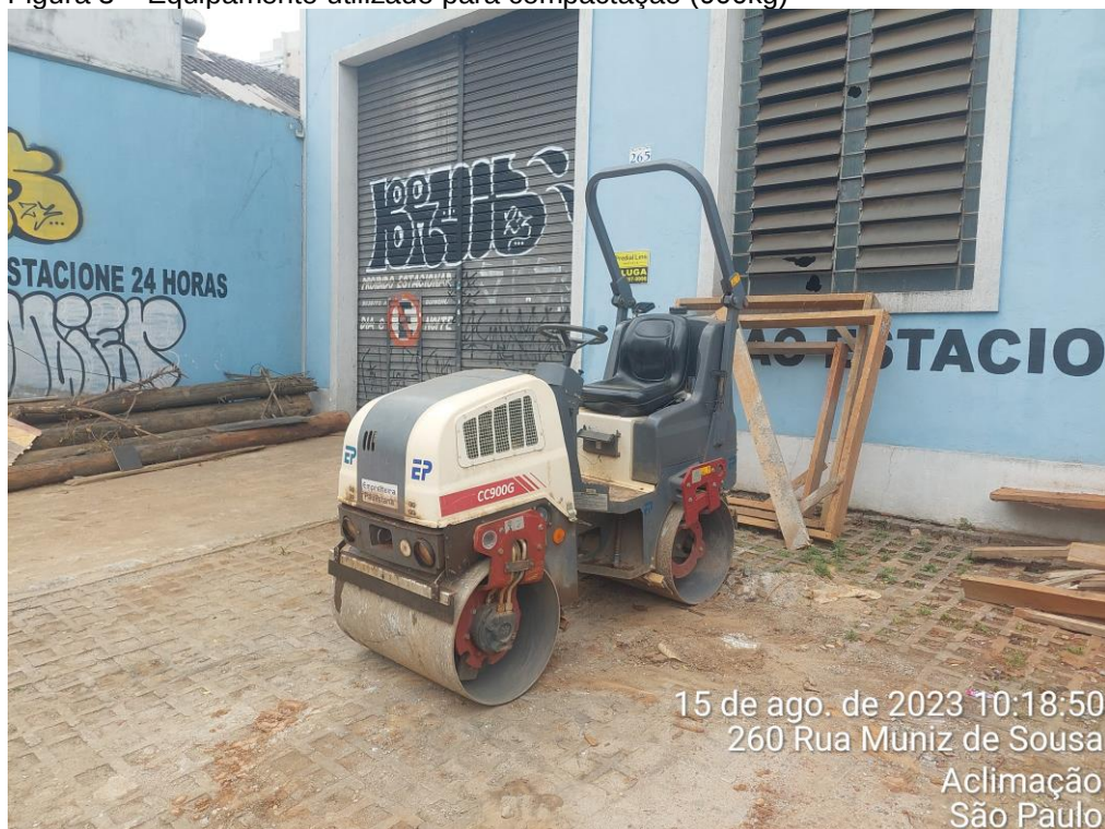
Figura 3 – Equipamento utilizado para compactação (900kg)
