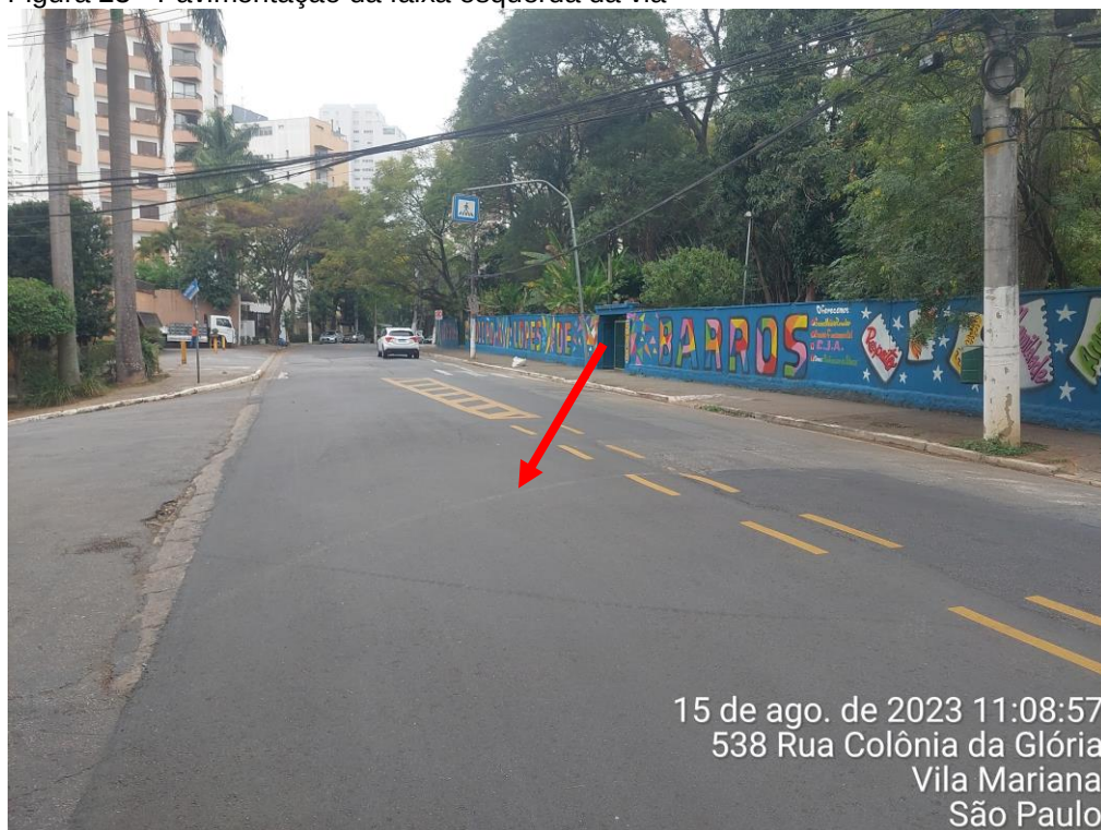
Figura 23 - Pavimentação da faixa esquerda da via
