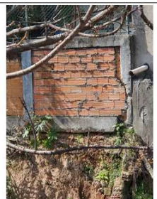
Exposição das fundações do muro da AMA Capão Redondo
