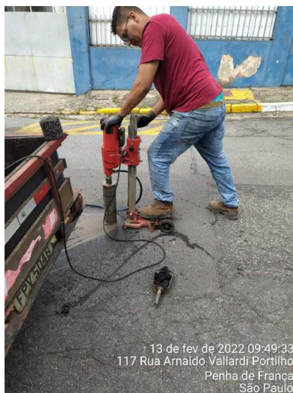
Foto 24: Detalhe do broqueamento para aferição de espessura da camada asfáltica
