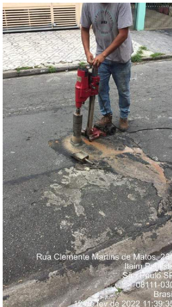
Foto 18: Detalhe do broqueamento para aferição de espessura da camada asfáltica
