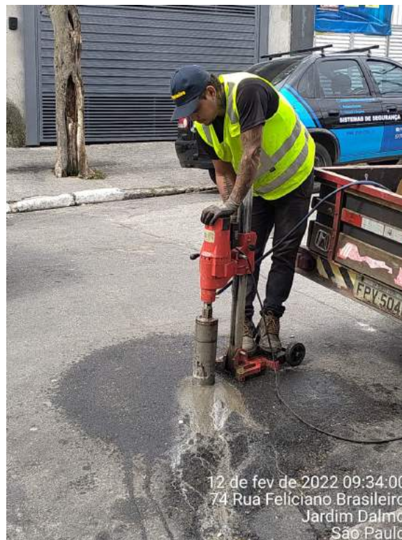
Foto 8: Detalhe do broqueamento para aferição de espessura da camada asfáltica
