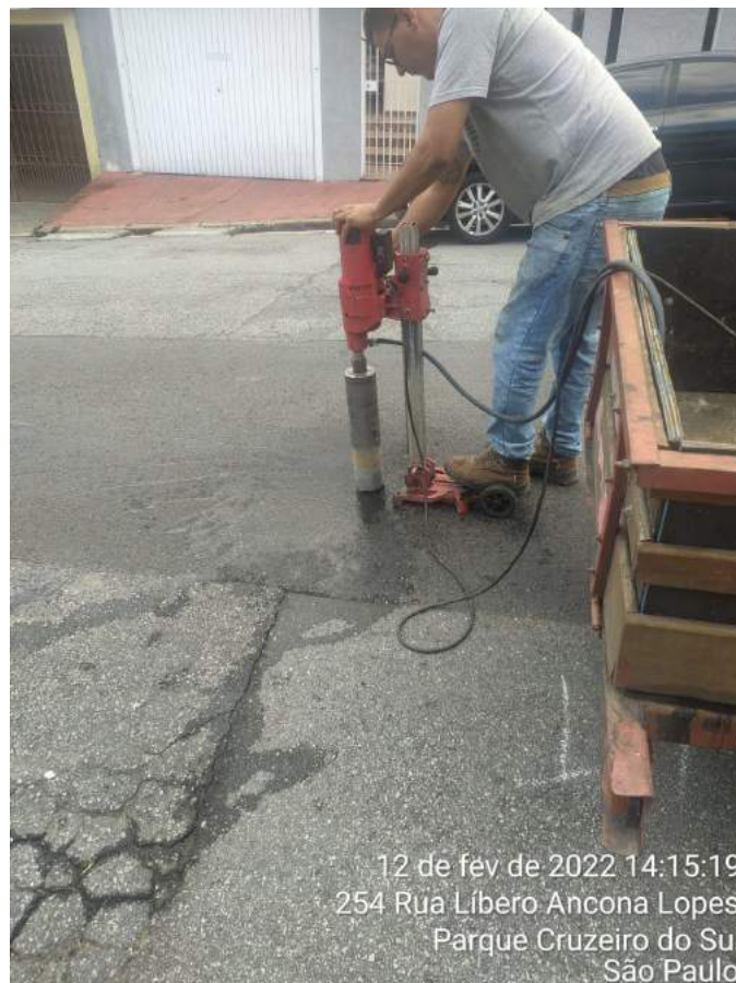
Foto 30: Detalhe do broqueamento para aferição de espessura da camada asfáltica
