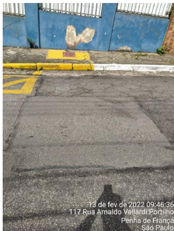
Foto 23: Detalhe da integridade dos serviços executados.
