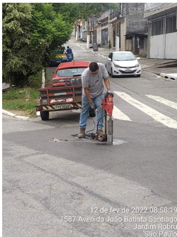
Foto 21: Detalhe do broqueamento para aferição de espessura da camada asfáltica
