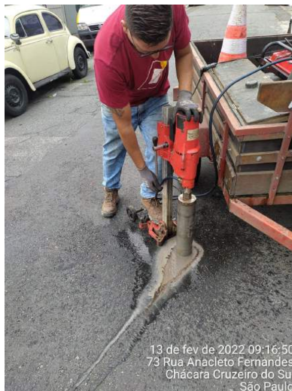
Foto 27: Detalhe do broqueamento para aferição de espessura da camada asfáltica
