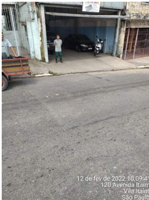
Foto 4: Detalhe da integridade dos serviços executados.
