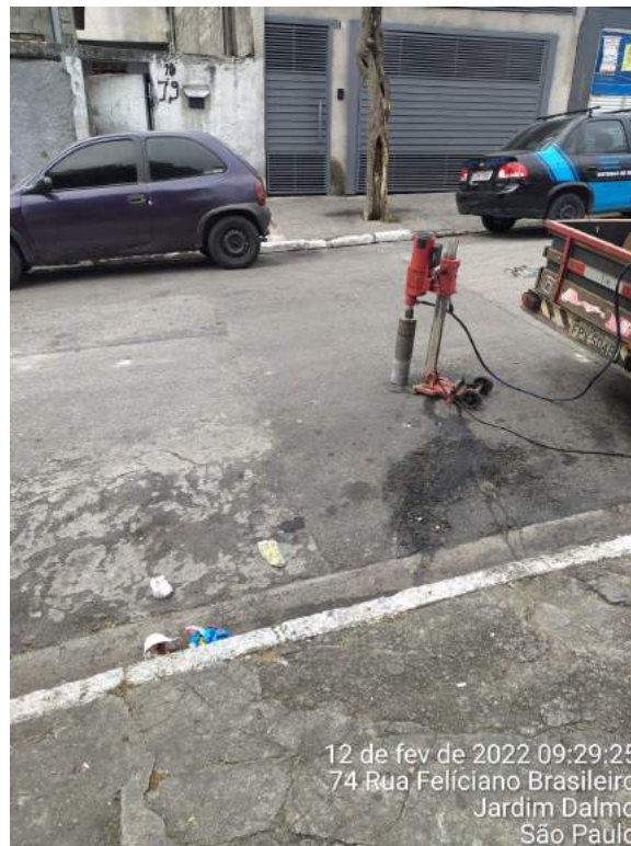
Foto 7: Detalhe da integridade dos serviços executados.
