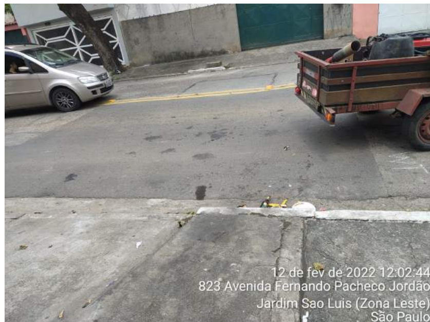
Foto 32: Detalhe da integridade dos serviços executados.
