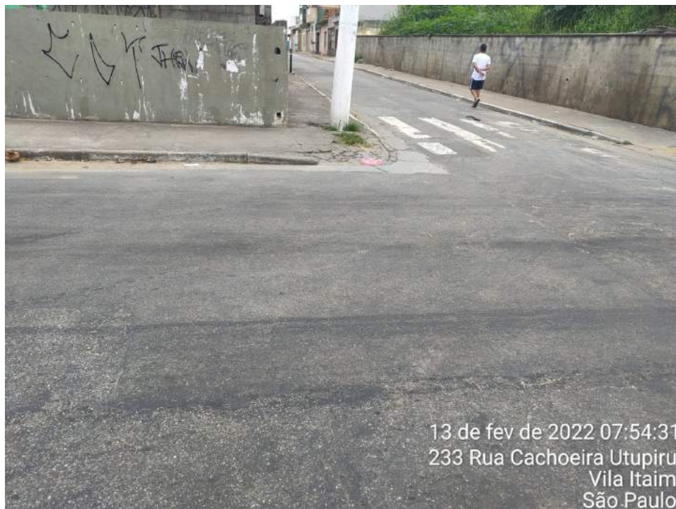
Foto 13: Detalhe da integridade dos serviços executados.
