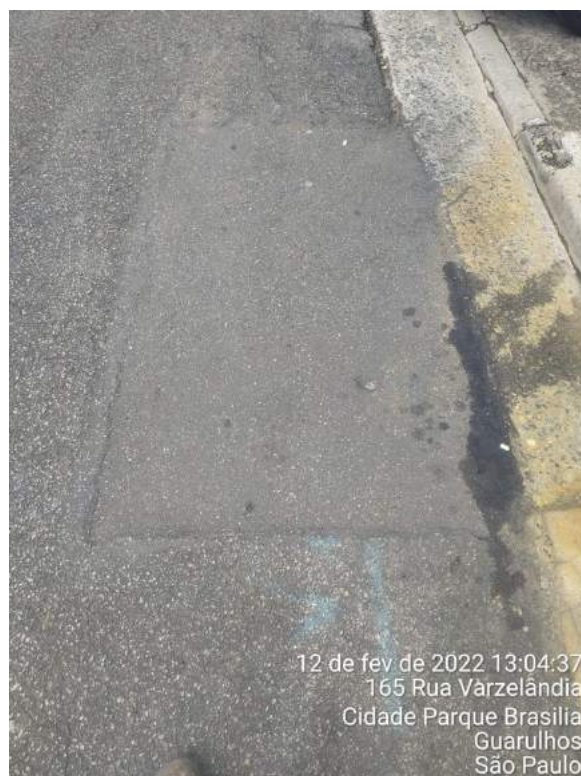
Foto 10: Detalhe da integridade dos serviços executados.
