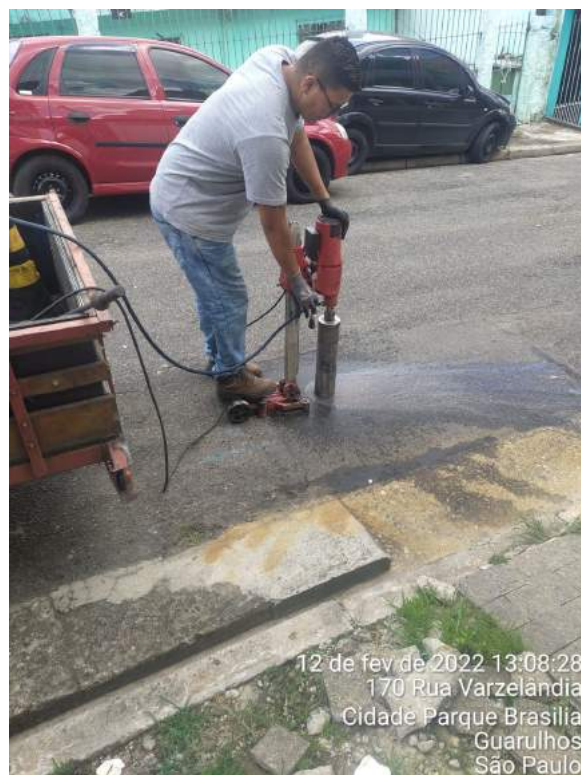
Foto 11: Detalhe do broqueamento para aferição de espessura da camada asfáltica
