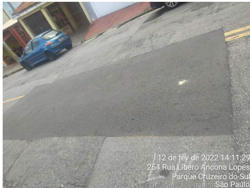
Foto 29: Detalhe da integridade dos serviços executados.
