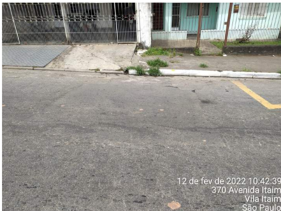
Foto 1: Detalhe da integridade dos serviços executados.
