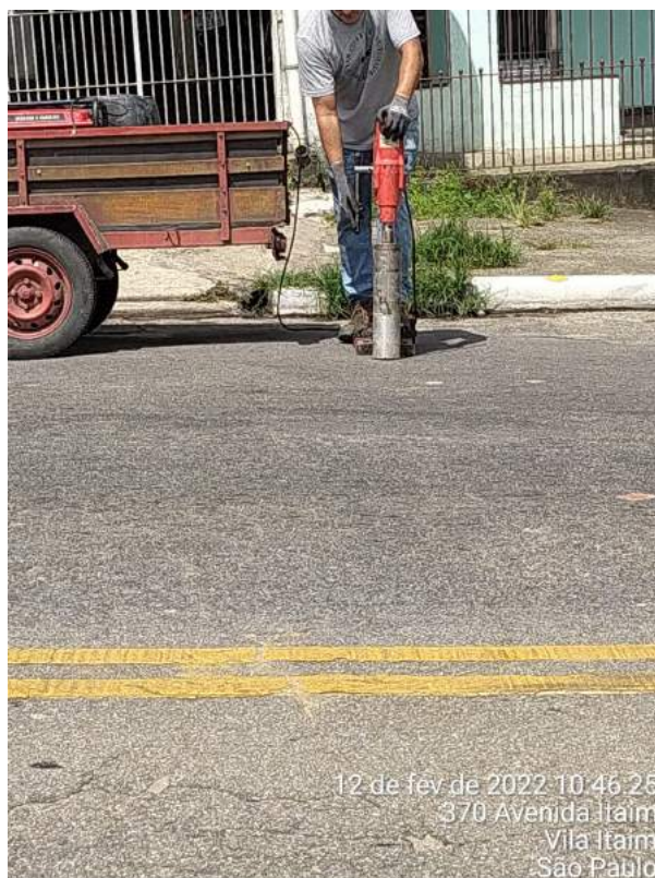
Foto 2: Detalhe do broqueamento para aferição de espessura da camada asfáltica
