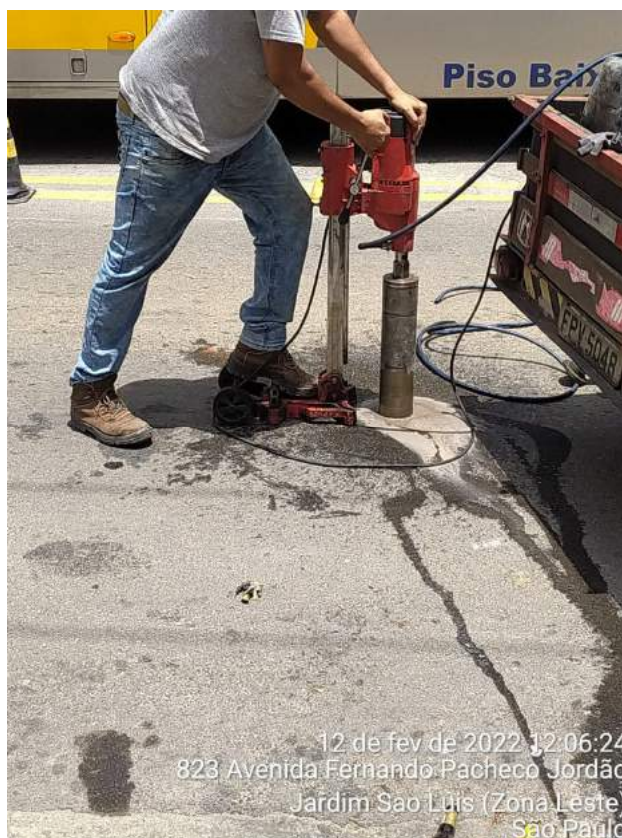
Foto 33: Detalhe do broqueamento para aferição de espessura da camada asfáltica
