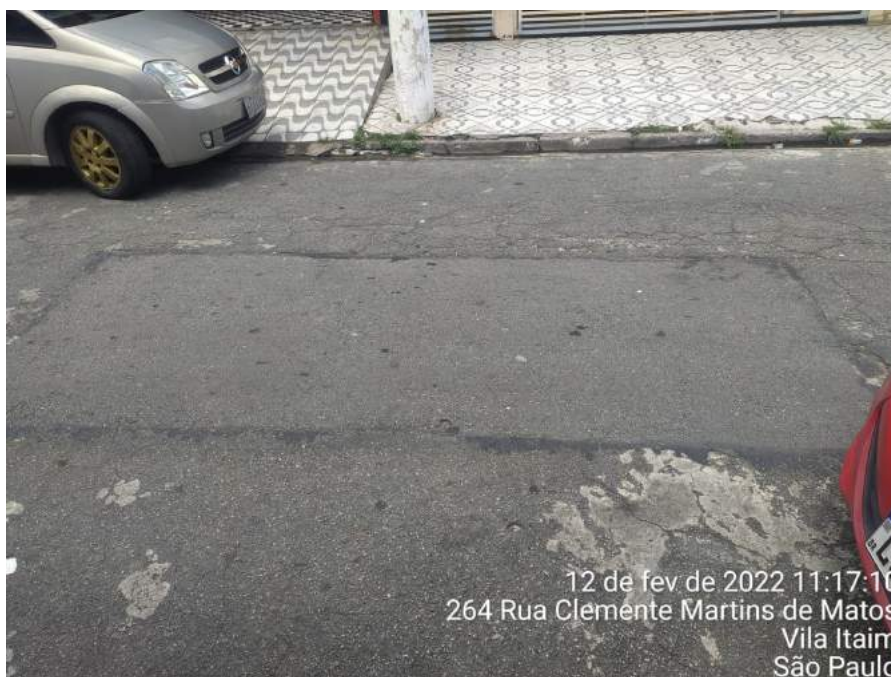
Foto 17: Detalhe da integridade dos serviços executados.
