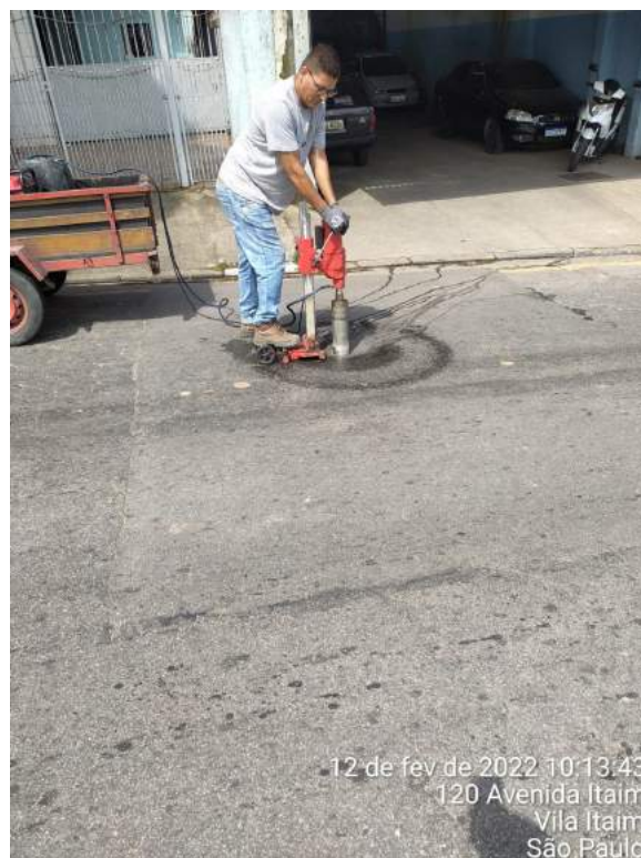
Foto 5: Detalhe do broqueamento para aferição de espessura da camada asfáltica
