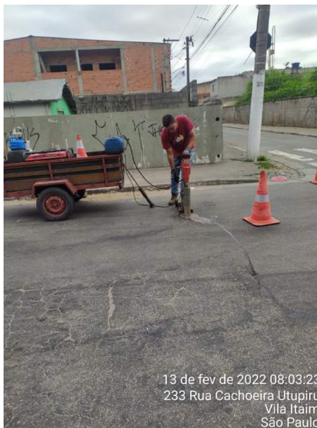
Foto 14: Detalhe do broqueamento para aferição de espessura da camada asfáltica
