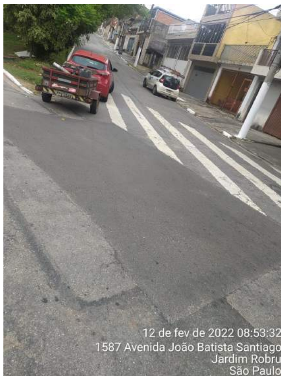
Foto 20: Detalhe da integridade dos serviços executados.
