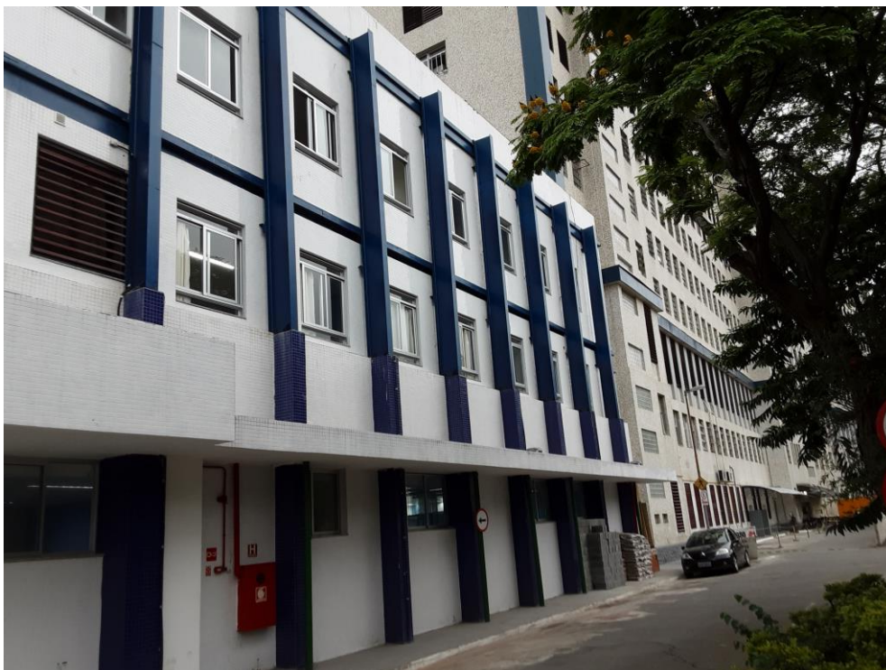
Figura 9 – Vista da fachada oposta à entrada do Complexo.
