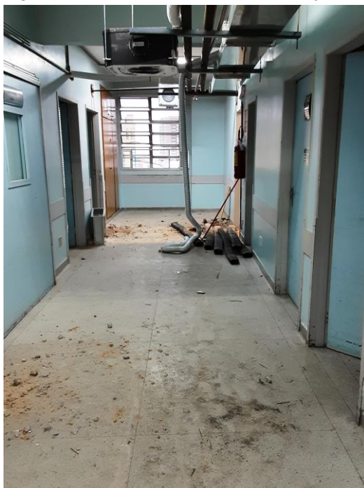
Figura 85 – Dutos: sistema de ar a implantar.
