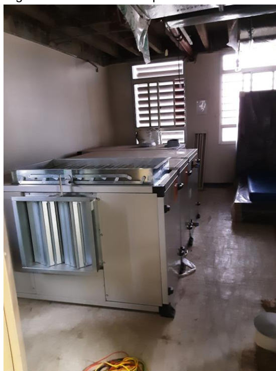
Figura 75 – Casa de máquinas em obras.
