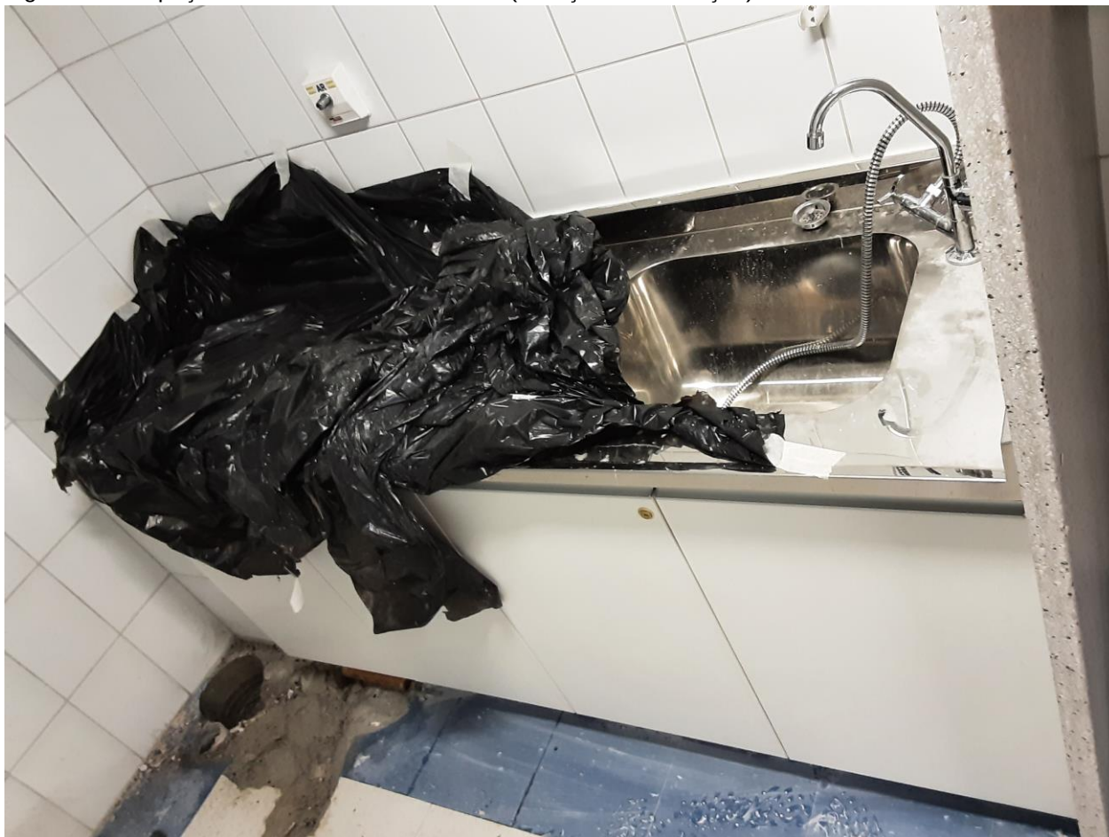
Figura 45 – Espaço com reforma não concluída (serviços de tubulação).
