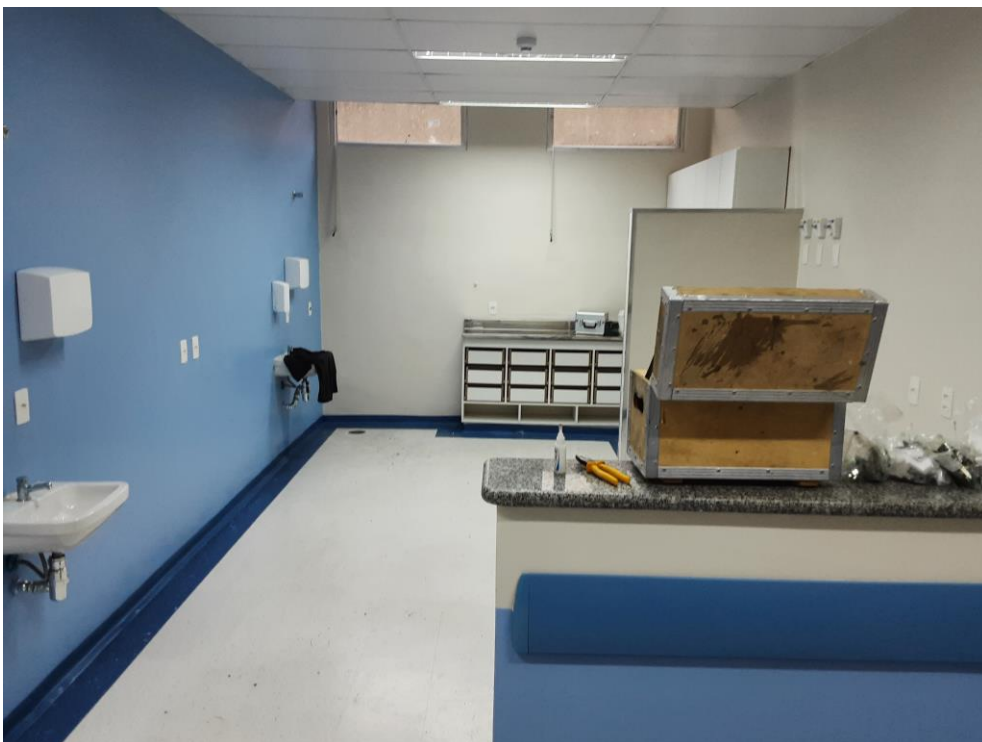
Figura 57 – Mobiliários em montagem.
