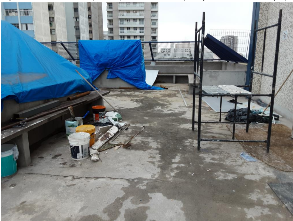
Figura 19 – Cobertura do prédio que foi construído (serviços ainda em execução).
