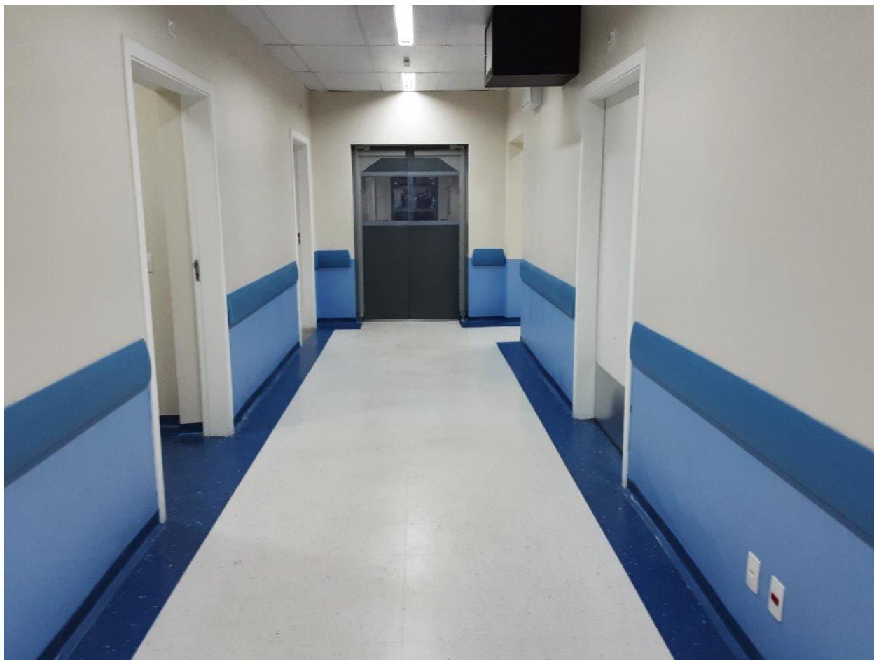
Figura 28 – Visão do corredor e entradas dos consultórios pós-reforma.
