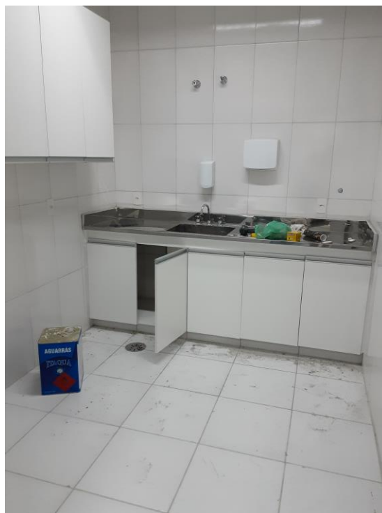
Figura 63 – Obras e mobiliário em montagem.
