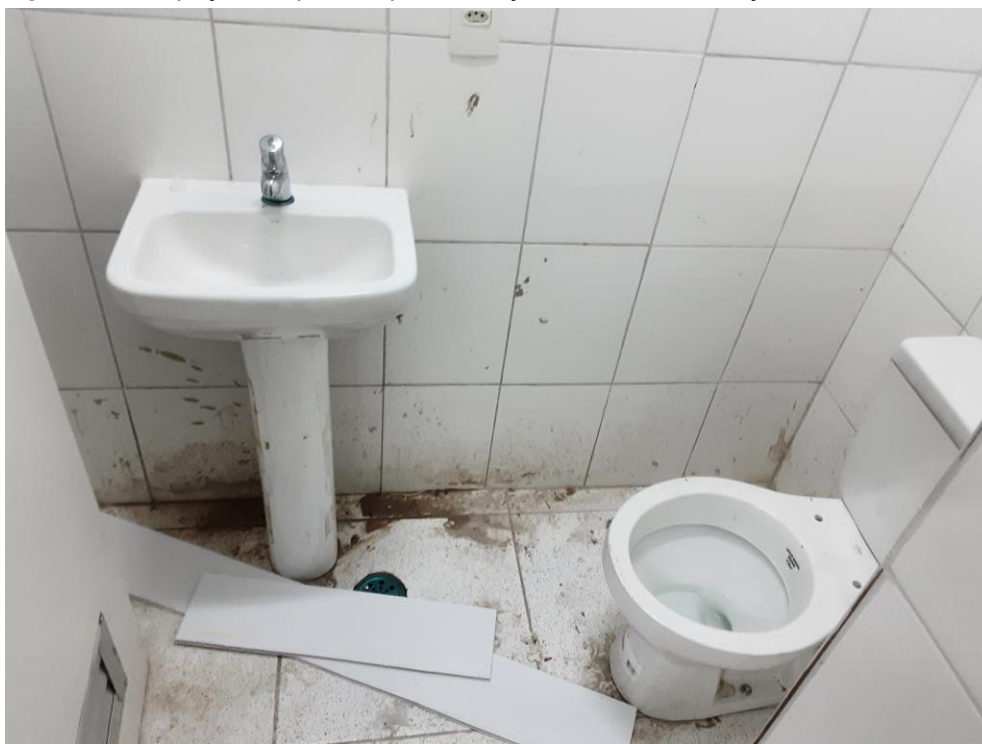
Figura 65 – Espaço indisponível por execução de obras e serviços.
