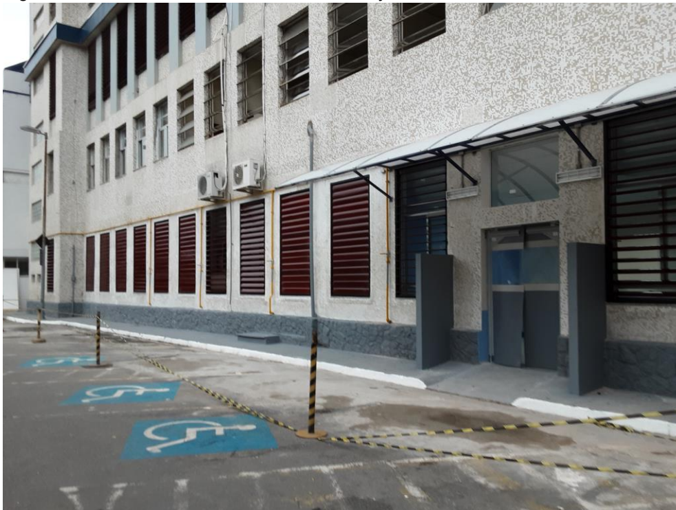
Figura 14 – Brises de alumínio instalados nas janelas.
