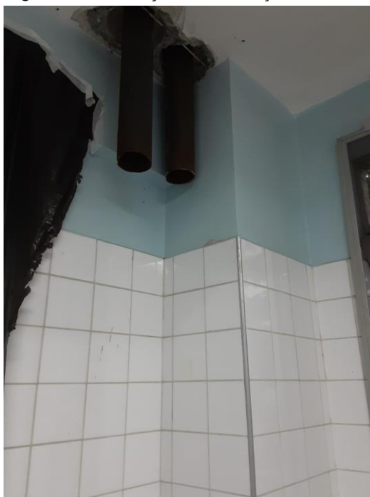
Figura 91 – Serviços de tubulação a realizar.
