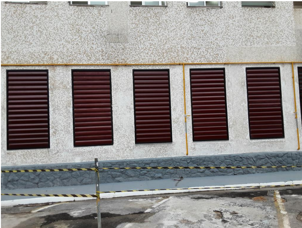
Figura 12 – Brises de alumínio instalados nas janelas.
