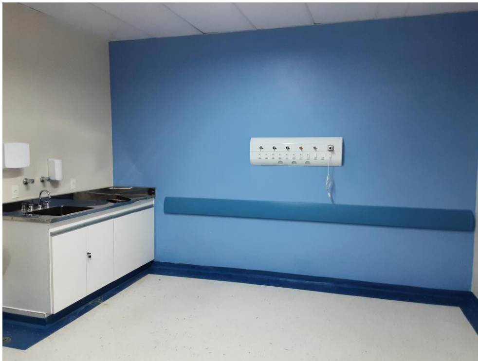
Figura 41 – Espaço com mobiliário, paredes pintadas e piso pós-reforma.
