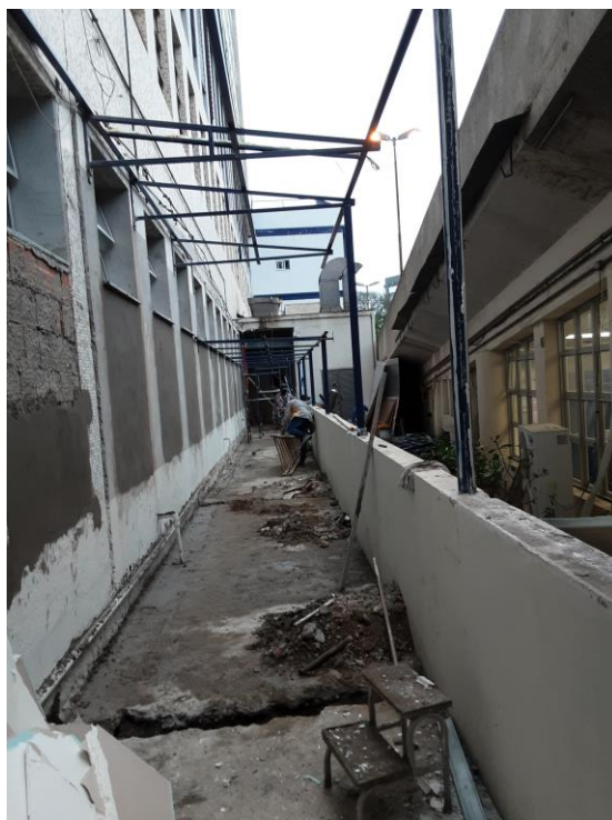
Figura 15 – Obras externas em execução.
