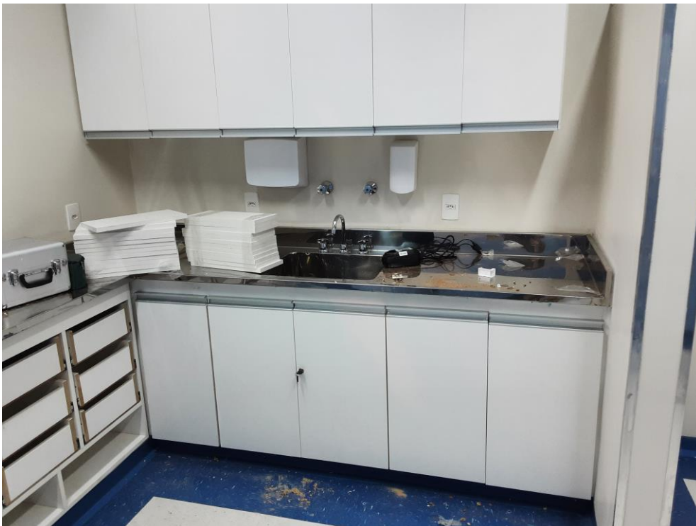
Figura 56 – Mobiliários em montagem.
