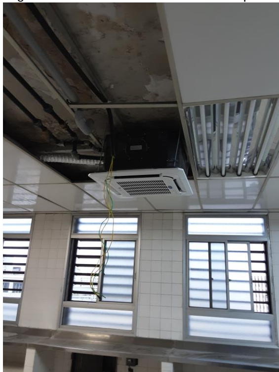
Figura 74 – Ar-condicionado central a implantar.
