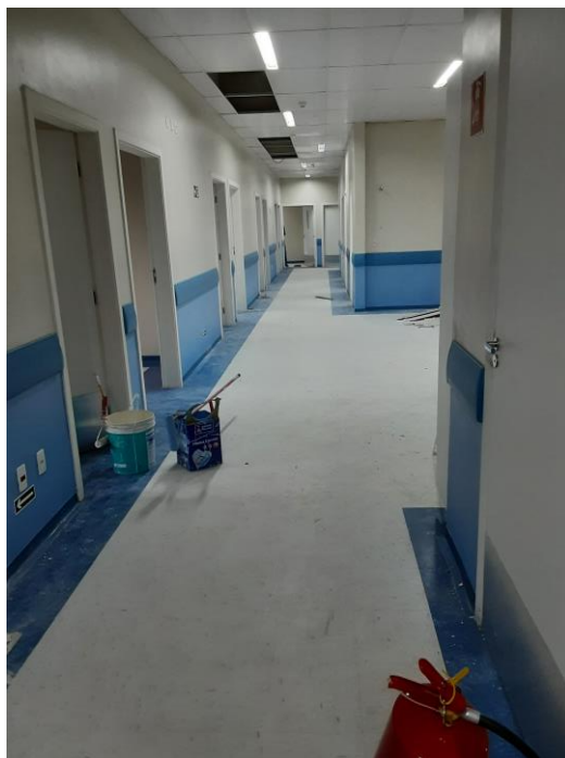
Figura 51 – Ala do Hospital ainda em obras.
