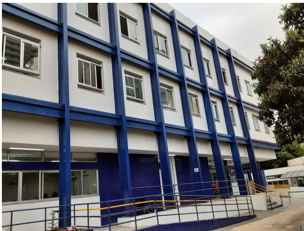
Figura 5 – Vista da fachada.
