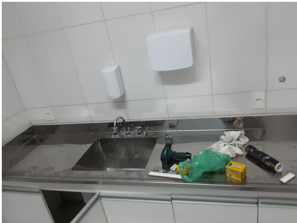
Figura 64 – Serviços a realizar e mobiliário em montagem.
