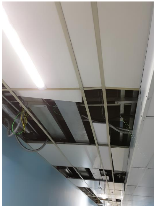
Figura 79 – Serviços de tubulação a realizar.
