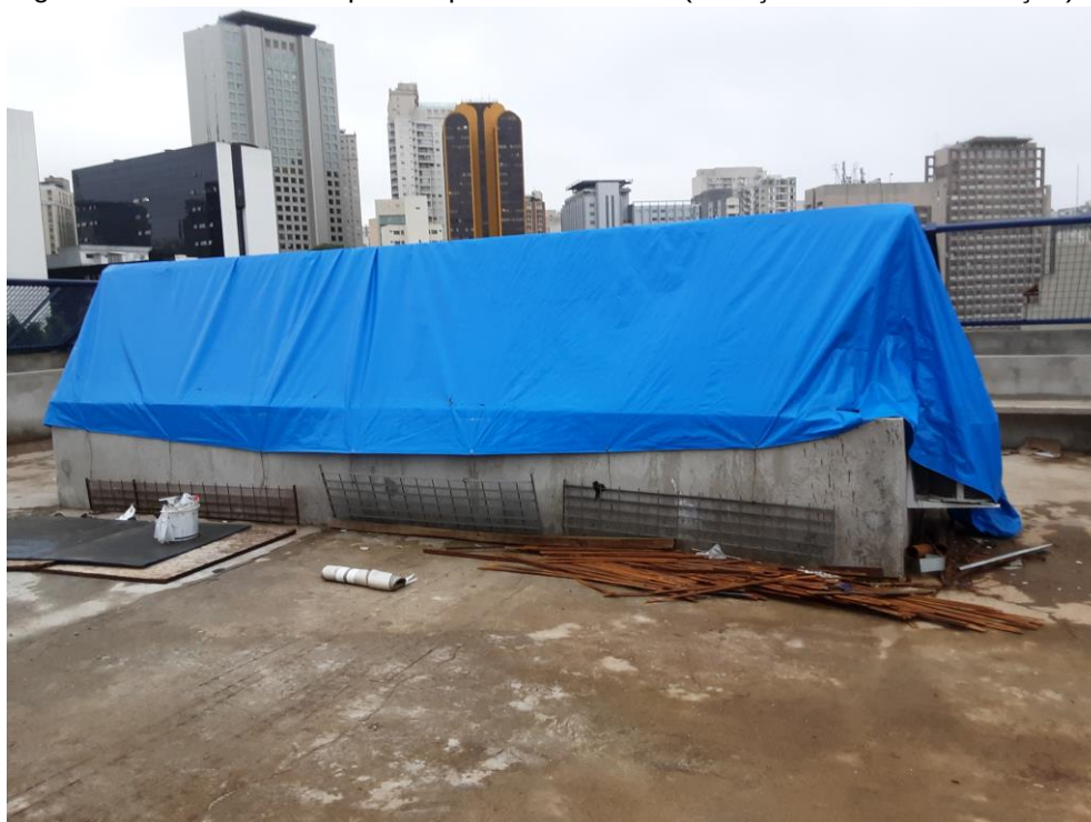
Figura 23 – Cobertura do prédio que foi construído (serviços ainda em execução).
