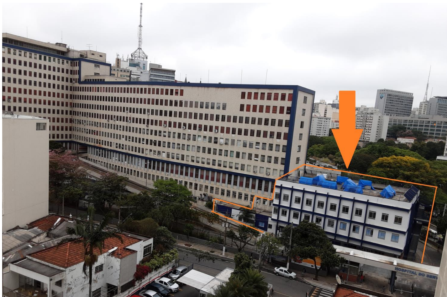
Figura 1 – Vista panorâmica do local onde os serviços de reformas e instalações estão sendo executados.
