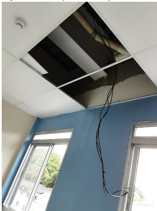
Figura 77 – Serviços de tubulação a realizar.
