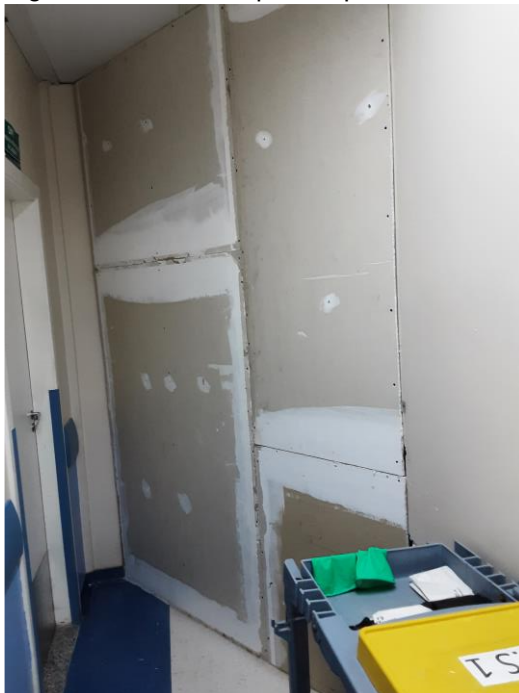
Figura 58 – Área bloqueada por obras.
