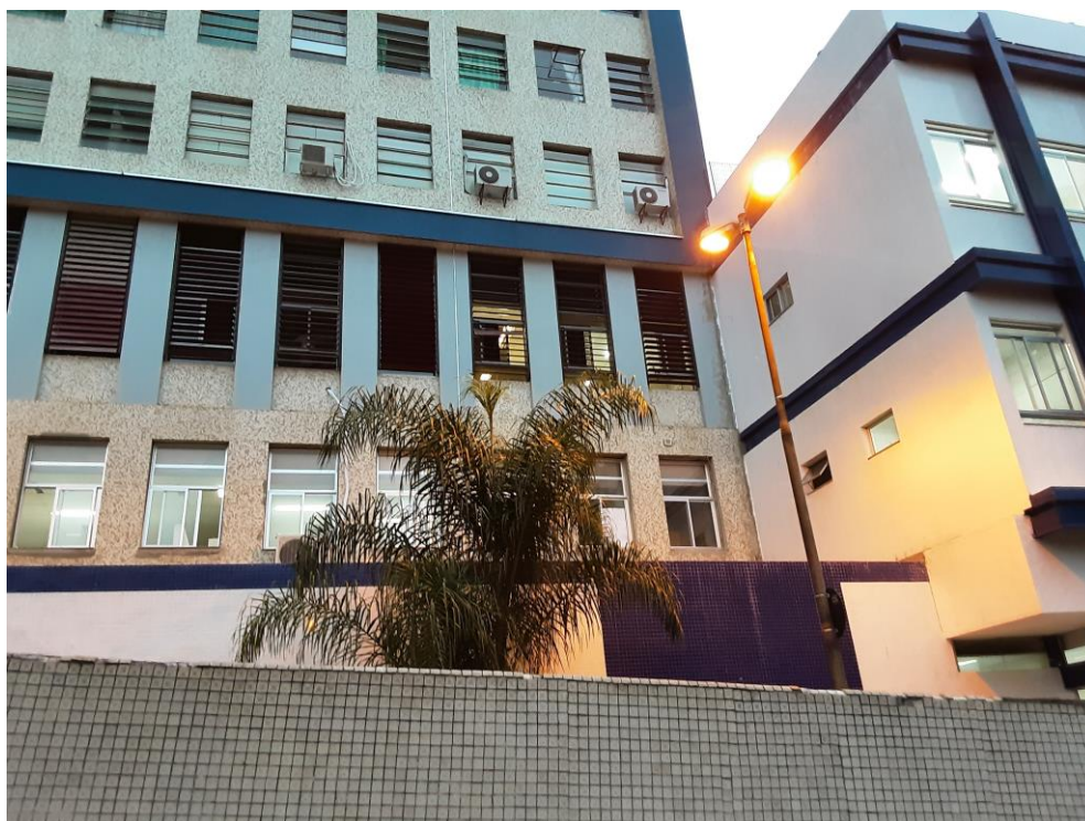
Figura 3 – Vista lateral da fachada.
