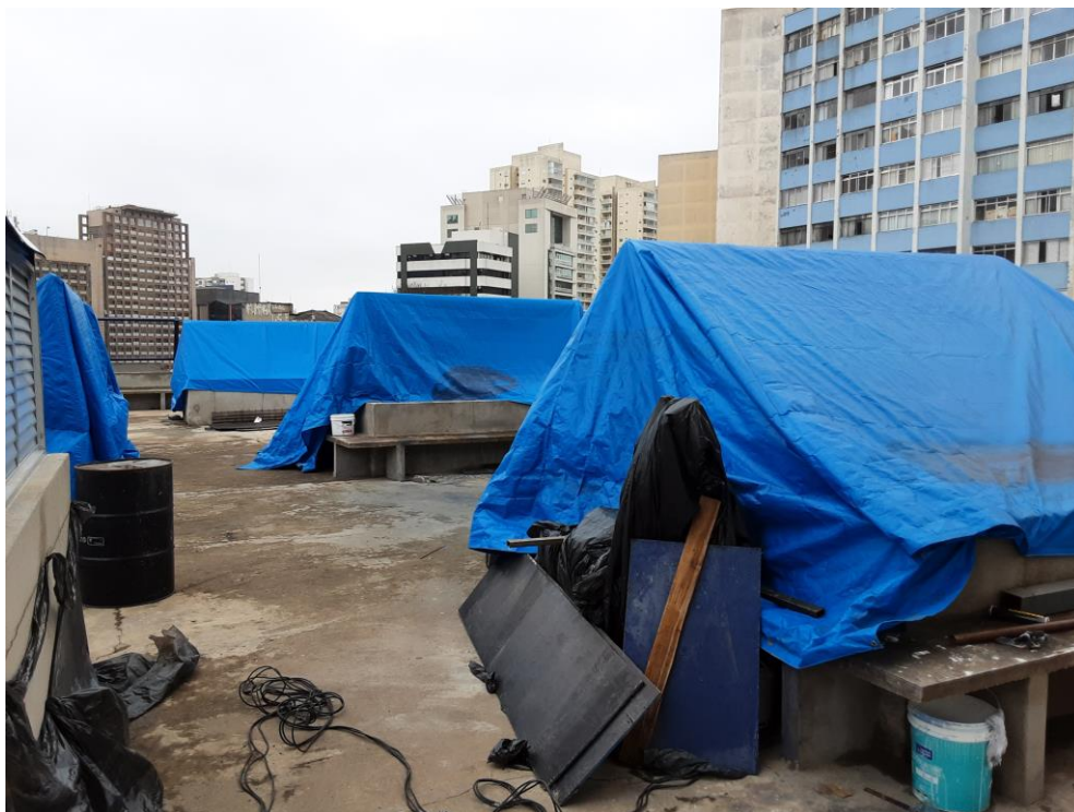
Figura 18 – Cobertura do prédio que foi construído (serviços ainda em execução).
