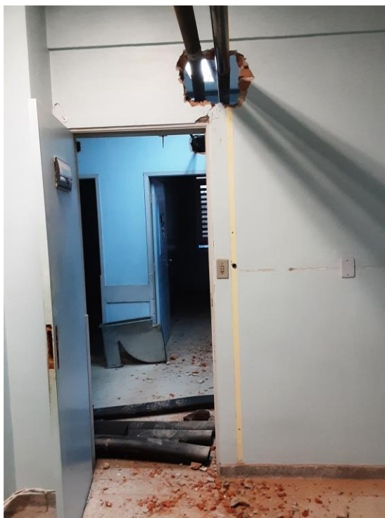
Figura 87 - Dutos do sistema de ar a implantar.
