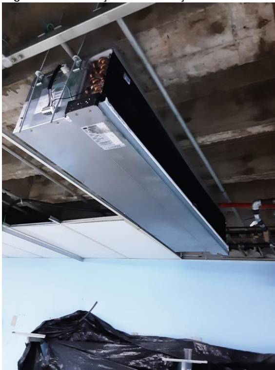
Figura 82 – Serviços de tubulação a realizar.
