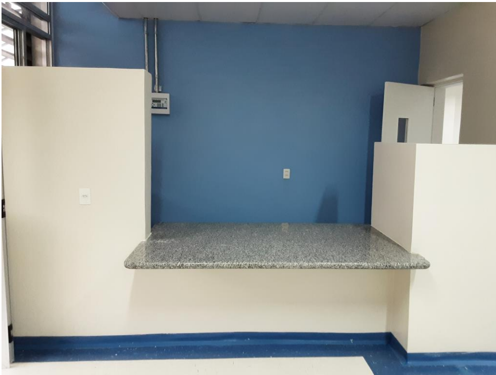
Figura 43 – Área (balcão) preparada para atendimento ao público pós-reforma.
