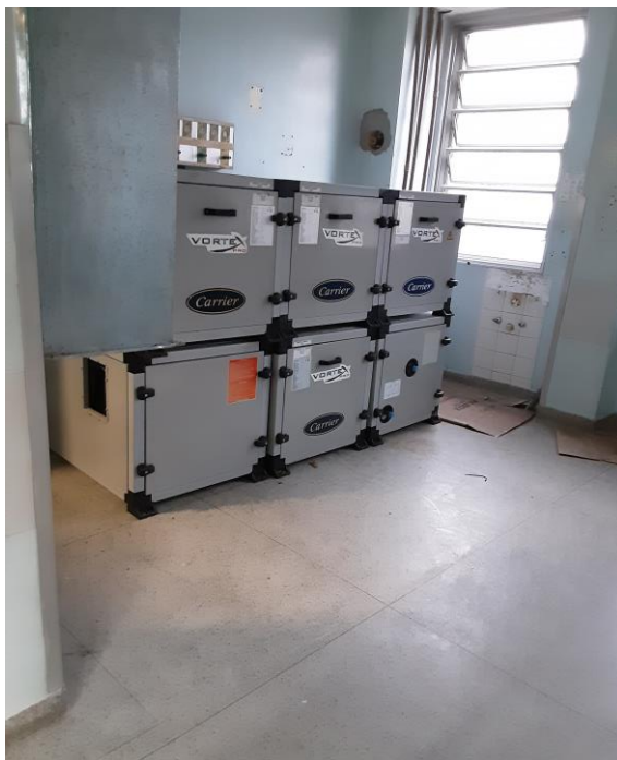
Figura 71 – Caixas do sistema de ar a implantar.
