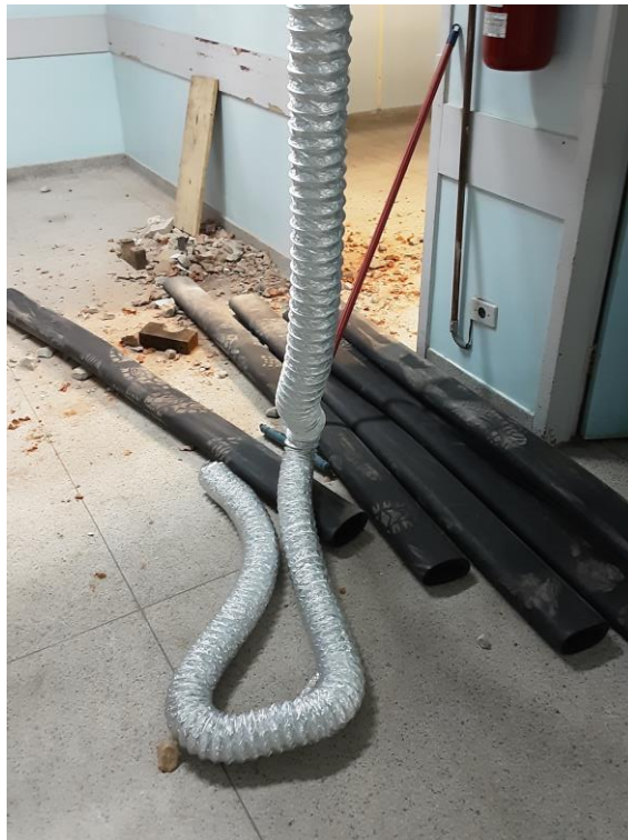
Figura 86 – Dutos do sistema de ar a implantar.
