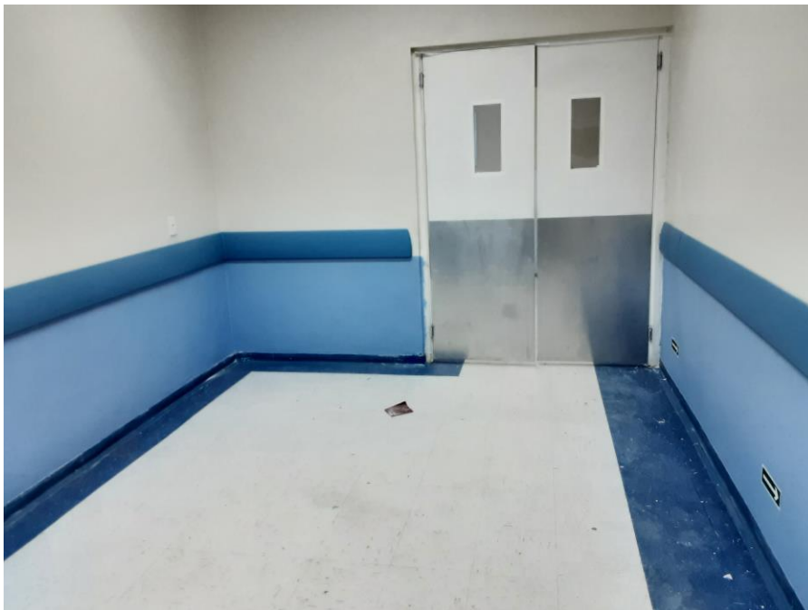
Figura 48 – Área do Hospital ainda em obras.
