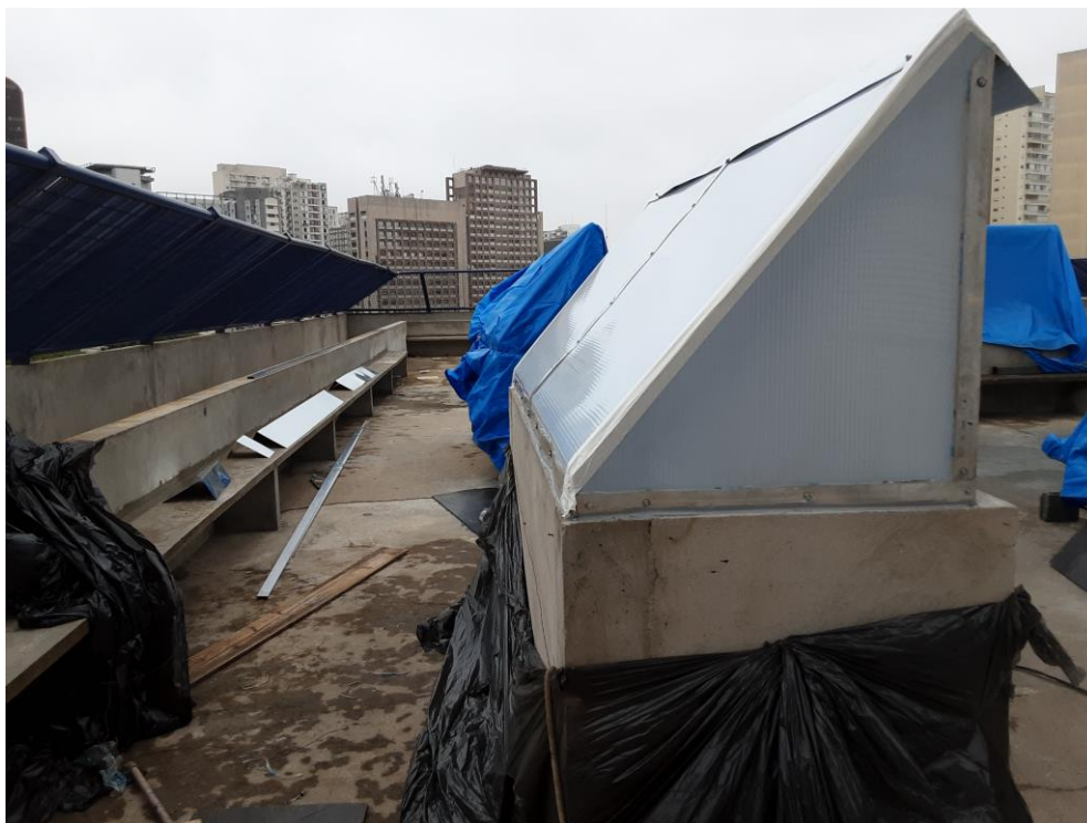
Figura 20 – Cobertura do prédio que foi construído (serviços ainda em execução).
