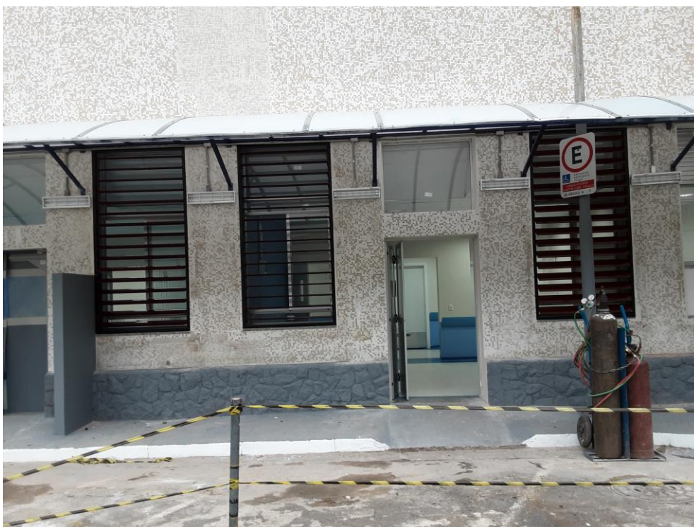
Figura 11 – Vista da fachada oposta à entrada do Complexo.
