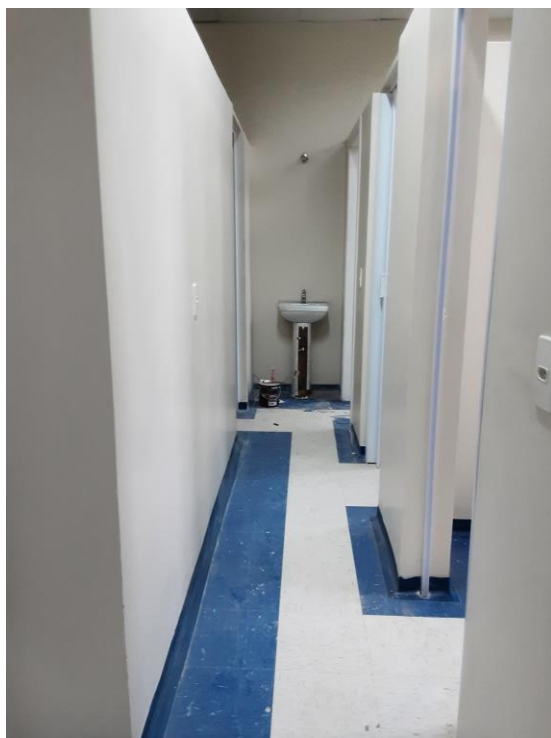
Figura 50 – Área do Hospital ainda em obras.
