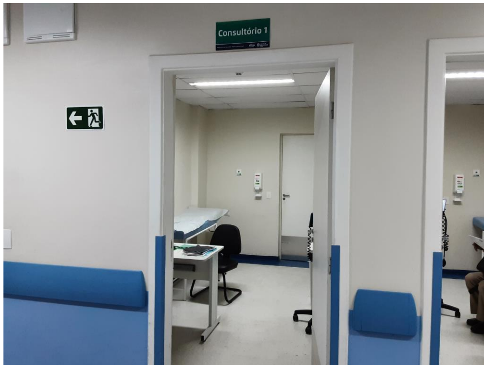
Figura 31 – Visão da entrada dos consultórios pós-reforma.
