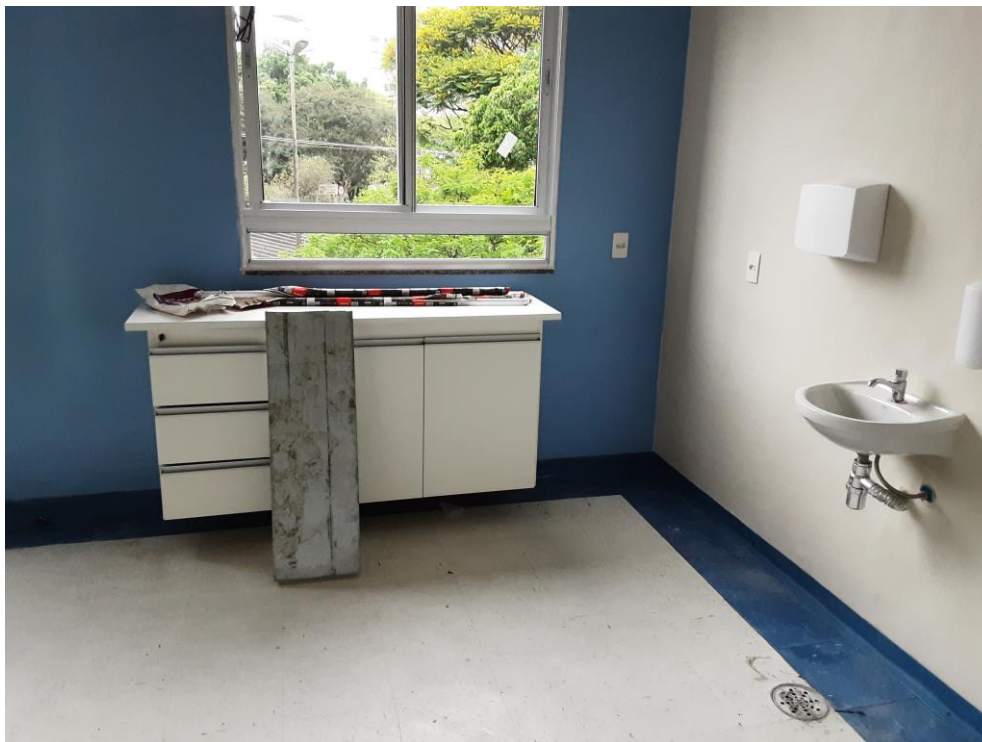
Figura 62 – Área em reforma e mobiliário em montagem.
