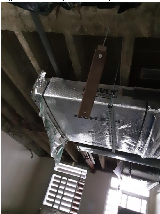
Figura 83 – Serviços de tubulação a realizar.
