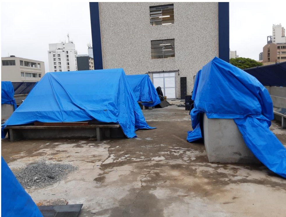
Figura 24 – Cobertura do prédio que foi construído (serviços ainda em execução).
