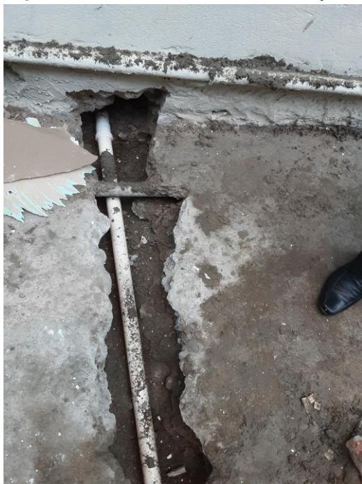
Figura 16 – Obras externas em execução.
