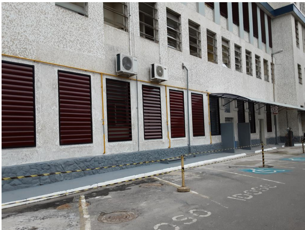
Figura 13 – Brises de alumínio instalados nas janelas.
