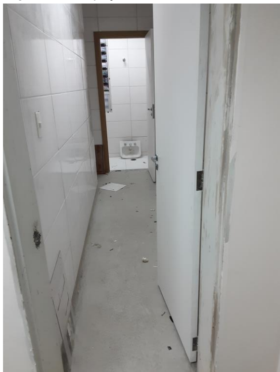
Figura 54 – Espaço ainda em obras.
