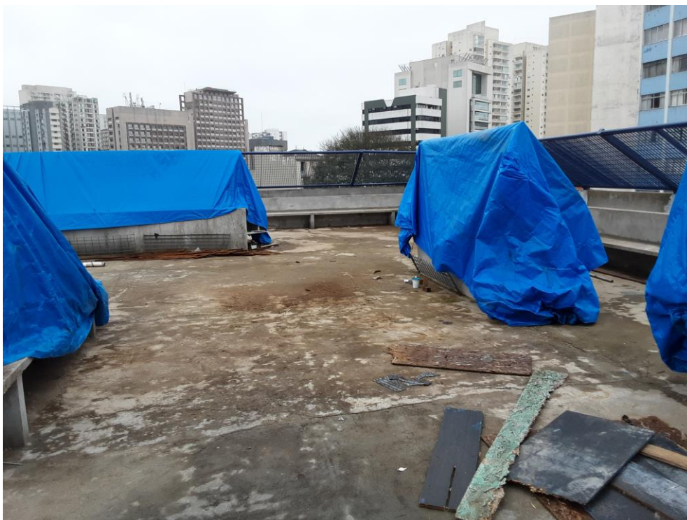
Figura 22 – Cobertura do prédio que foi construído (serviços ainda em execução).
