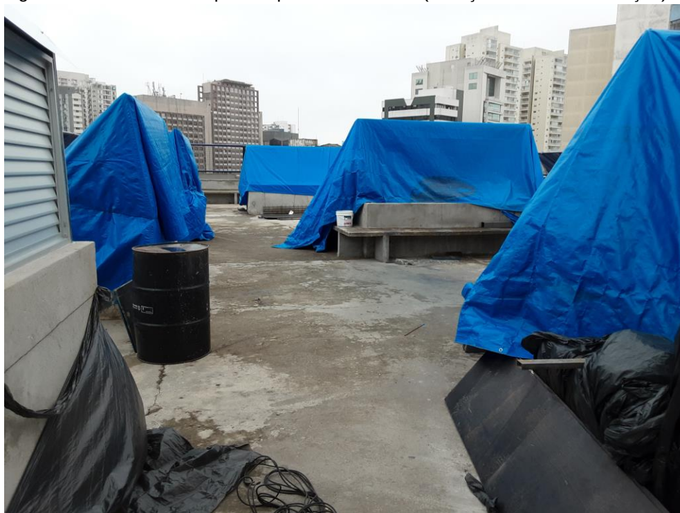
Figura 21 – Cobertura do prédio que foi construído (serviços ainda em execução).
