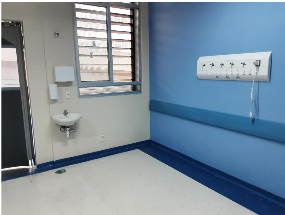
Figura 39 – Espaço com paredes pintadas e piso pós-reforma.
