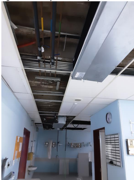
Figura 80 – Serviços de tubulação a realizar.
