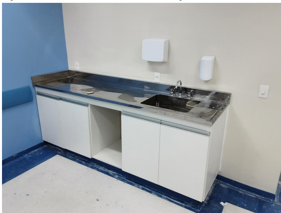
Figura 61 – Área em reforma e mobiliário em montagem.
