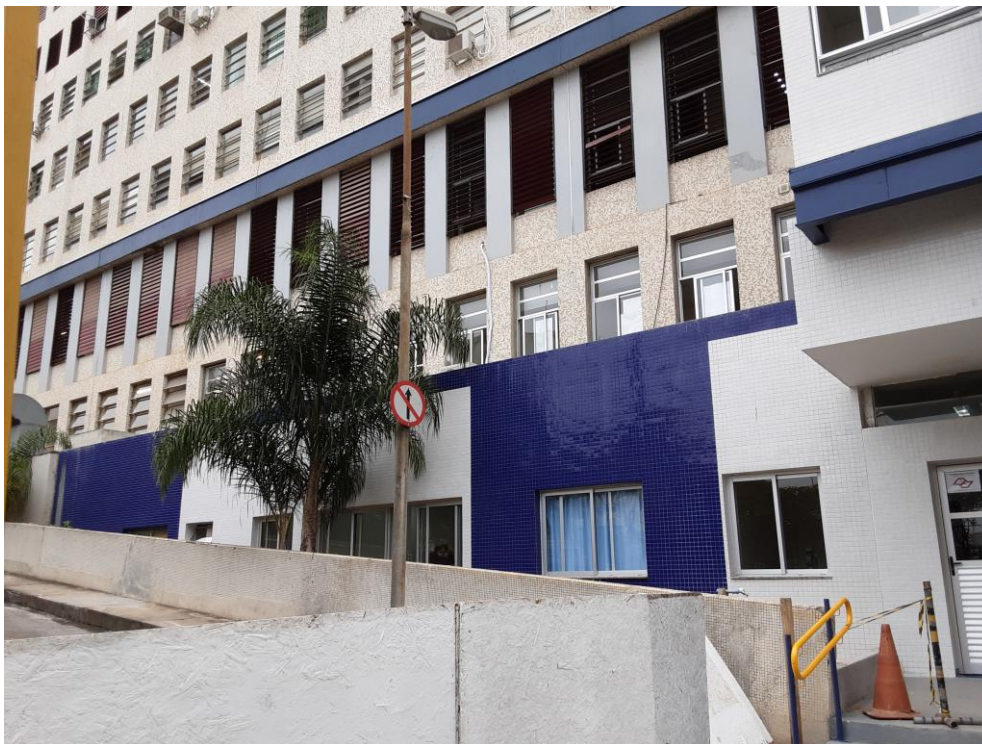
Figura 4 – Vista de parte da fachada e da janela da sala de acupuntura em reforma.
