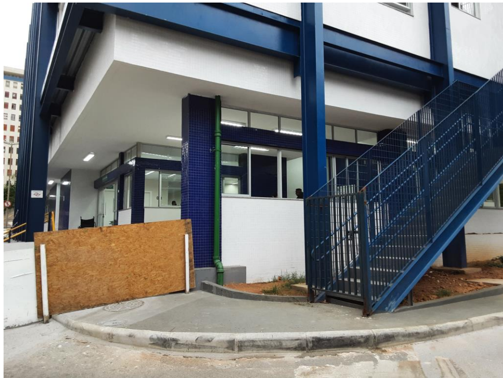
Figura 6 – Vista da escada e estruturas metálicas.
