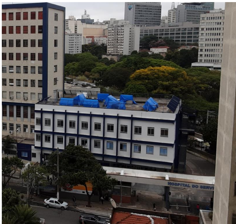
Figura 17 – Visão panorâmica da cobertura do prédio construído.
