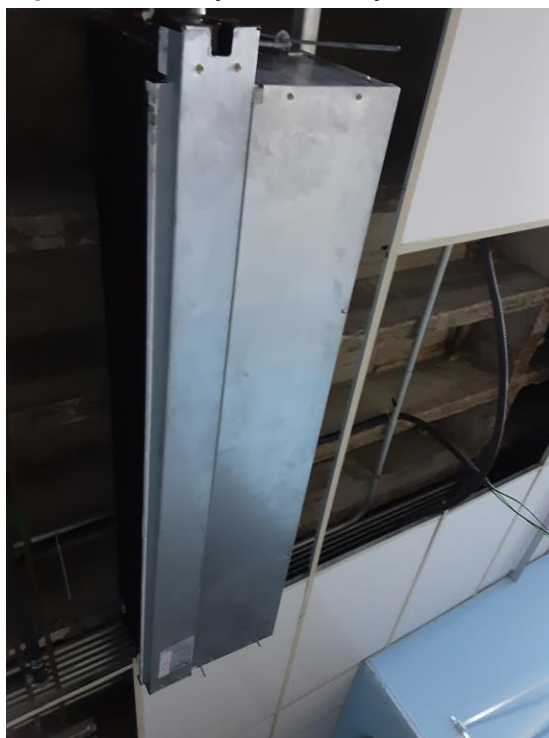
Figura 81 – Serviços de tubulação a realizar.
