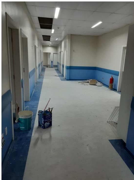
Figura 52 – Ala do Hospital ainda em obras.
