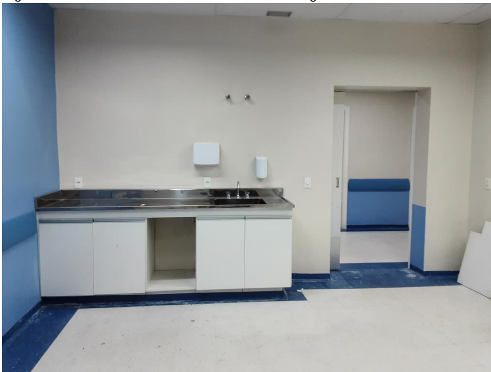
Figura 59 – Área em reforma e mobiliário em montagem.
