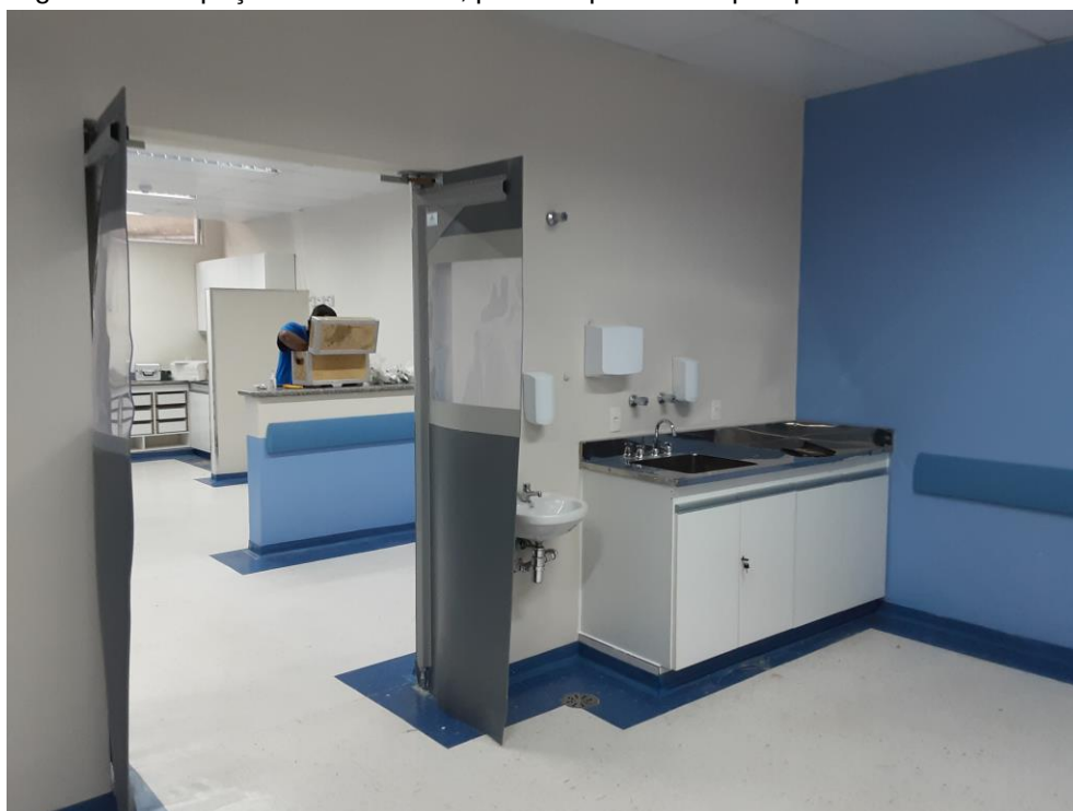
Figura 40 – Espaço com mobiliário, paredes pintadas e piso pós-reforma.
