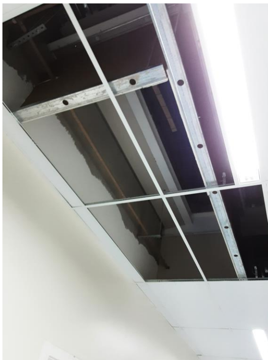
Figura 78 – Serviços de tubulação a realizar.
