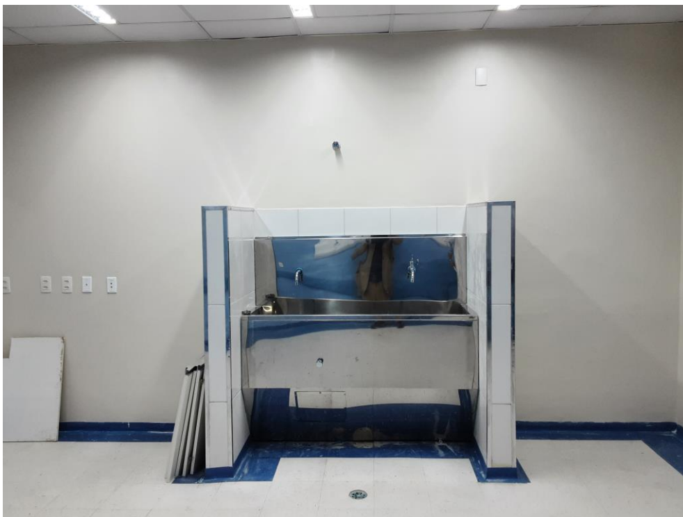
Figura 60 – Área em reforma e mobiliário em montagem.
