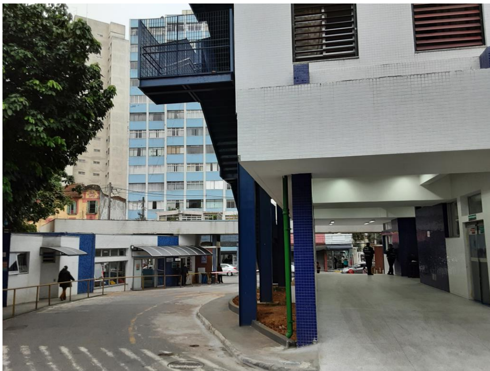
Figura 8 – Vista da escada e estruturas metálicas (visão da entrada do Complexo).
