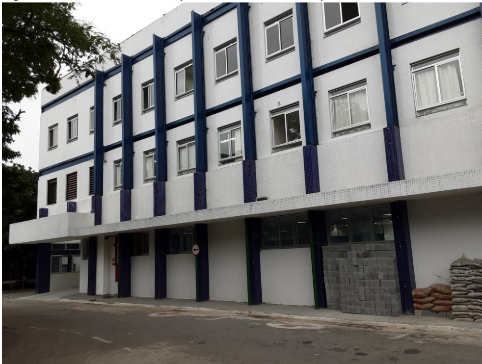
Figura 10 – Vista da fachada oposta à entrada do Complexo.
