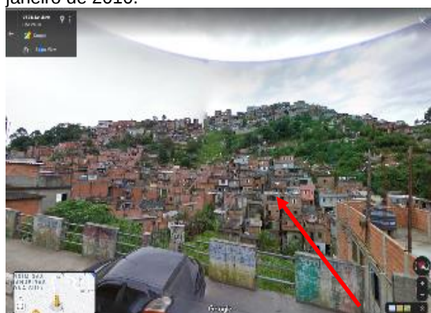
Figura 15 – Vista da Av. Alda das construções em alvenaria na parte montante do córrego Saúde, em janeiro de 2010.
