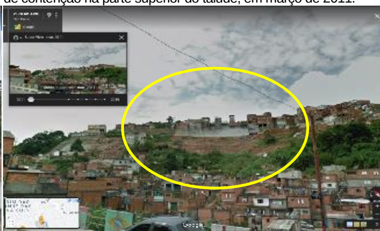
Figura 16 – Vista da Av. Alda das construções em alvenaria na parte montante do córrego Saúde com início da execução de obras de contenção na parte superior do talude, em março de 2011.
