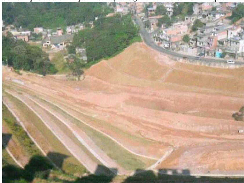
Figura 20 – Vista aérea geral da parte montante do córrego Saúde após os serviços de contenção e terraplanagem constante na medição nº 02.
