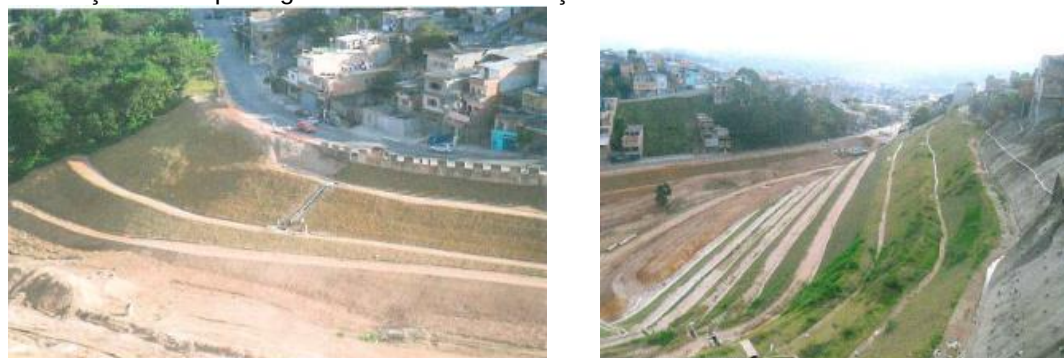
Figura 19 – Vista aérea da parte montante do córrego Saúde após os serviços de contenção e terraplanagem constante na medição nº 02 do Contrato nº 026/SEHAB/2012.
