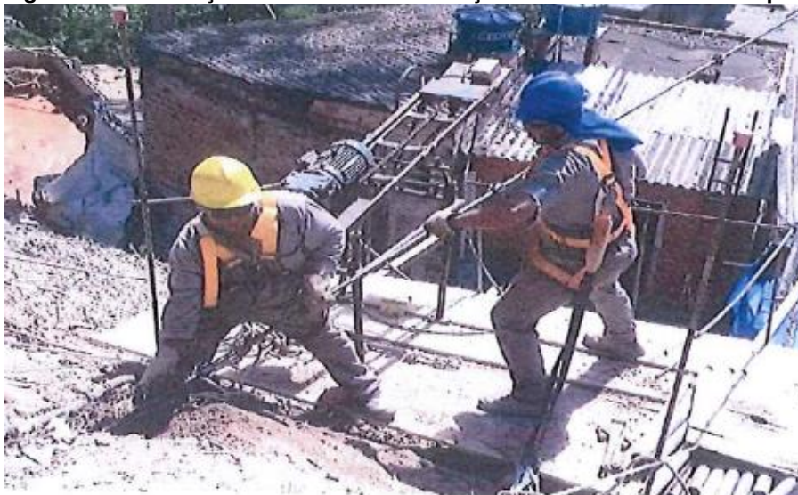
Figura 07 – Execução do chumbador de aço na Área 262 – Jardim Apurá
