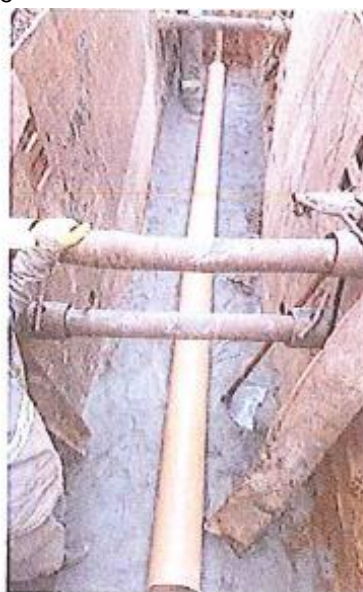
FOTO 7 ÁREA: 253 SERVIÇO: EXECUÇÃO DA REDE DE ESGOTO LOCAL: AVENIDA DOUTOR MASSAU
